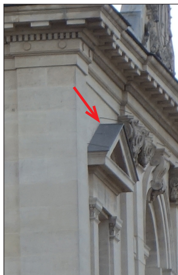
COUVERTINE EN ZINC AU DROIT DES FRONTON ET VÉTUSTÉ DU SYSTÈME ANTI-VOLATILE
