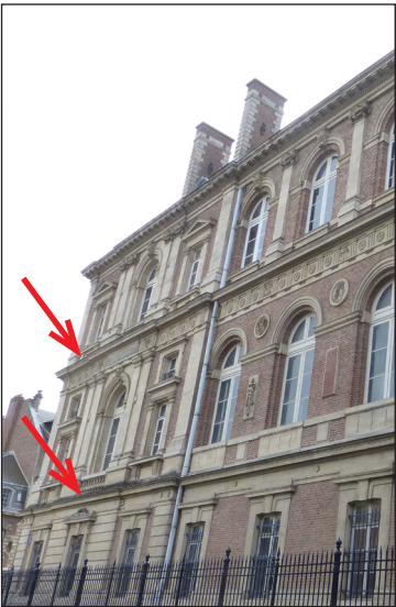
COUVERTINE EN ZINC AU DROIT DES BANDEAUX EN SAILLIE
