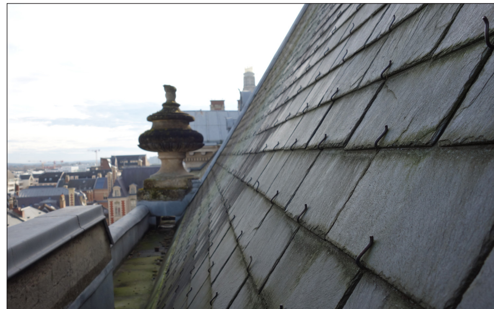
Bris en ardoises posées au crochet
