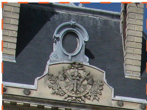
Type de grande lucarne (B), ovale eoeil de boeuf, présent sur les pans de toitures des pavillons d'angle
