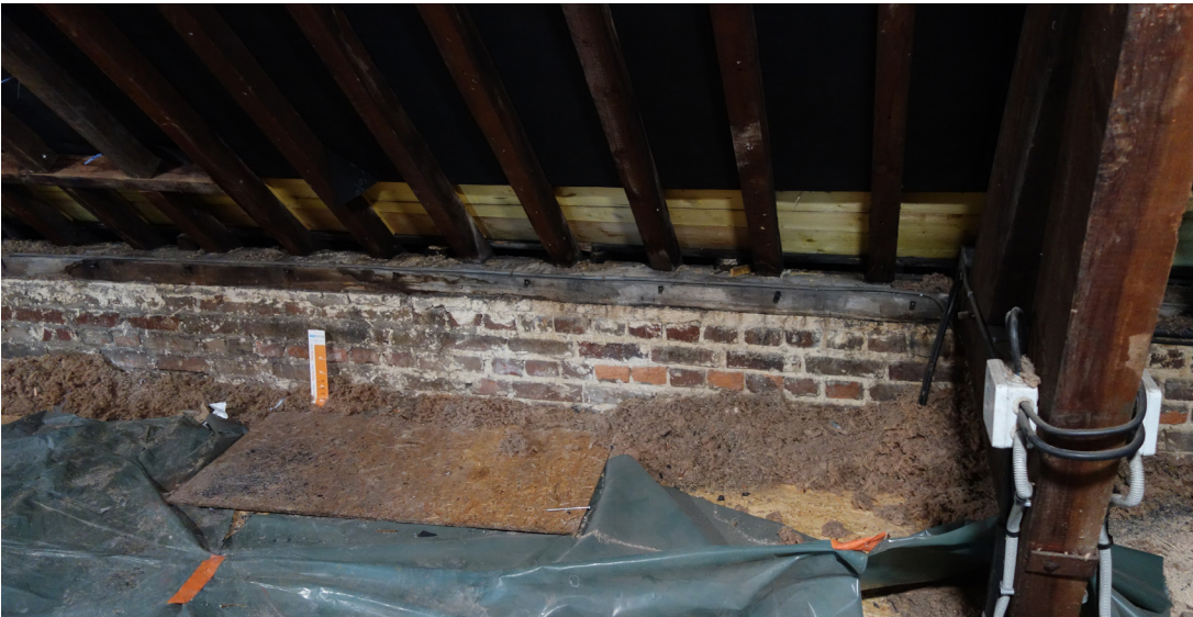
Lacune d'isolant à compléter
