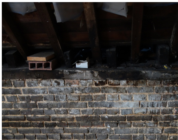
Trace d'humidité sur la maçonnerie des murs d'arases
