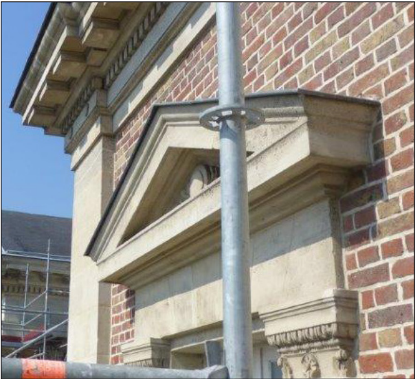
COUVERTINE EN ZINC AU DROIT DES FRONTONS TRIANGULAIRES
