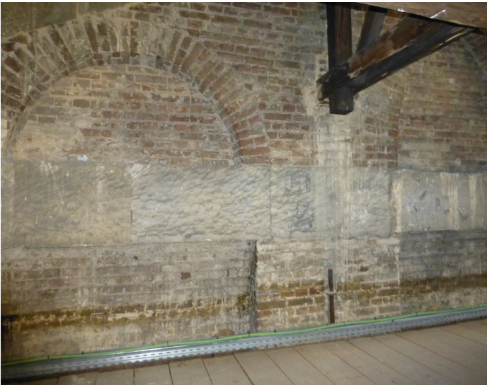
Mur de refend en brique Baie avec arc en plein cintre comblé
