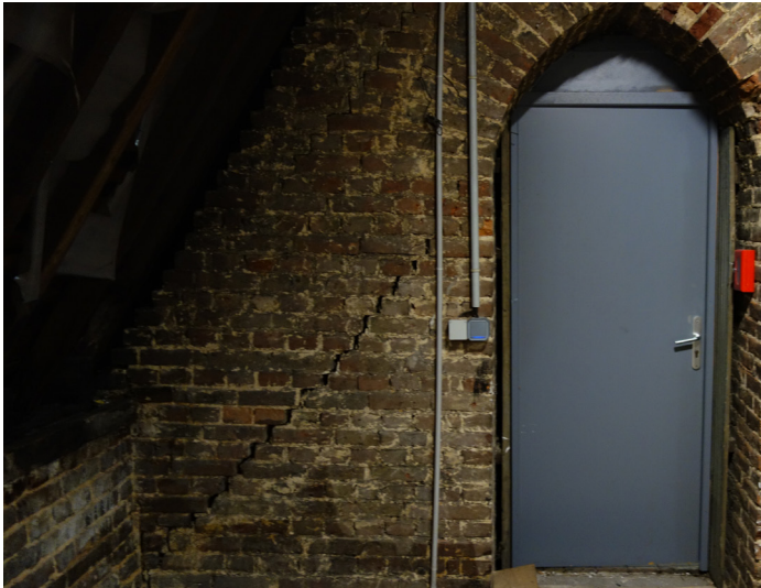
Fissure sur mur de refend
