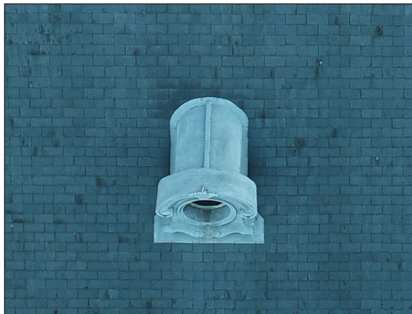
EXEMPLE DE PROTECTION DES PETITES LUCARNES EN OEIL DE BOEUF EN ZINC
