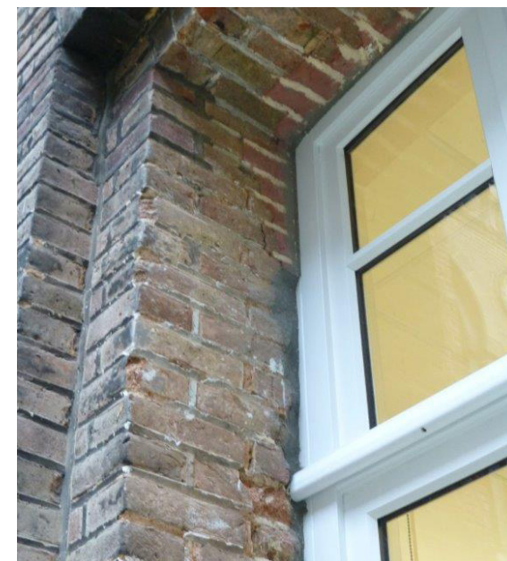
ALTÉRATION DES JOINTS ET USAGE DE DIFFÉRENTES NATURES DE BRIQUES, PURGE DES JOINTS, RÉFECTION À LA CHAUX
