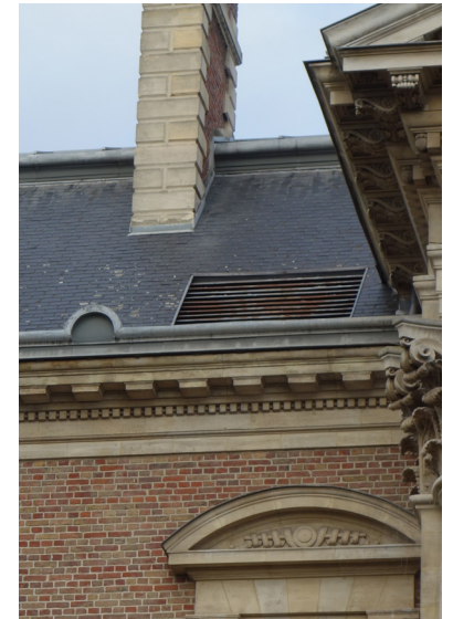
Remplacement de la grille de ventilation façade Est
