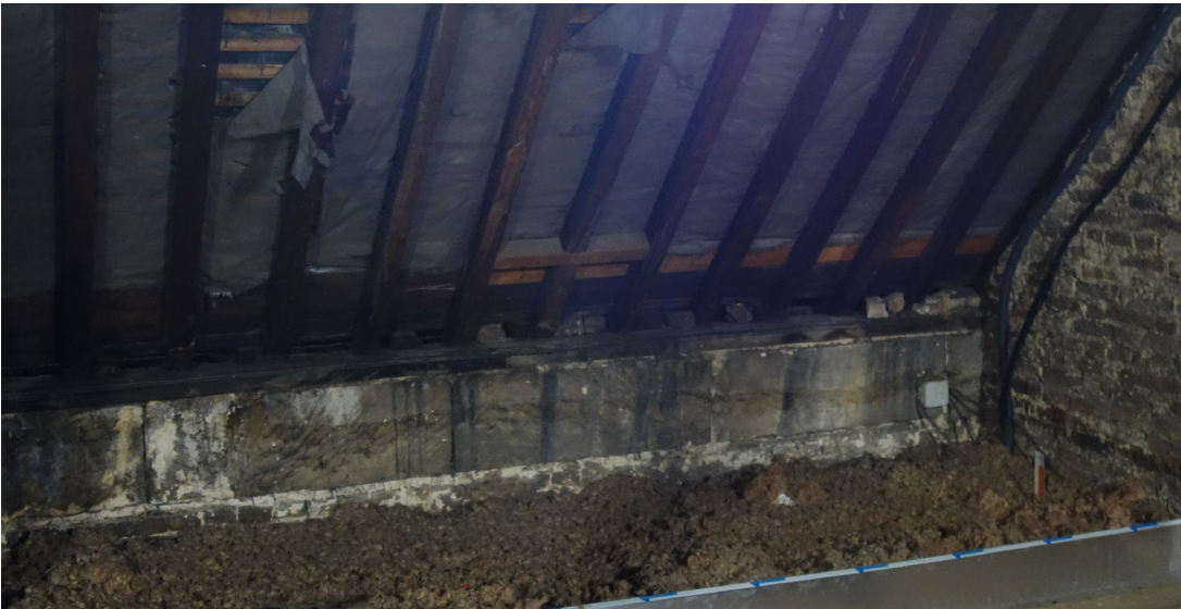
Humidité des pannes sablières, à remplacer ponctuellement selon état sanitaire
