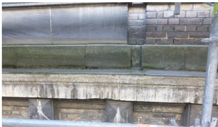
ALTÉRATION DES BANDEAUX, PERTE DE MATIÈRE ET ENCRASSEMENT GÉNÉRALISÉ
