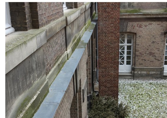
DÉPOSE EN DÉMOLITION DES PROTECTIONS ZINC ET RÉFECTION À L'IDENTIQUE
