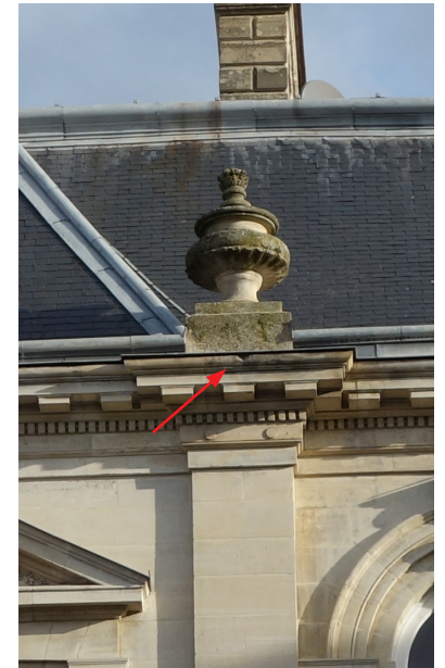
Perte de matière au niveau de la corniche sur cour d'honneur
