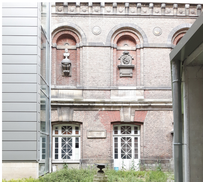
USAGE DE BRIQUES DE DIFFÉRENTE NATURE À PURGER ET RESTITUTION AVEC BRIQUES DE MÊMES CARACTÉRISTIQUES
