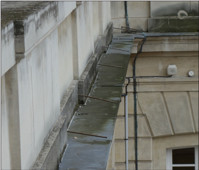
VÉTUSTÉ DE LA COUVERTINE EN ZINC AU DROIT DES BANDEAUX EN SAILLIE - DÉGRADATION DU SOLIN - INEFFICACITÉ DU SYSTÈME ANTI-VOLATILE
