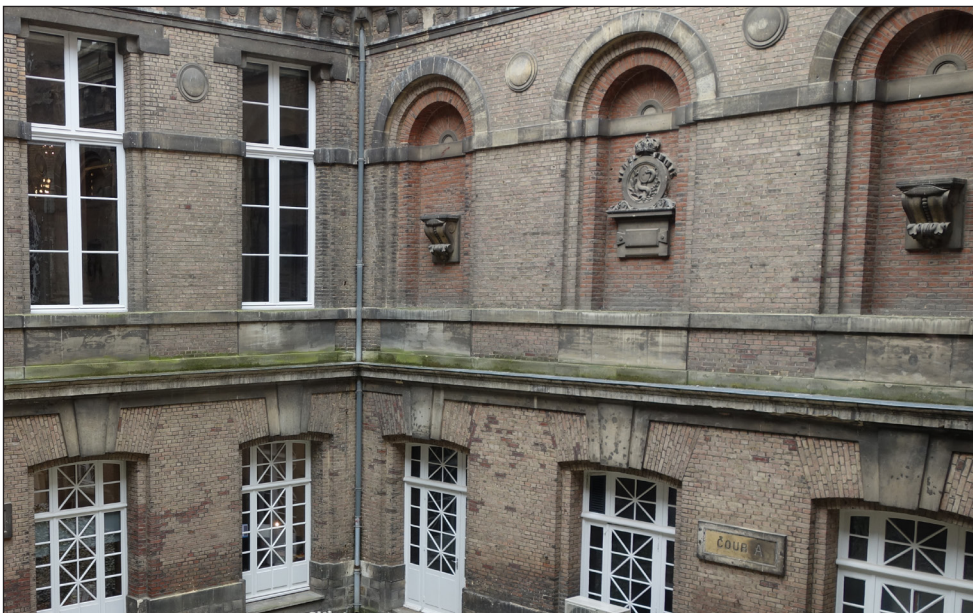
CONSOLES DE LA COUR A, SANS BUSTES, BRIQUE DE REMPLISSAGE DES BAIES DE NATURE DIFFÉRENTE DE CELLE DU RESTE DE LA FAÇADE
