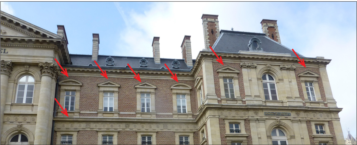
COUVERTINE EN ZINC AU DROIT DES BANDEAUX EN SAILLIE, DES FRONTONS TRIANGULAIRES ET DE CEUX À ARC À ANSE DE PANIER
