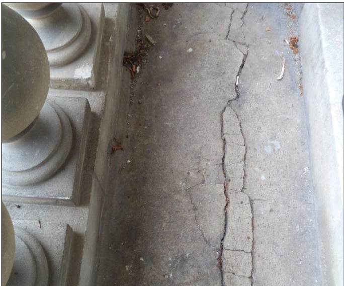
RÉPARATION DU SOL FRACTURÉ PAR INJECTION, POSITION D'UNE PISSETTE
