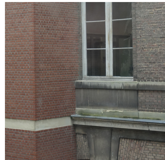
DESQUAMATION DE CERTAINES PIERRES À REMPLACER
