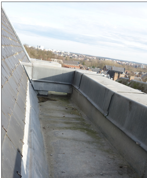
Les chéneaux (y compris la fonçure) sont recouverts de zinc et dotés de trop plein.
