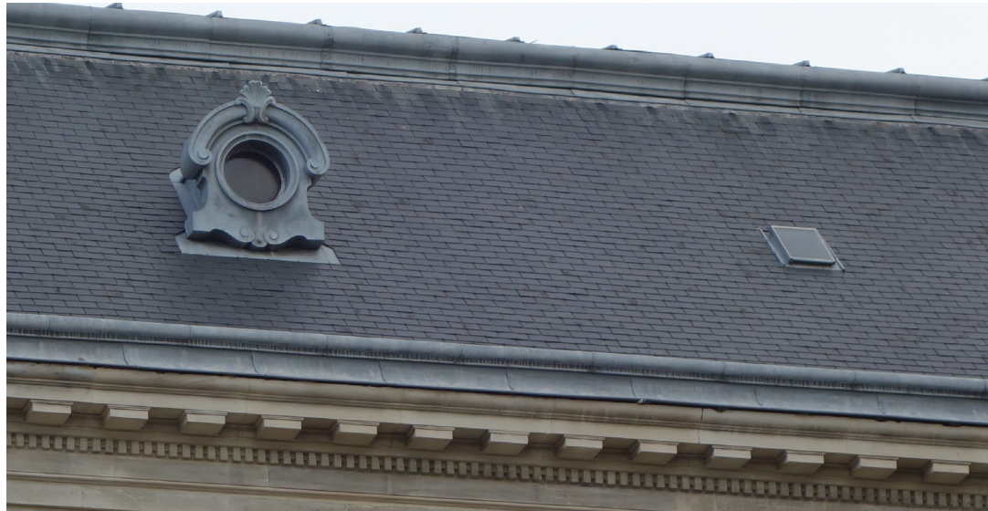
Lucarne et tabatière existantes (sur cour d'honneur). La restitution des lucarnes en remplacement des tabatières est préconisée pour restituer le rythme originel des façades, comme visible sur les cartes postales
