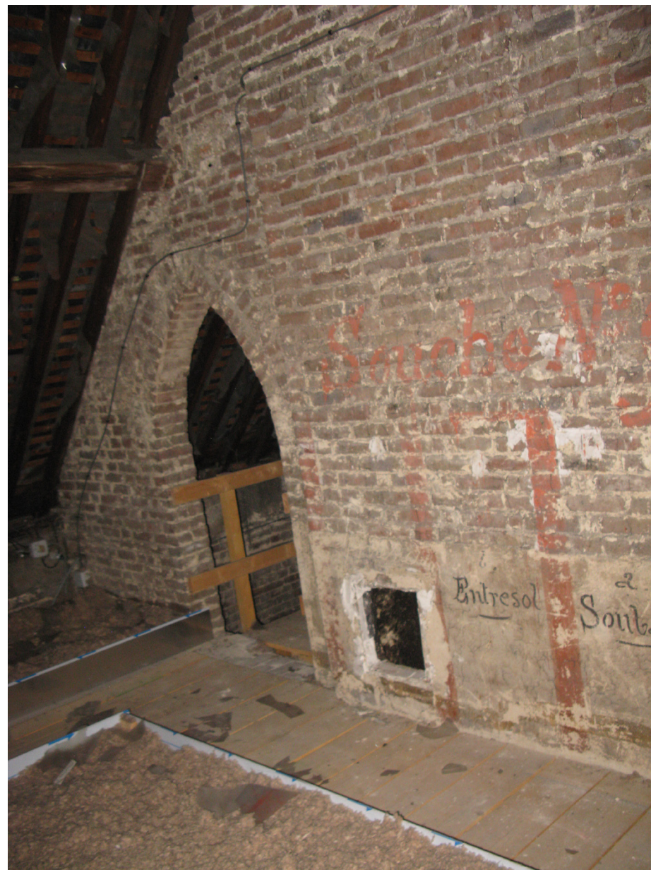
Mur de refend en brique - Baie avec arc brisé
