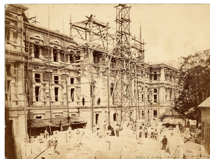
1868-1870 Vue générale du chantier de construction du Palais de justice d'Amiens échafaudages aménagés sur la façade sud
