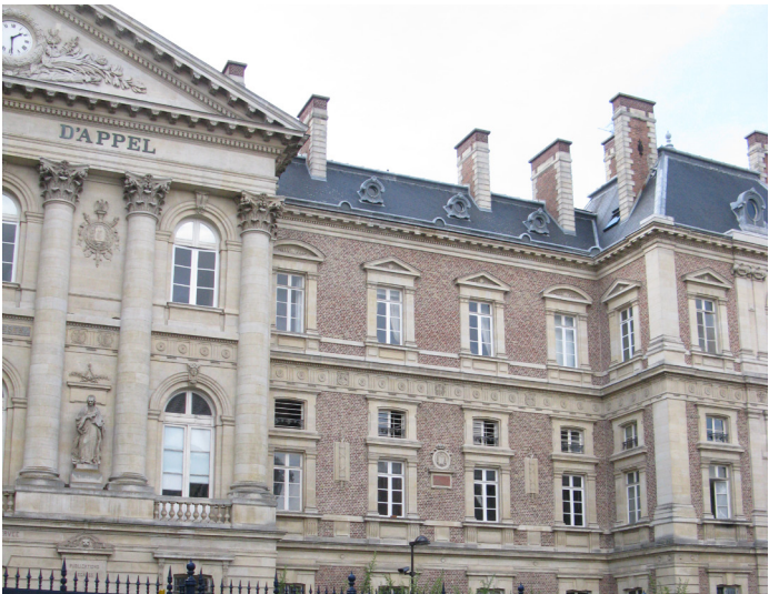
Façade rue Victor Hugo, maçonnerie de brique et de pierre de taille
