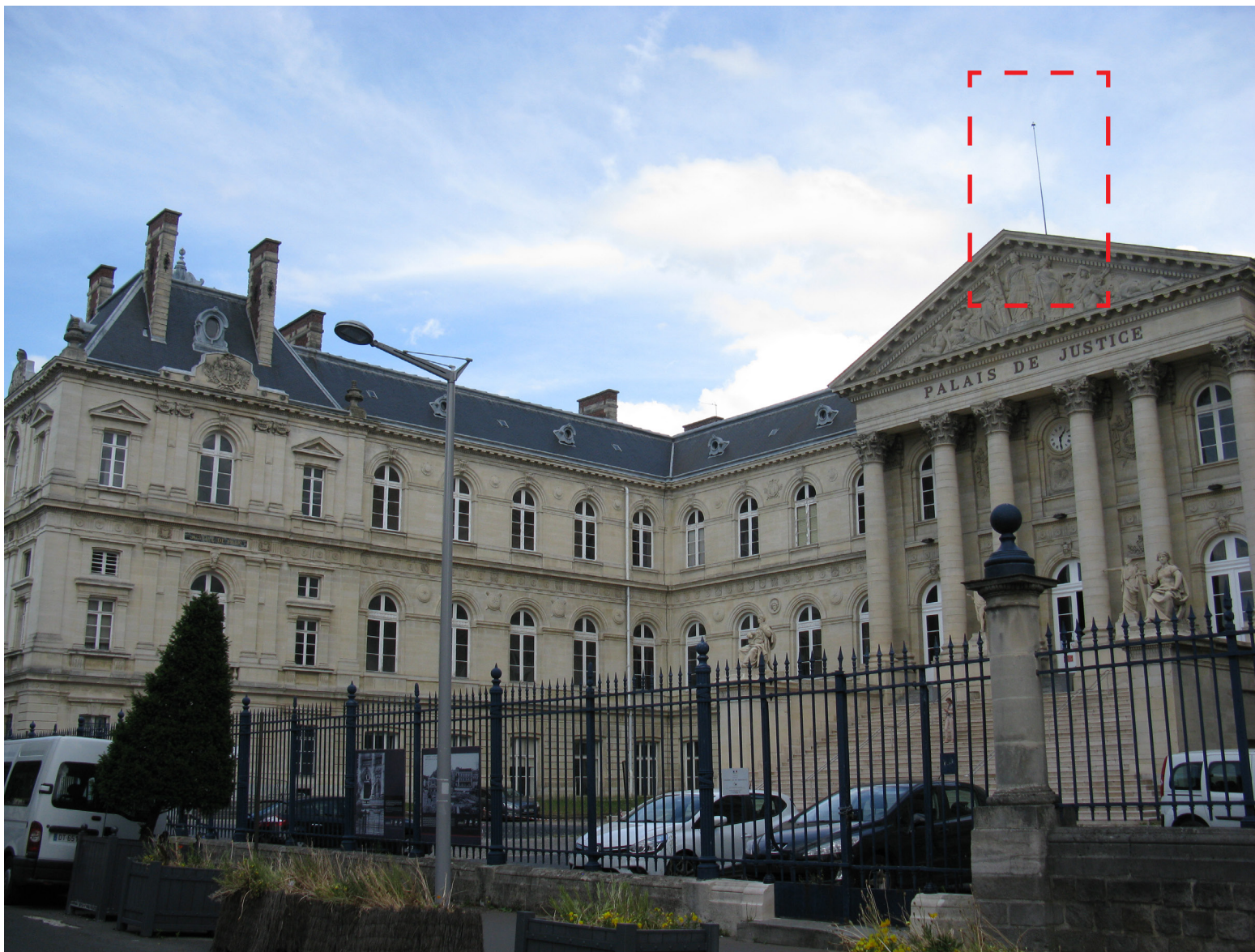
L'unique paratonnerre est présent sur le faîtage du fronton Ouest.
