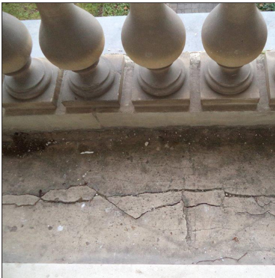
SOL FRACTURÉ À RESTAURER ET À PROTÉGER PAR UNE COUVERTINE EN PLOMB, POSITION D'UNE PISSETTE
