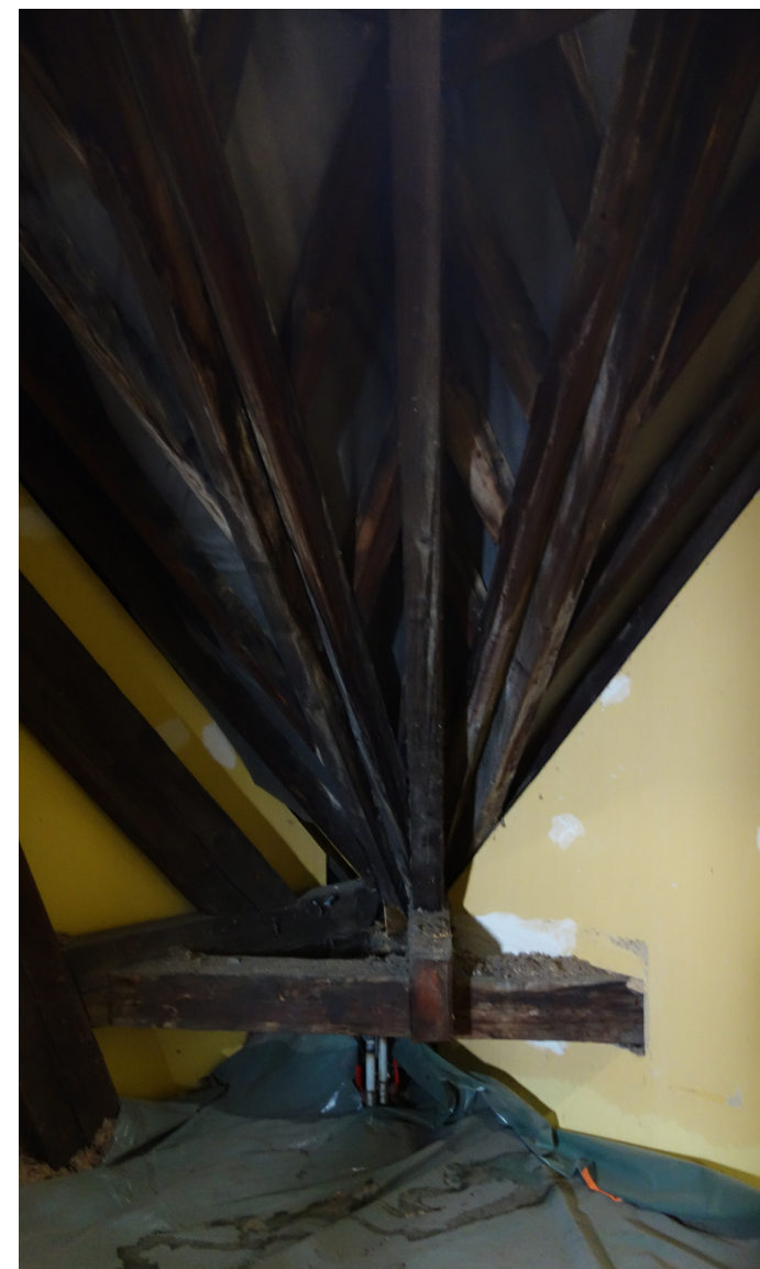
Assemblage aux noues
