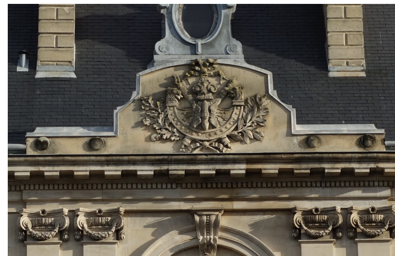
DÉCOR SCULPTÉS DES FRONTONS À NETTOYER, PAR MICRO ABRASION APRÈS TEST DE CONVENANCE
