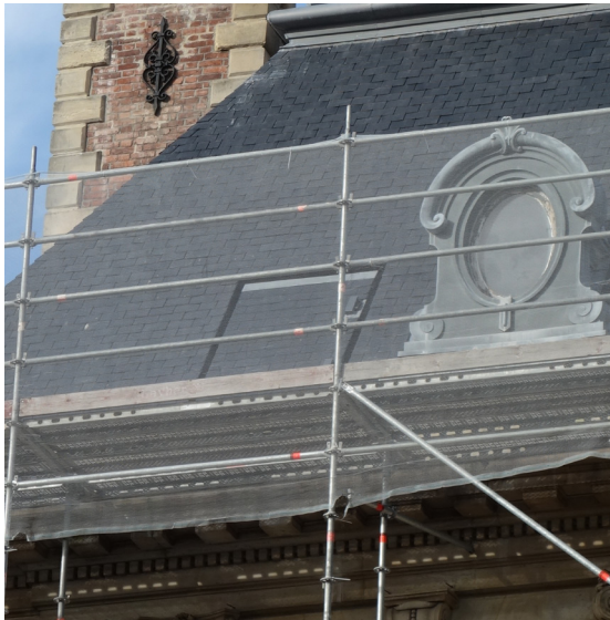
Châssis pour accès pompier en toiture, état existant sur l'aile sud donnant rue Hugo
