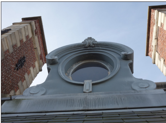
EXEMPLE DE PROTECTION DES GRANDES LUCARNES EN OEIL DE BOEUF EN ZINC
