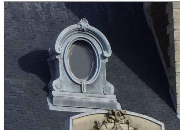
VÉTUSTÉ DE LA PROTECTION EN ZINC DES GRANDES LUCARNES EN OEIL DE BOEUF
