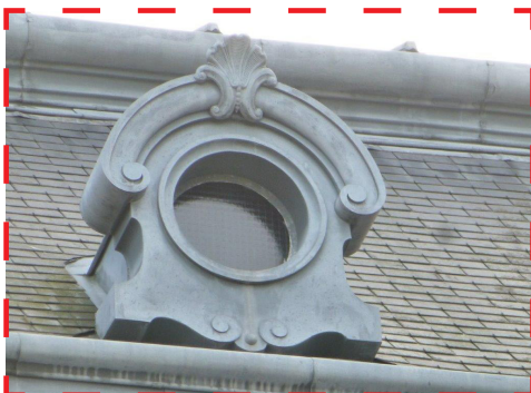
Type de petite lucarne (A), ronde en oeil de boeuf, présent sur les pans de toitures donnant sur l'extérieur
