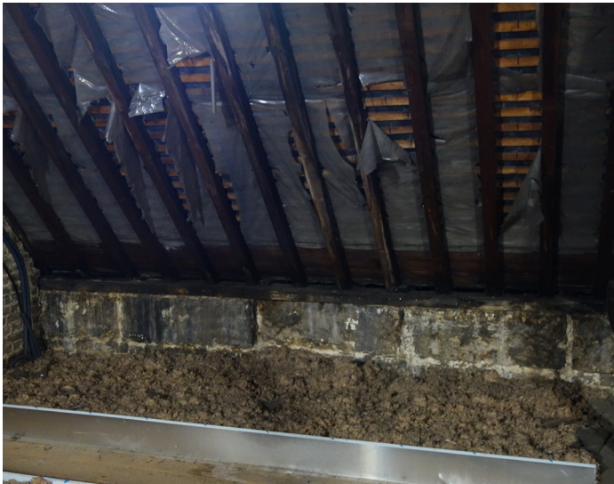
Trace d'humidité sur les murs d'arase
