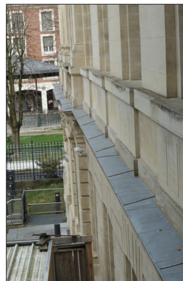
VÉTUSTÉ DE LA COUVERTINE EN ZINC AU DROIT DES BANDEAUX EN SAILLIE - DÉGRADATION DU SOLIN - INEFFICACITÉ DU SYSTÈME ANTI-VOLATILE
