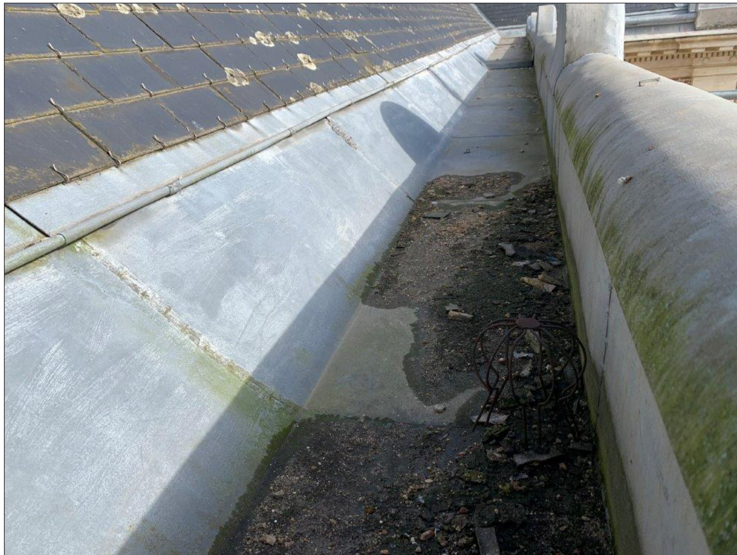
Les chéneaux (y compris la fonçure) sont recouverts de zinc et dotés de trop plein.
