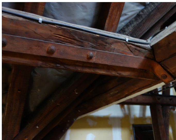
Utilisation de fer dans les assemblages de charpente
