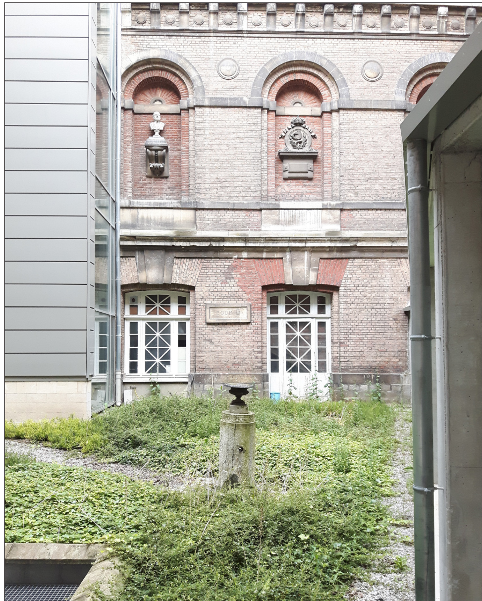
CONSOLES DE LA COUR B, AVEC BUSTES, BRIQUES DE REMPLISSAGE DES BAIES ET LES BRIQUES DU LINTEAU D'UNE DES BAIES DE NATURE DIFFÉRENTE DE CELLE DU RESTE DE LA FAÇADE
