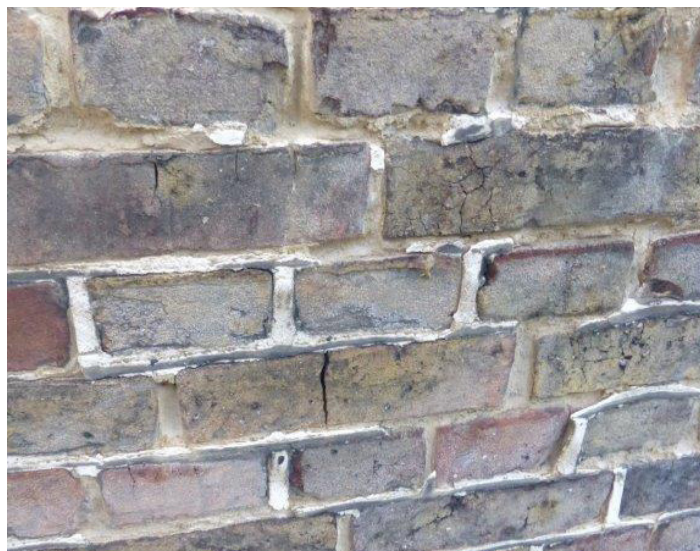
PURGE DES JOINTS RUBAN ET RÉFECTION À L'IDENTIQUE
