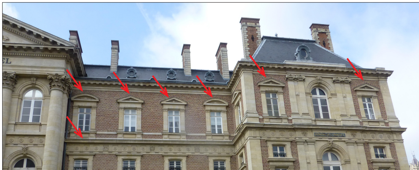
COUVERTINE EN ZINC AU DROIT DES BANDEAUX EN SAILLIE, DES FRONTONS TRIANGULAIRES ET DE CEUX À ANSE DE PANIER
