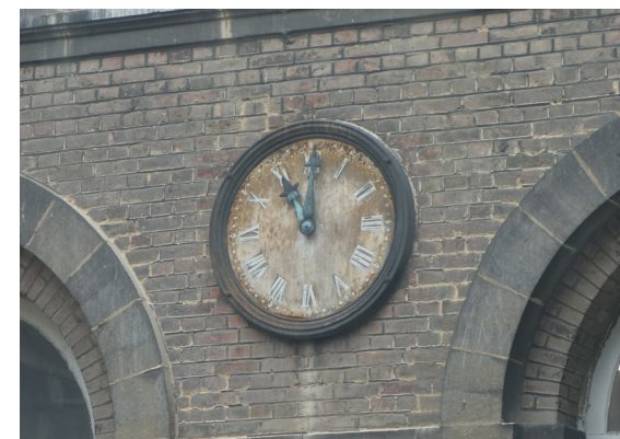
RESTAURATION DES CADRANS ET DES AIGUILLES QUI SERONT DORÉES
