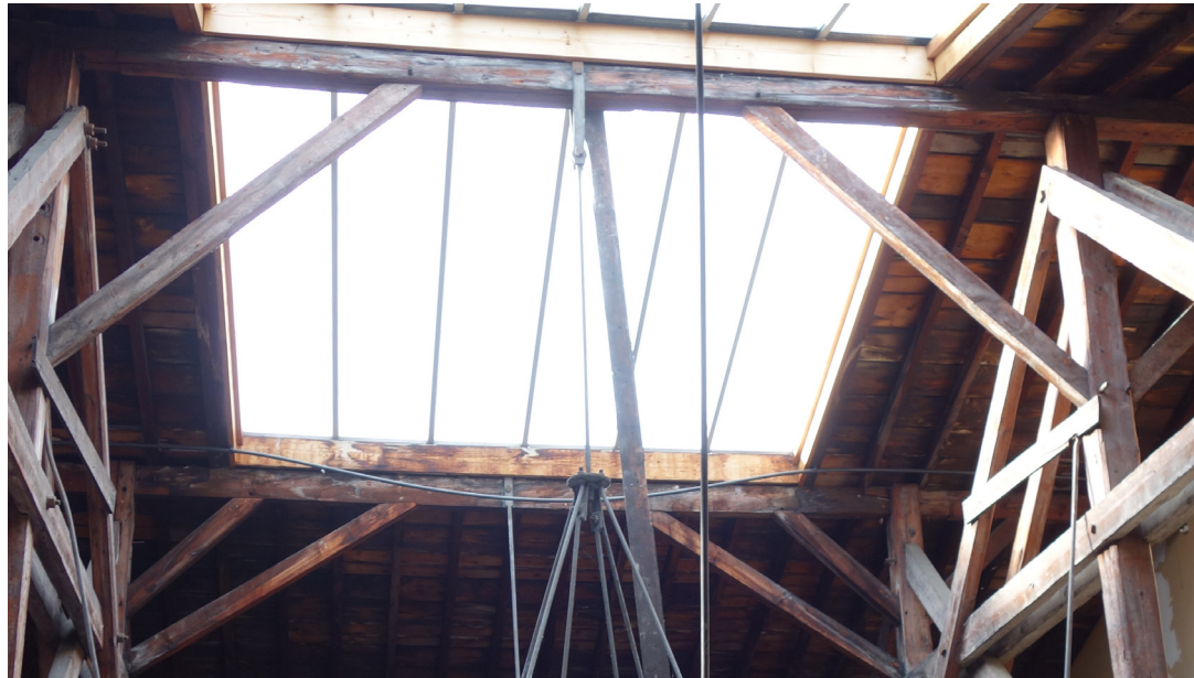
Vue de la verrière centrale depuis les combles. Révision de l'ensemble, réparation des verres cassés et remise en peinture de la structure métallique (RAL 7015)
