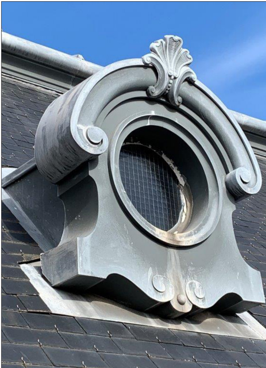
VÉTUSTÉ DU RECOUVREMENT DES PETITES LUCARNES EN OEIL DE BOEUF EN ZINC ALTÉRÉ
