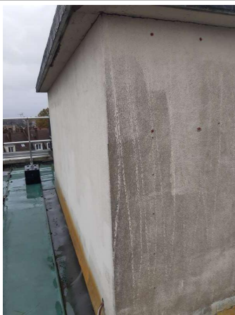
Prélèvement - P001 : Toiture C / Édicule - Enduit- (Absence d'amiante)
