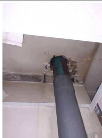
Prélèvement - P037 : Archives 1 - Enduit- (Absence d'amiante)
