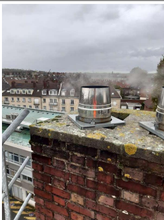
Prélèvement - P009 : Toiture C - Enduit lissé- (Absence d'amiante)
