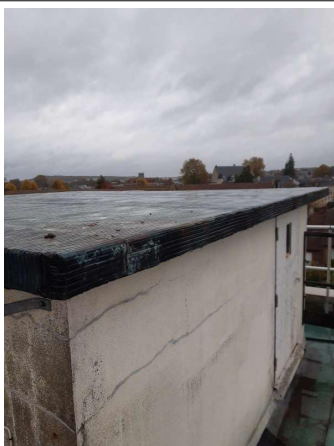
Prélèvement - P003 : Toiture C / Édicule - Revêtement d'étanchéité- (Absence d'amiante)
