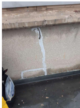
Prélèvement - P021 : Toiture D - Mastic- (Absence d'amiante)
