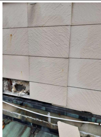
Prélèvement - P027 : Toiture B - Parement- (Absence d'amiante)
