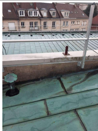
Prélèvement - P023 : Toiture D - Enduit lissé- (Absence d'amiante)
