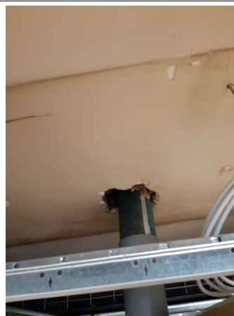
Prélèvement - P039 : Bureau 5 - Enduit- (Absence d'amiante)
