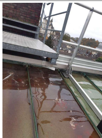
Prélèvement - P012 : Toiture C - Relevé d'étanchéité- (Absence d'amiante)
