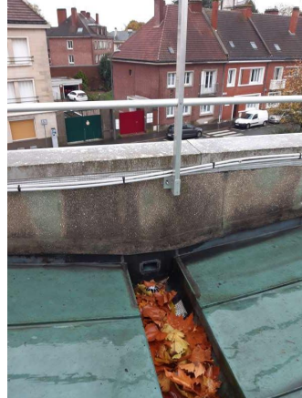
Prélèvement - P031 : Toiture B - Enduit lissé- (Absence d'amiante)
