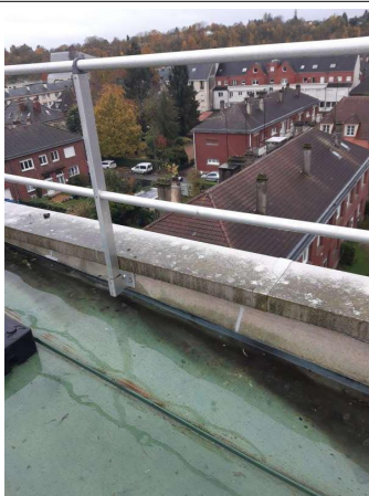
Prélèvement - P007 : Toiture C - Enduit taloché- (Absence d'amiante)
