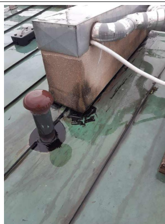
Prélèvement - P018 : Toiture C - Peinture- (Absence d'amiante)
