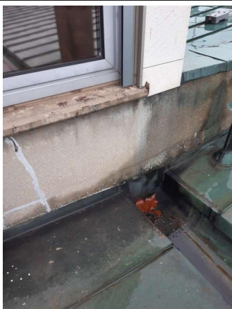
Prélèvement - P022 : Toiture D - Enduit lissé- (Absence d'amiante)
