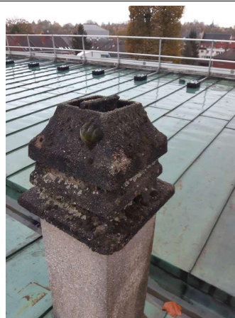
Prélèvement - P025 : Toiture D - Accessoire de couverture- (Absence d'amiante)
