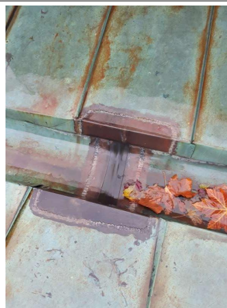
Prélèvement - P029 : Toiture B - Joint de dilatation- (Absence d'amiante)
