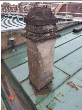
Prélèvement - P024 : Toiture D - Enduit lissé- (Absence d'amiante)
