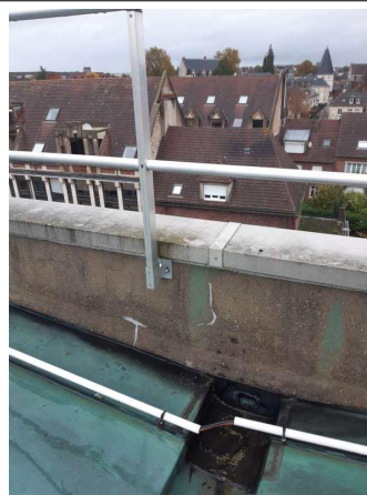
Prélèvement - P006 : Toiture C - Enduit taloché- (Absence d'amiante)
