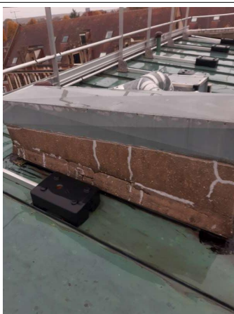
Prélèvement - P017 : Toiture C - Enduit- (Absence d'amiante)
