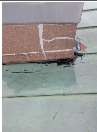
Prélèvement - P014 : Toiture C - Enduit- (Absence d'amiante)
