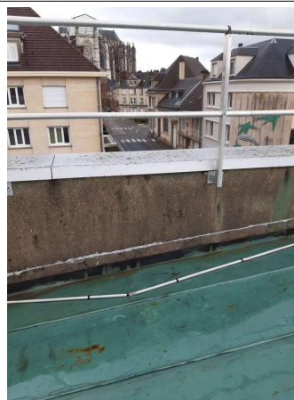
Prélèvement - P033 : Toiture A - Enduit lissé- (Absence d'amiante)
