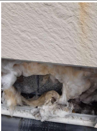
Prélèvement - P028 : Toiture B - Enduit taloché- (Absence d'amiante)
