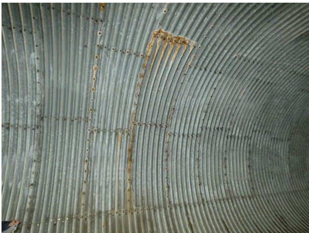
Photo 16 : Présence d'oxyde de zinc sur zone de recouvrement (profil 24 m/ côté Massiac = zone 2)
