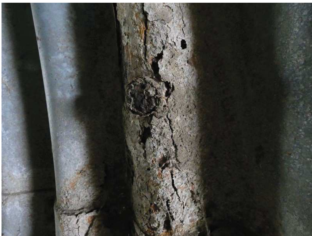
Photo 18 : Feuilletage de la tôle, oxyde de zinc et boulonnerie attaquée (zone 2)
