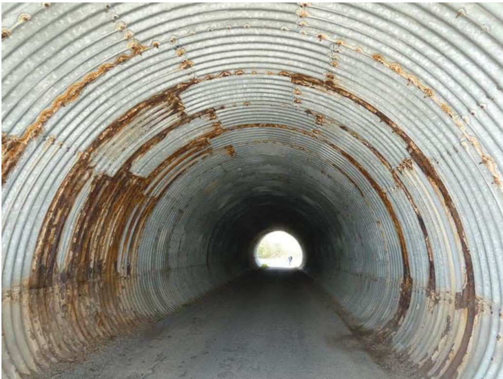
Photo 8 : Vue générale sur voûte corrodée profil 10 m
