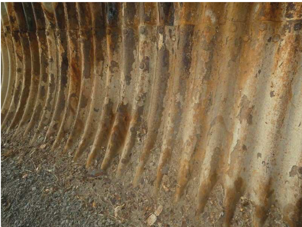
Photo 10 : plaques de coin corrodées (zone 4)
