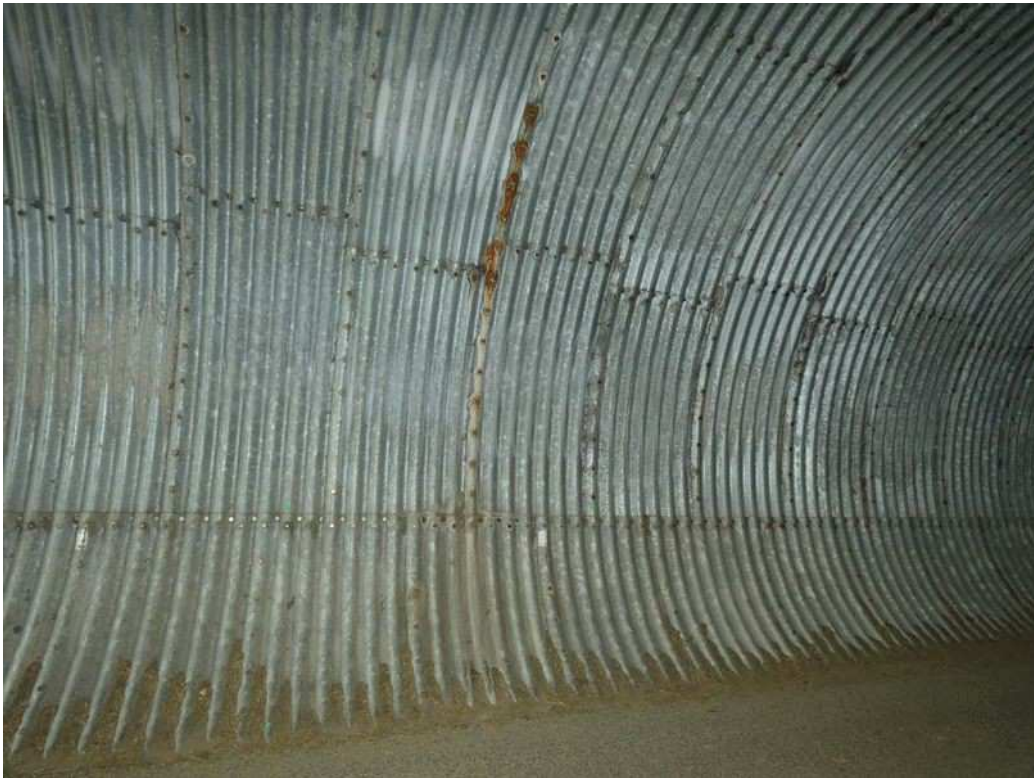
Photo 19 : Vue générale sur profil 36 m avec oxyde de zinc et corrosion sur les zones de recouvrement
