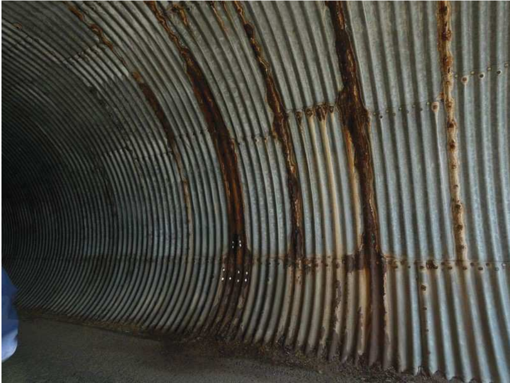
Photo 13 : Vue générale sur zone corrodée (profil 10 m /côté Clermont-Fd =zone 5)
