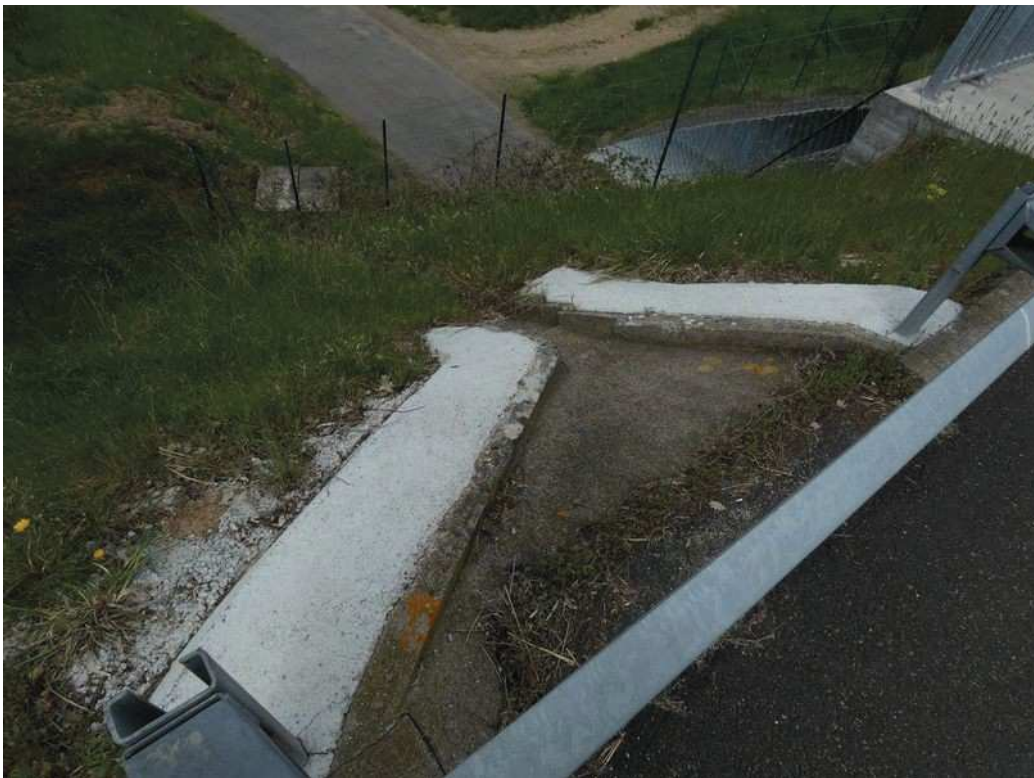
Photo 4 : Descente d'eau côté Espalem
