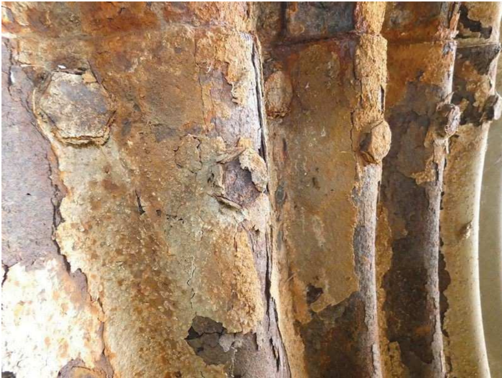
Photo 23 : Détail sur corrosion avec feuilletage et oxydation boulonnerie zone 1
