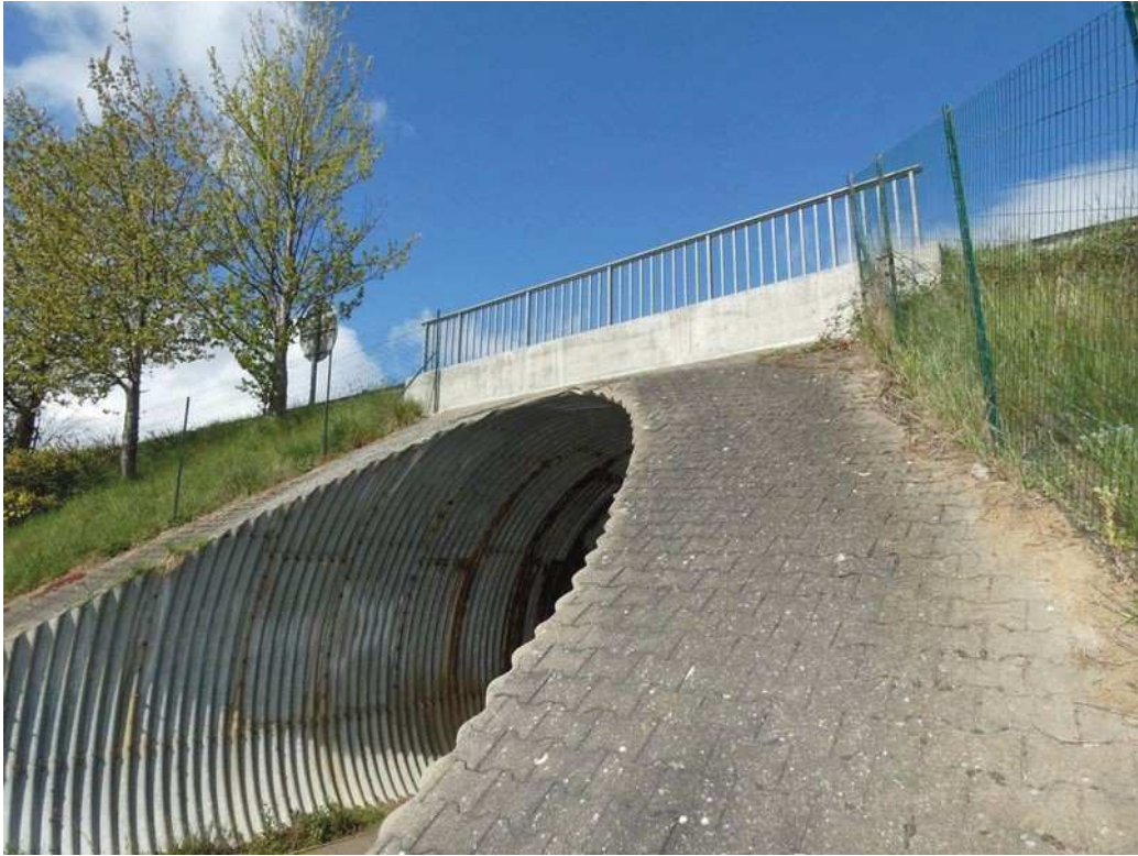
Photo 3 : Mise à niveau des grillages pour sécuriser les 2 sifflets de buse
