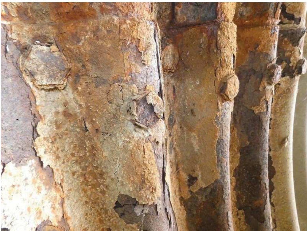
Photo 14 : Zoom sur corrosion avec feuilletage des tôles (zone 5)
