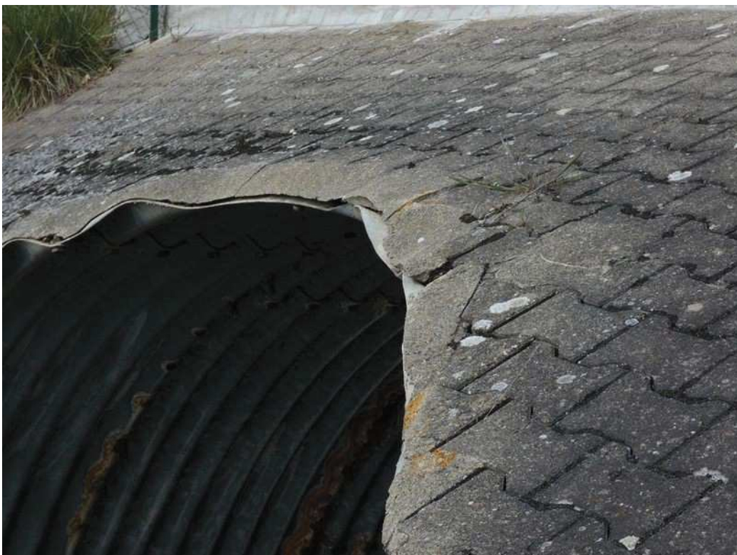
Photo 24 : Décollement mortier interface buse/perré
