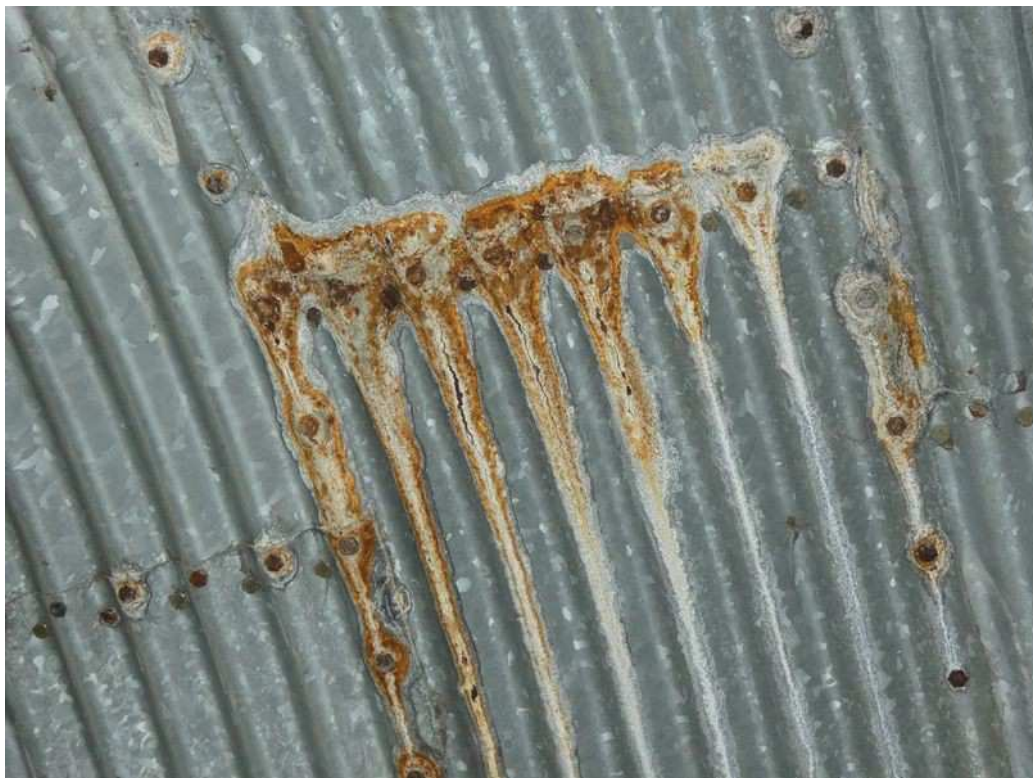
Photo 17 : Zoom sur zone de recouvrement avec oxyde de zinc et rouille (zone 2)
