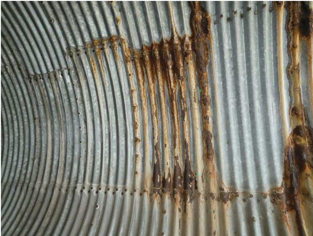
Photo 21 : Zoom sur corrosion dans les zones de recouvrement
