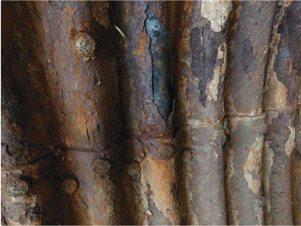
Photo 11 : Zoom sur zone de recouvrement corrodée(zone 4)
