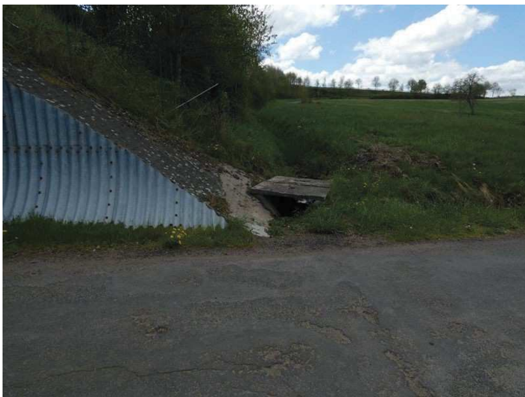
Photo 6 : Absence de protection au niveau de l'avaloir côté Espalem
