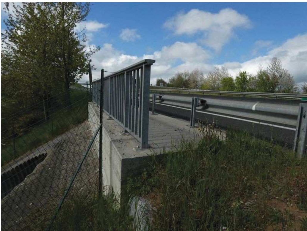
Photo 2 : Mise en place d'une dalle+garde corps pour sécuriser la zone surplombant l'exutoire de la buse
