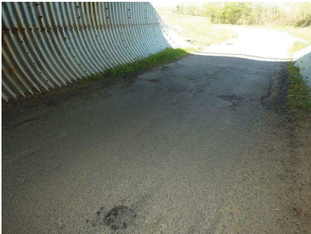
Photo 5 : Vue générale sur voie franchie (nids de poule, plumage, fissuration)
