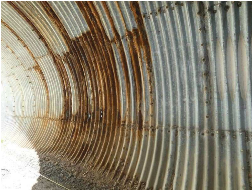
Photo 9 : Vue générale sur zone corrodée (profil 10 m /côté Massiac=zone 4)
