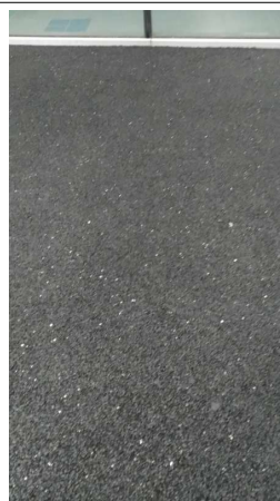
Prélèvement - P014 : R+0 / Façades rotonde - Enrobé bitumineux- (Absence d'amiante)
