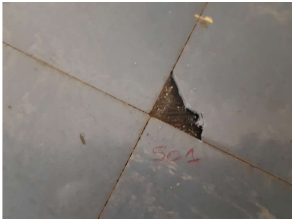
prélevé - idem P01 : ENS RENNES / R+0 / Circulation cafétéria - Colle, Dalle de sol- (Absence d'amiante)
