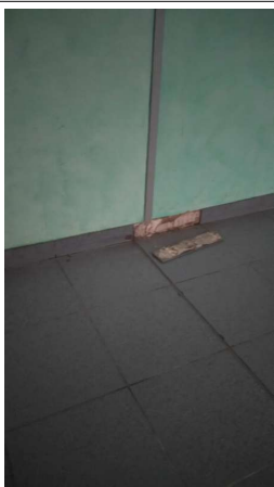
Prélèvement - P015 : R+0 / Circulation vers rotonde - Colle de carrelage- (Absence d'amiante)
