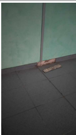
Prélèvement - P013 : R+0 / Circulation vers rotonde - Colle de plinthe- (Absence d'amiante)
