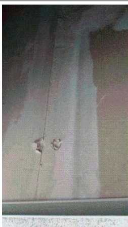
Prélèvement - ED9 : Bloc C > R+1 > Bureau 03 - Panneau de cloison- (Absence d'amiante)
