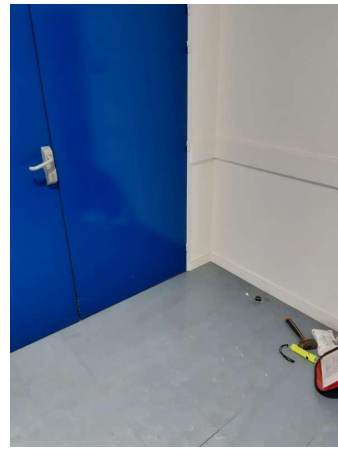
prélevé - idem P01 : ENS RENNES / R+0 / Circulation cafétéria - Colle, Dalle de sol- (Absence d'amiante)
