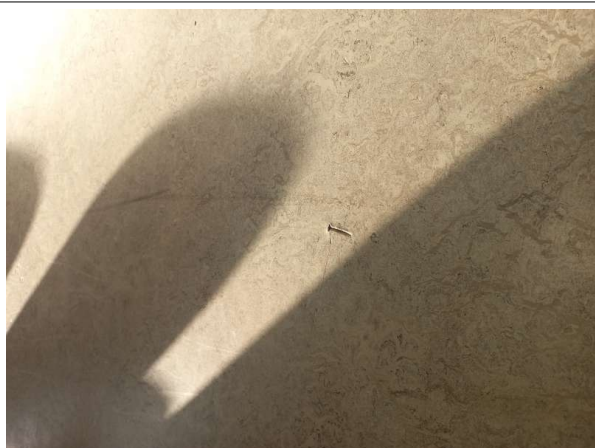
Déclaré - : Bâtiment ENS / R+0 / Amphithéâtre - Lé plastique avec sous-couche - DE- (Présence d'amiante)
