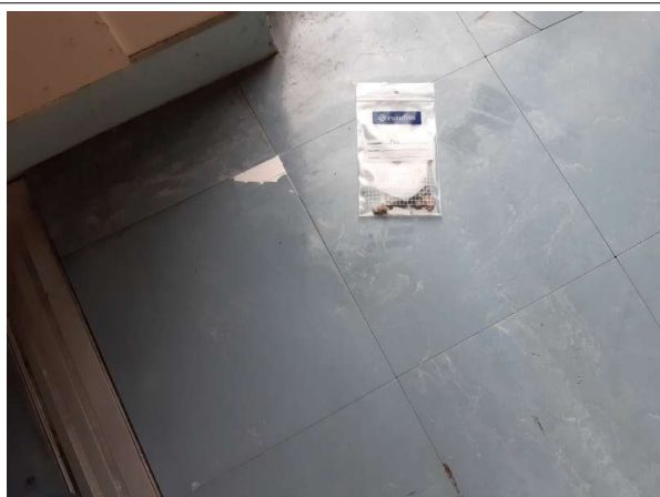
Prélèvement - P03 : ENS RENNES / R+0 / Circulation magasin - Colle, Dalle de sol- (Absence d'amiante)
