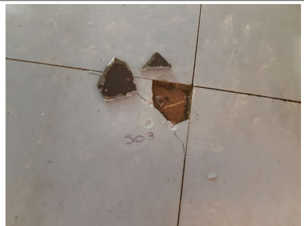
prélevé - idem P03 : ENS RENNES / R+0 / Circulation vestiaire - Colle, Dalle de sol- (Absence d'amiante)
