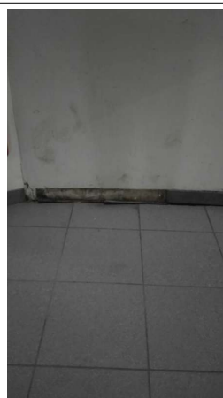
Prélèvement - P012 : R+0 / Rotonde K1 - Colle de plinthe- (Absence d'amiante)
