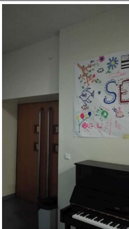
Prélèvement - P009 : R+0 / Cafétéria C1 - Panneau de cloison- (Absence d'amiante)
