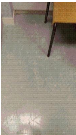
Prélèvement - ED7 : Bloc C > R+0 > Reprographie - Dalle de sol- (Absence d'amiante)
