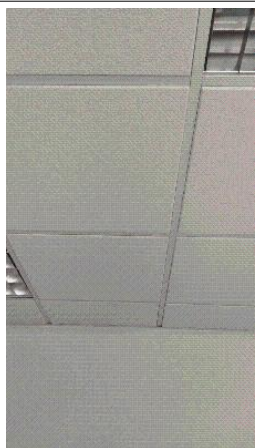
Prélèvement - ED3 : Bloc C > R+1 > Bureau 03 - Faux plafond- (Absence d'amiante)
