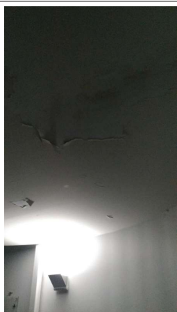
Prélèvement - P001 : R+0 / Rotonde K1 - Enduit- (Absence d'amiante)
