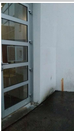
Prélèvement - P011 : R+0 / Façades rotonde - Enduit- (Absence d'amiante)
