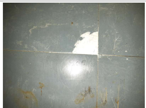
Déclaré - : ENS RENNES / R+0 / Circulation elec. - Dalle de sol- (Absence d'amiante)
