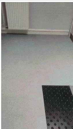
Prélèvement - ED5 : Bloc C > Escalier R+0/R+1 - Lé plastique- (Absence d'amiante)
