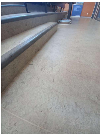
Déclaré - : Bâtiment ENS / R+0 / Amphithéâtre - Lé plastique avec sous-couche - DE- (Présence d'amiante)
