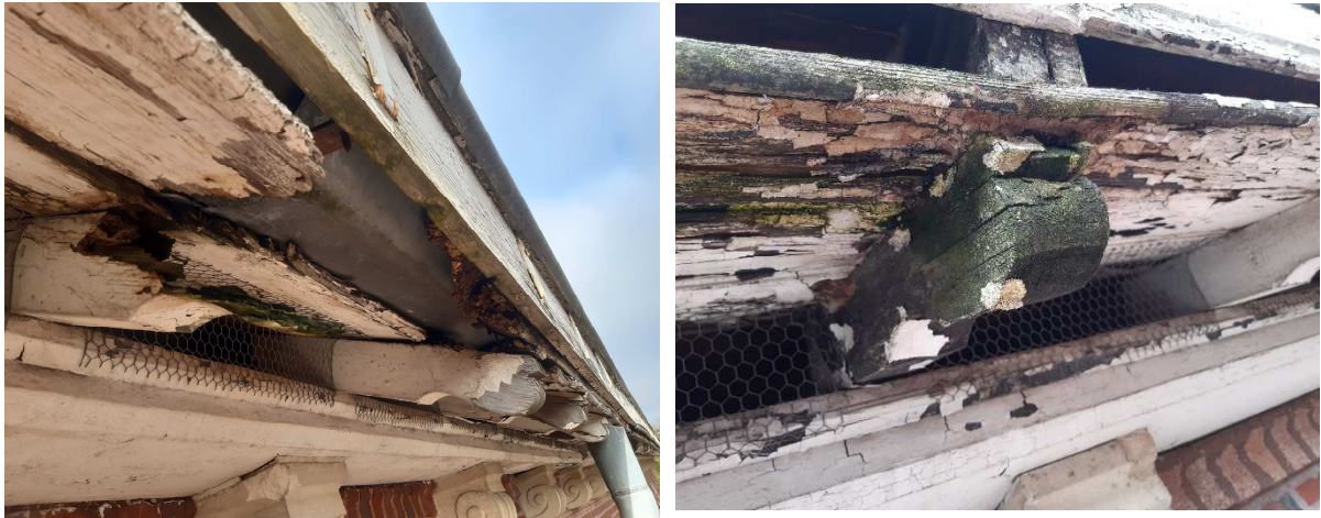
Détérioration des chevrons
