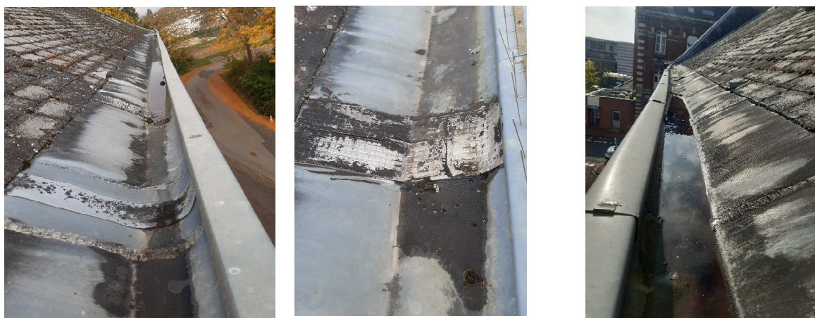
Traces d'humidité et stagnation d'eau
