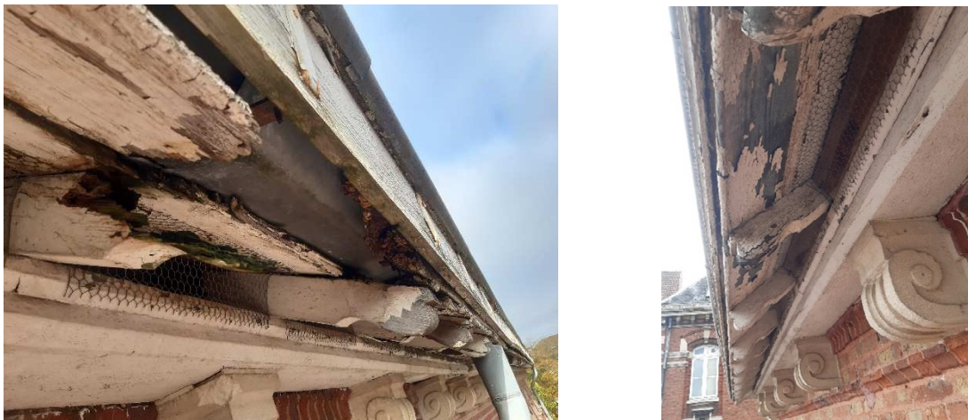
Détérioration des voliges des corniches
