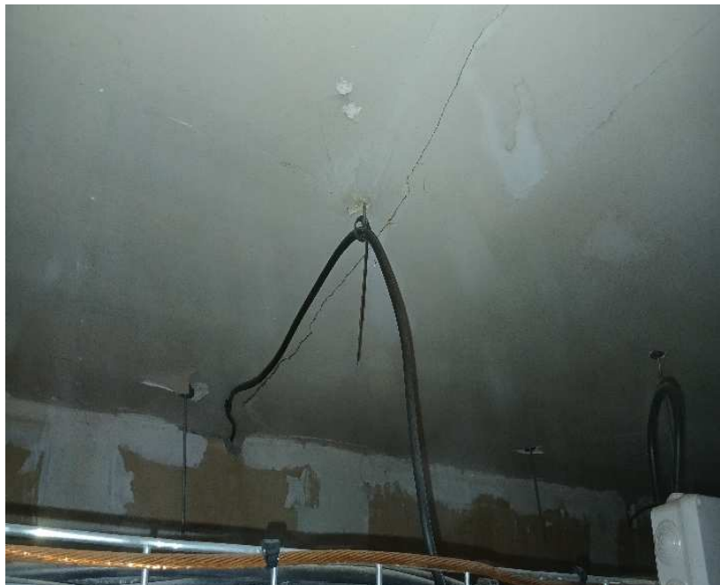
Exemple de Fissures sous plafond
