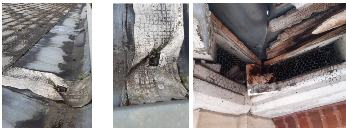
Détérioration de l'étanchéité des chéneaux
