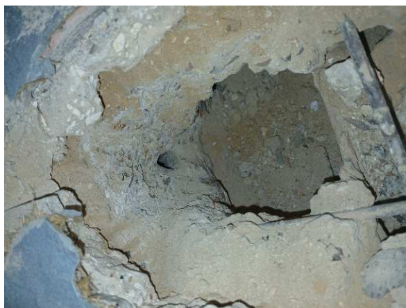
Photographie du sondage Dalle de compression S9
