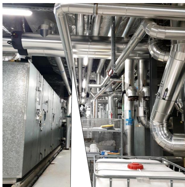
Panoplie d'humidification vapeur de la CTA 2 à déposer et à évacuer.
