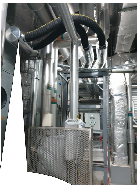
Panoplie d'humidification vapeur de la CTA 2 à déposer et à évacuer.
