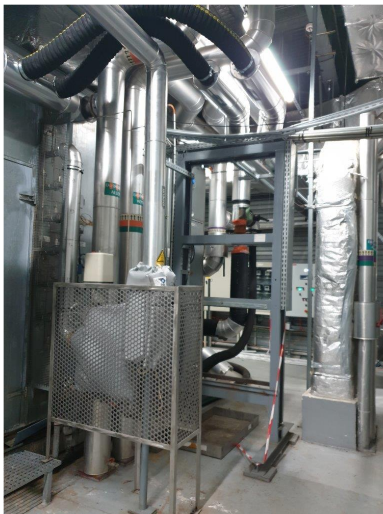
Panoplie d'humidification vapeur de la CTA 2 à déposer et à évacuer.
