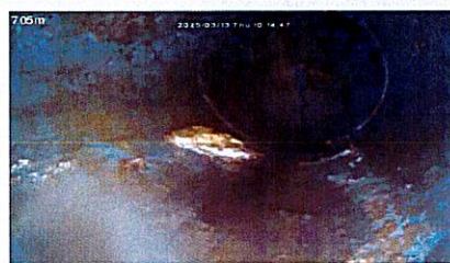
7,85 m fin inspection arrivée sur coude à 12h (lavabo)
