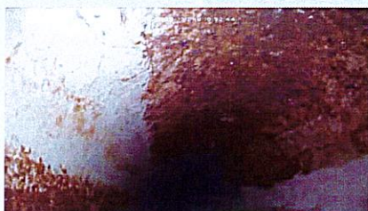
0,03 m réseau à 10 % de charge -contre pente
