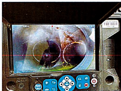
Embranchement à droite arrivée EV et à gauche EU
