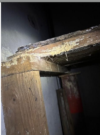
Accès caves Sud(RDC) : Mezzanine au-dessus de l'escalier Poteaux de support plateforme (Bois - Non peint)
