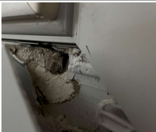
Prélèvement - P104 : OFB - POITIERS / RDC / SACRETERIAT 1 - Joint d'étanchéité entre menuiserie et structure- (Absence d'amiante)
