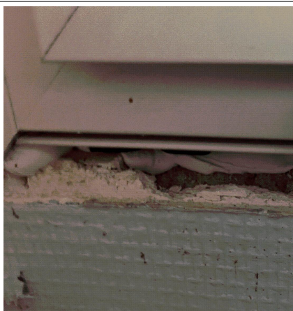
Prélèvement - P095 : OFB - POITIERS / R+1 / SANITAIRES - Joint d'étanchéité entre menuiserie et structure- (Absence d'amiante)
