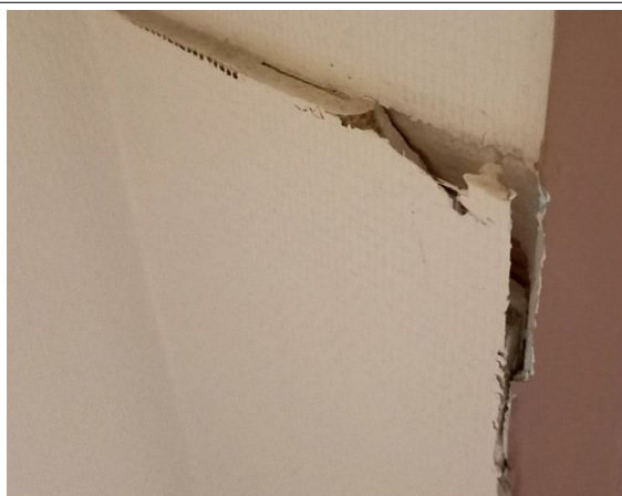
Prélèvement - P035 : OFB - POITIERS / R+1 / SANITAIRES - Colle de faïence- (Présence d'amiante)
