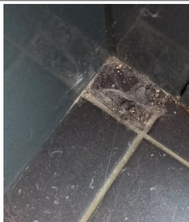
Prélèvement - P050 : OFB - POITIERS / RDC / HALL - Colle de carrelage- (Absence d'amiante)
