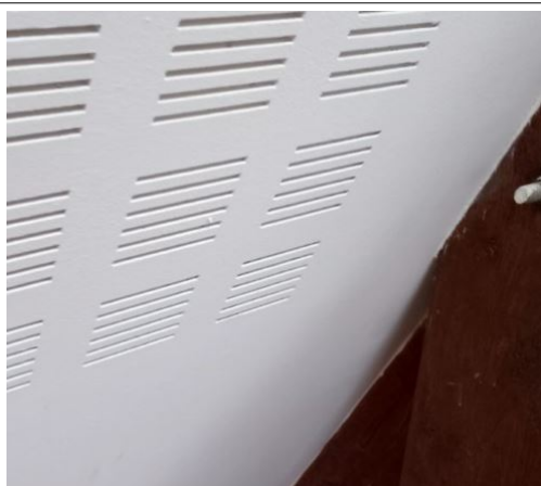
Prélèvement - P003 : OFB - POITIERS / R+1 / SALLE DE REUNION - Bande de plaque de plâtre- (Absence d'amiante)
