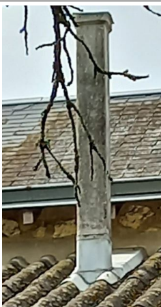
prélevé - idem P038 : OFB - POITIERS / EXTERIEUR / TOITURES - Conduit- (Présence d'amiante)
