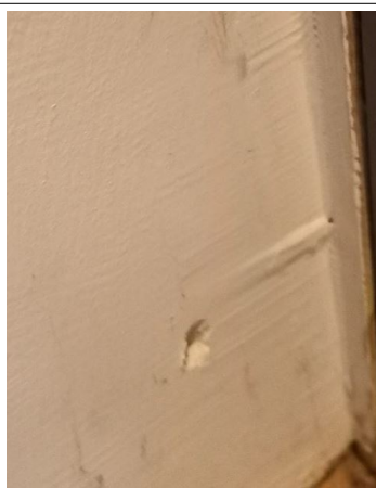
Prélèvement - P058 : OFB - POITIERS / RDC / LOCAL TECHNIQUE - Peinture- (Absence d'amiante)
