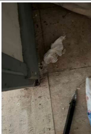
Prélèvement - P106 : OFB - POITIERS / RDC / ENTREE - Colle- (Absence d'amiante)
