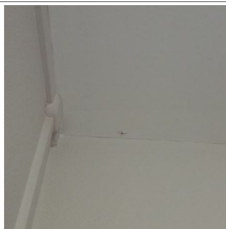
Prélèvement - P070 : OFB - POITIERS / RDC / SANITAIRES - Peinture- (Absence d'amiante)
