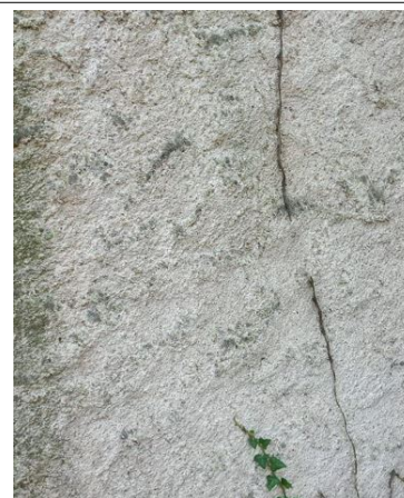
Prélèvement - P090 : OFB - POITIERS / EXTERIEUR / FACADES - Enduit- (Absence d'amiante)
