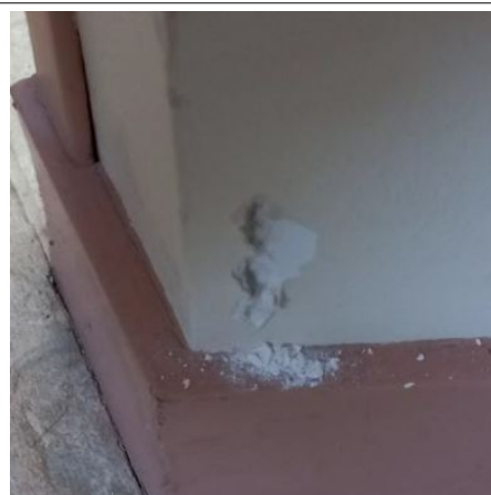
Prélèvement - P004 : OFB - POITIERS / R+1 / SALLE DE REUNION - Bande de plaque de plâtre- (Absence d'amiante)
