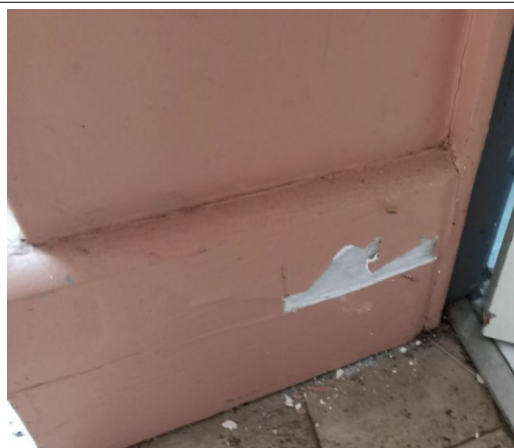
Prélèvement - P072 : OFB - POITIERS / RDC / ENTREE - Peinture- (Absence d'amiante)
