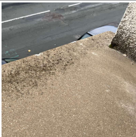
Prélèvement - P099 : OFB - POITIERS / EXTERIEUR / FACADES - Enduit- (Absence d'amiante)
