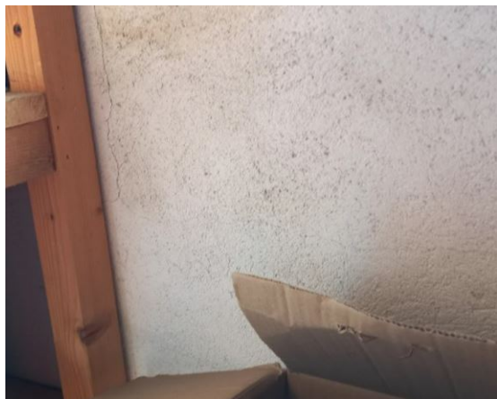
Prélèvement - P048 : OFB - POITIERS / RDC / ARCHIVES - Enduit- (Absence d'amiante)
