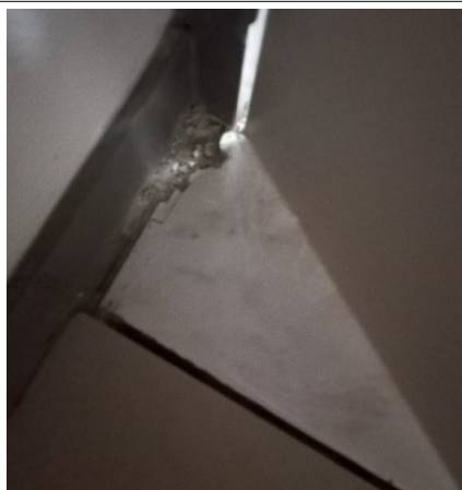
Prélèvement - P062 : OFB - POITIERS / RDC / SANITAIRES - Colle de carrelage- (Absence d'amiante)
