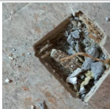
Prélèvement - P016 : OFB - POITIERS / R+1 / BUREAU 9 - Isolant- (Absence d'amiante)
