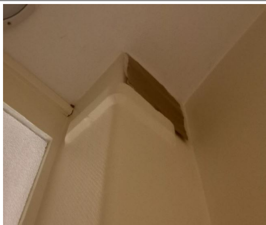
Prélèvement - P038 : OFB - POITIERS / R+1 / SANITAIRES - Conduit- (Présence d'amiante)
