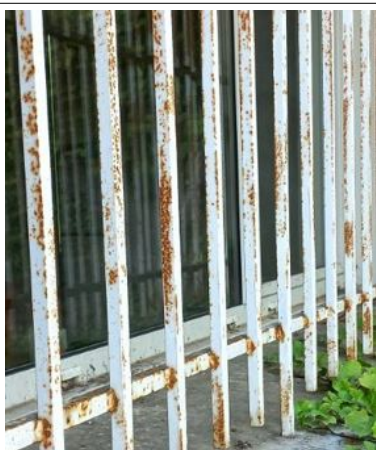
Prélèvement - P087 : OFB - POITIERS / EXTERIEUR / FACADES - Peinture- (Absence d'amiante)
