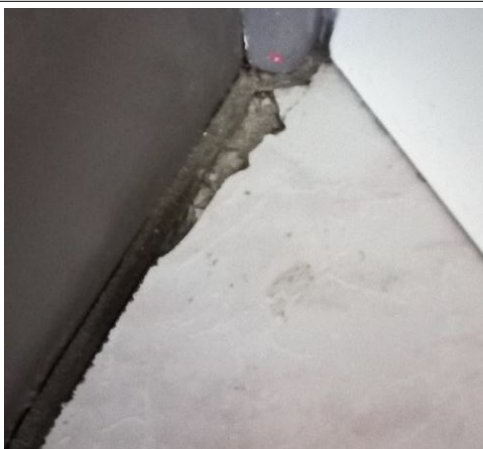
Prélèvement - P061 : OFB - POITIERS / RDC / HALL - Colle de carrelage- (Absence d'amiante)
