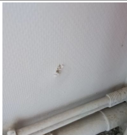
Prélèvement - P064 : OFB - POITIERS / RDC / SANITAIRES - Toile de verre- (Absence d'amiante)
