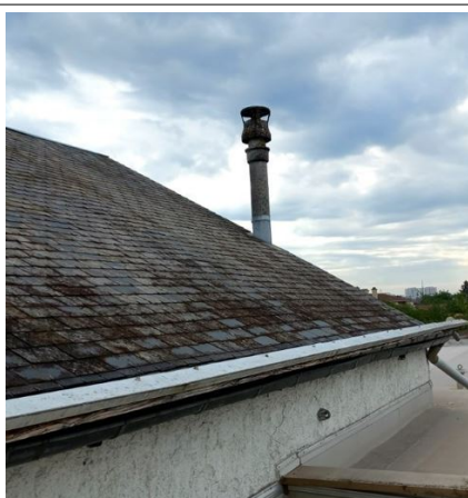
Déclaré - : OFB - POITIERS / EXTERIEUR / TOITURES - Conduit- (Présence d'amiante)
