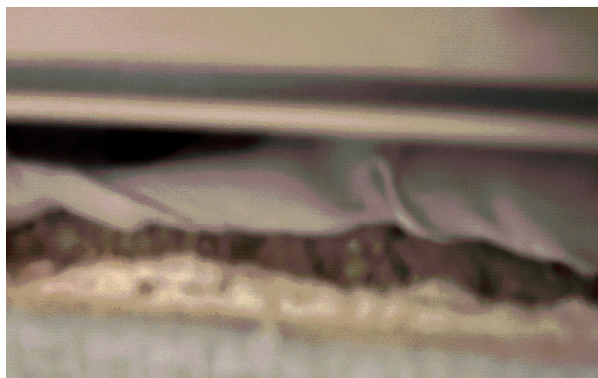
Prélèvement - P093 : OFB - POITIERS / R+1 / BUREAU 6 - Joint d'étanchéité entre menuiserie et structure- (Absence d'amiante)
