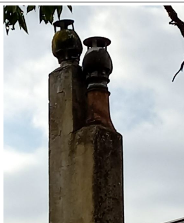
Déclaré - : OFB - POITIERS / EXTERIEUR / TOITURES - Conduit- (Présence d'amiante)
