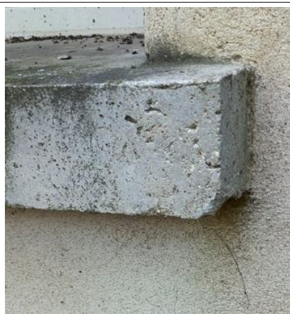
Prélèvement - P082 : OFB - POITIERS / EXTERIEUR / FACADES - Enduit- (Présence d'amiante)
