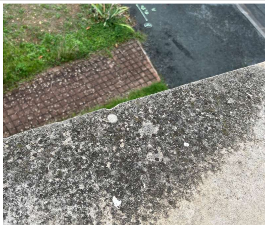
Prélèvement - P103 : OFB - POITIERS / EXTERIEUR / FACADES - Enduit- (Absence d'amiante)
