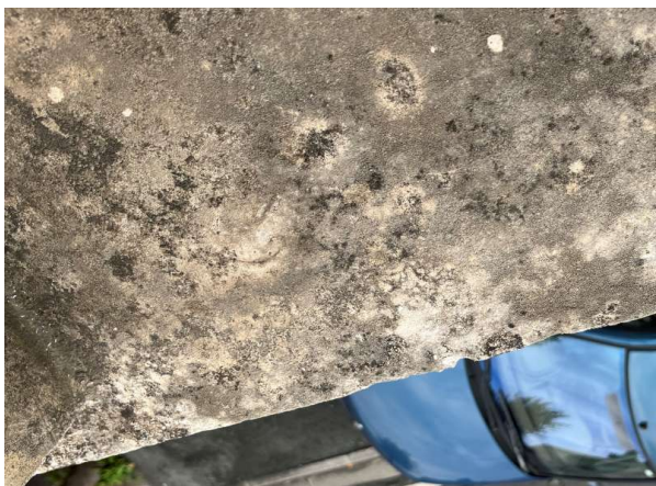
Prélèvement - P097 : OFB - POITIERS / EXTERIEUR / FACADES - Enduit- (Absence d'amiante)
