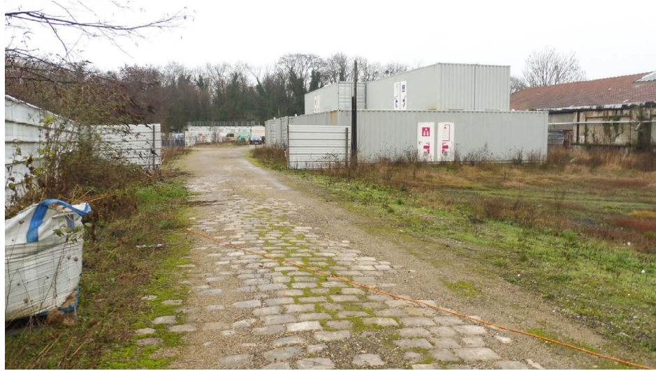
T2 : Dépose des pavés en grès devant les casemates est et la halle 2
