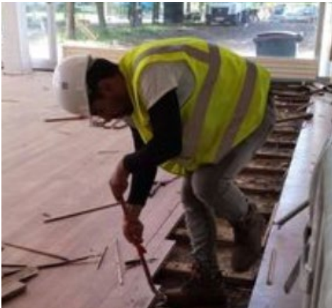
RéaVie (dépose soignée de parquet – à droite et transport de radiateurs en vue d'un réemploi – à gauche)
