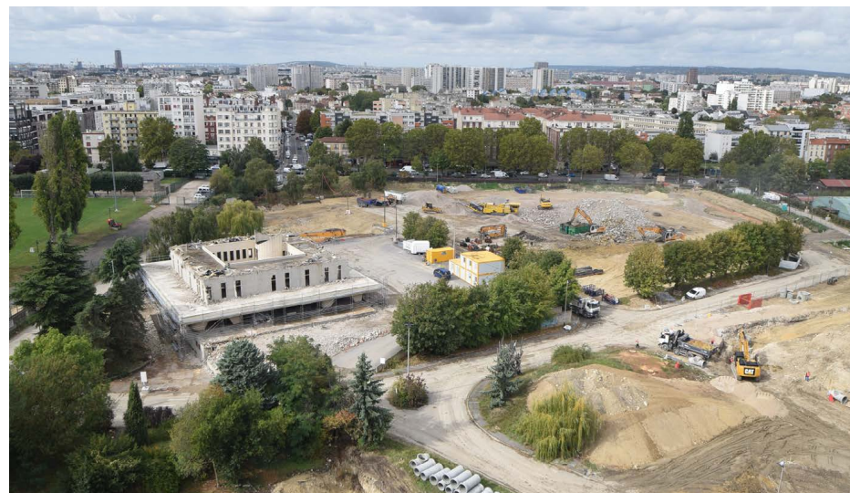
T1 : Chantier de déconstruction de la gendarmerie et dévoiements Déboisement douve ouest
