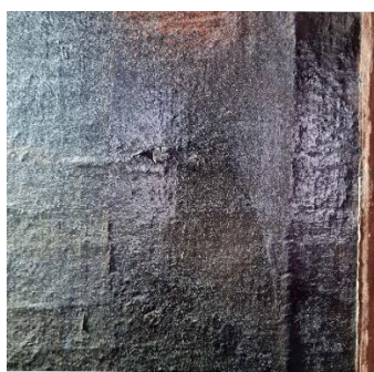
Détails de plusieurs zones avec des amorces de soulèvements
