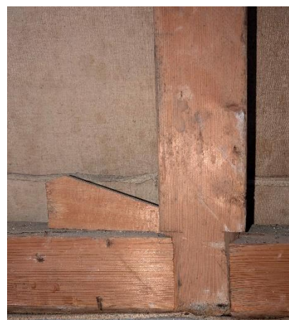
Détail de l'assemblage à queue d'aronde
