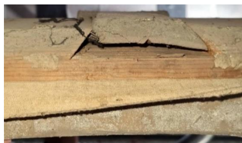
Détail du retrait du bois d'une queue d'aronde
