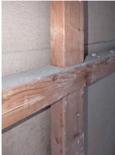
Détail d'un des assemblages vissés de deux traverses entre elles.
