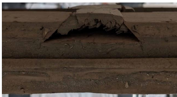
Détail du retrait du bois d'une queue d'aronde fissuré
