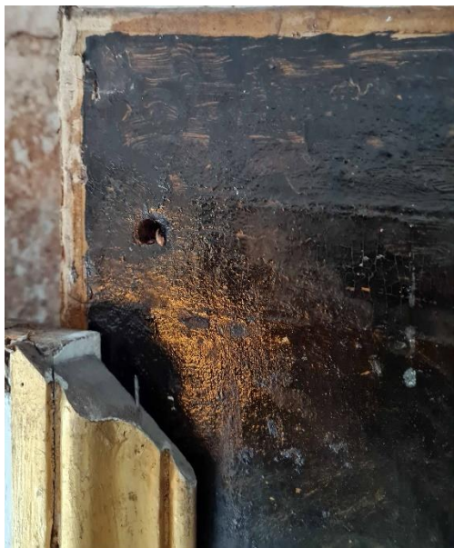
Détail d'un trou de vis de maintien de la boiserie supérieure.
