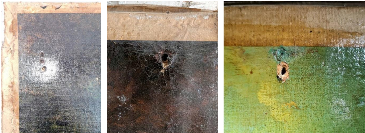
Détails des trous de vis traversants pour maintenir le fronton des boiseries.
