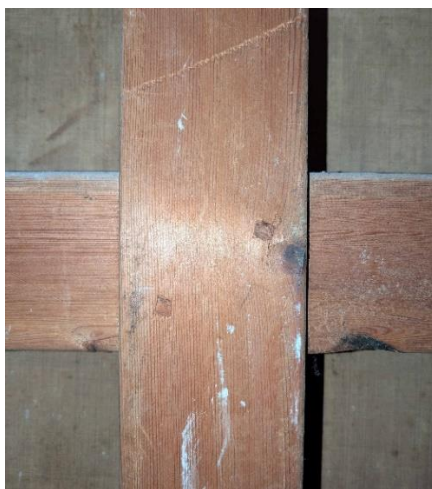
Détail d'un des assemblages chevillés de deux traverses entre elles.
