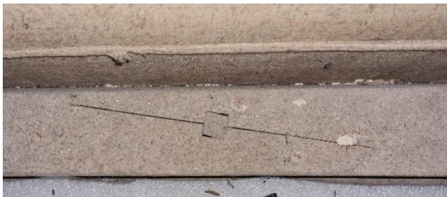
Détail de l'assemblage à trait de Jupiter à clé
