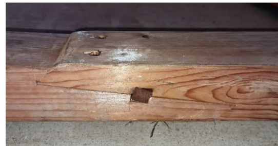
Détail de l'assemblage et des vis de renfort
