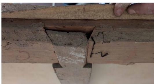
Détail d'un assemblage altéré et disjoint
