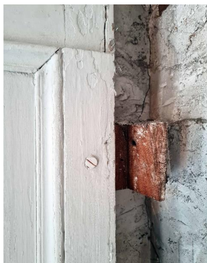
Détail de la fixation des volets aux inserts de bois maçonnés
