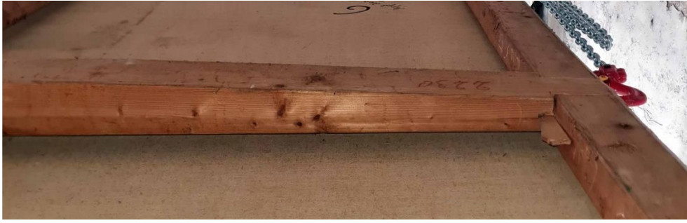
Détail de l'aminçissement des traverses aux extrémités
