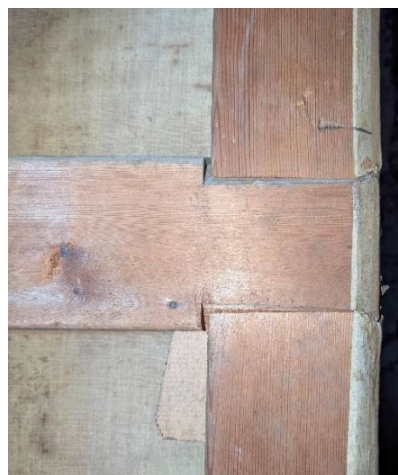
Détails des assemblages à queue d'aronde des traverses aux montants du châssis.
