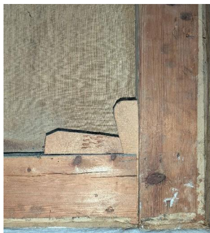
Détail de l'assemblage inférieur senestre de l'angle à épaulement du châssis.
