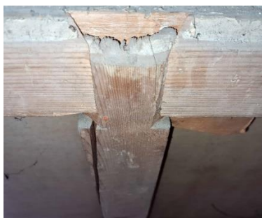
Détail d'un assemblage fissuré et disjoint
