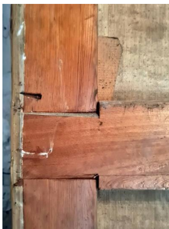
Détails des assemblages à queue d'aronde des traverses aux montants du châssis.
