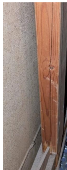
Détail d'une traverse fissurée
