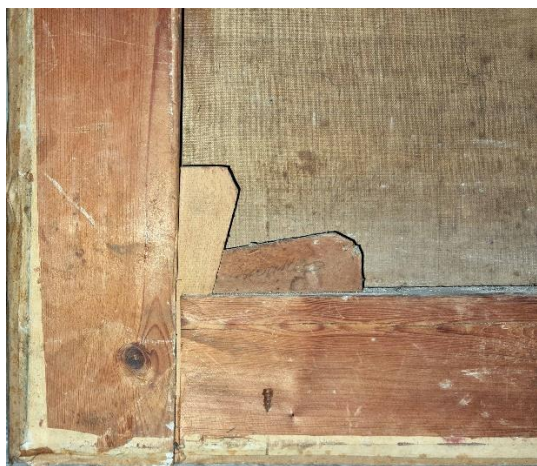
Détail de l'assemblage inférieur dextre de l'angle à épaulement du châssis.
