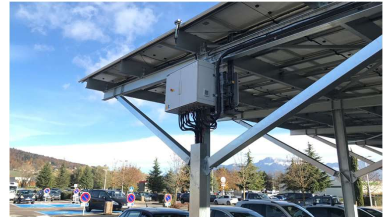
Exemple d'onduleur fixé sur un poteau d'ombrière
