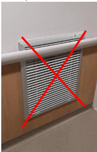
Grille « standard » à proscrire Grilles « sur mesure » à privilégier (photos : circulations MHPP existantes)
