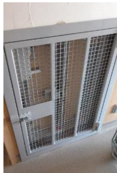
Grille « standard » à proscrire Grilles « sur mesure » à privilégier (photos : circulations MHPP existantes)
