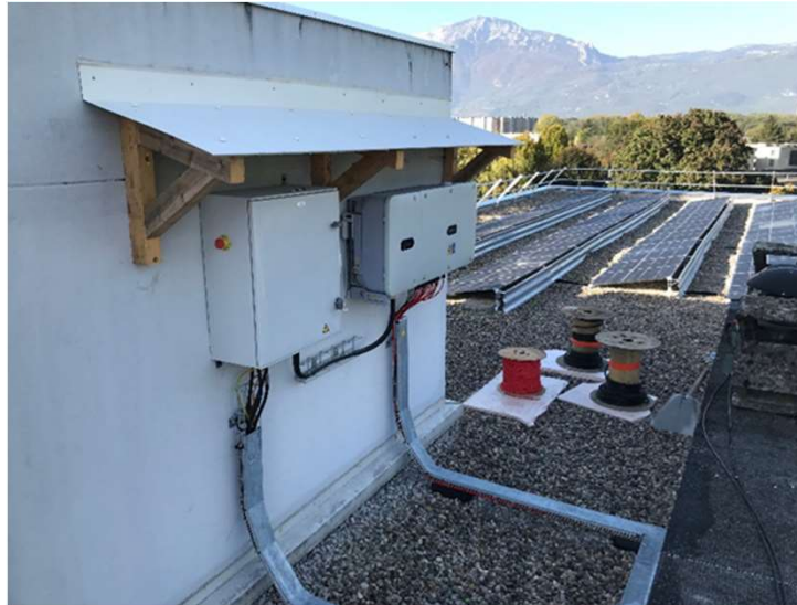
Exemple d'onduleurs en toiture sous casquette de protection
