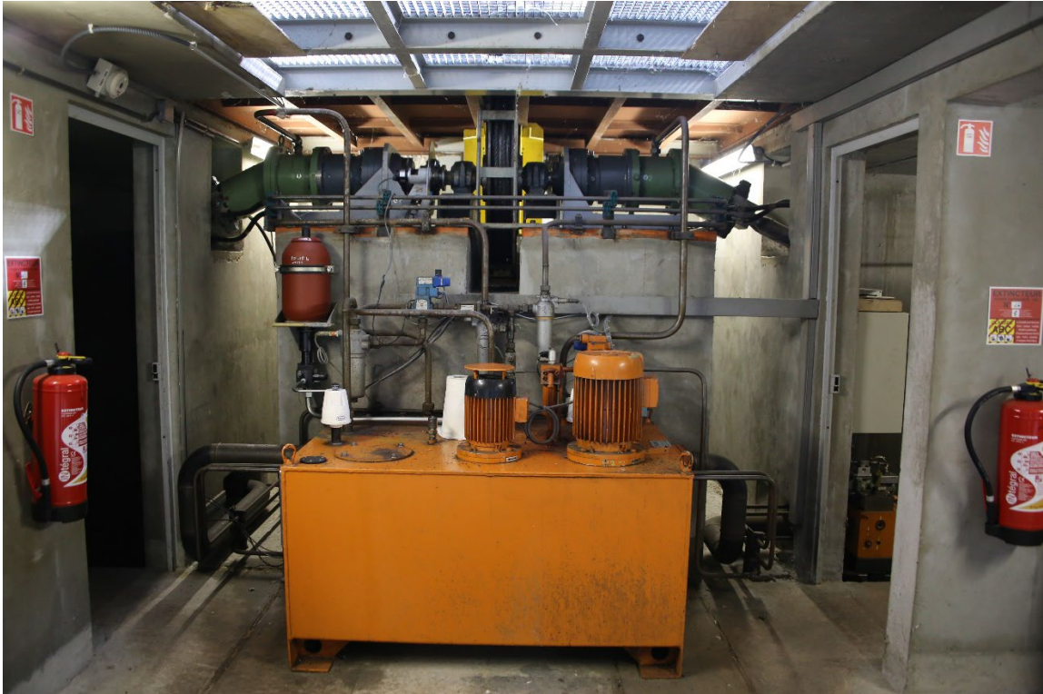
Photo 3 : centrale hydraulique, moteurs et poulie motrice
