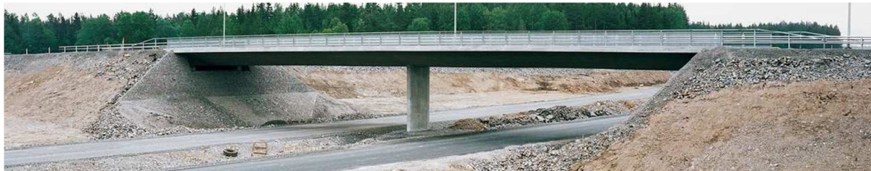
Référence de culées habillées de gabions et de pile de pont banché – Pont de la RV72, Stockholm, Erick Anderson (source : DIR Atlantique)
