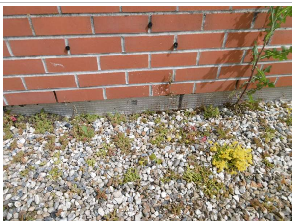
Prélèvement - P002 : CPAM / R+2 / Toiture terrasse plate - Relevé d'étanchéité- (Absence d'amiante)
