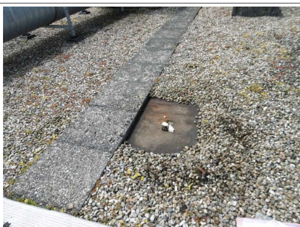
Prélèvement - P022 : CPAM / R+4 / Toitures terrasses plate - Revêtement d'étanchéité- (Absence d'amiante)
