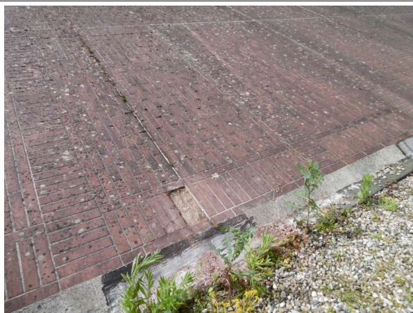
Prélèvement - P004 : CPAM / R+2 / Toiture terrasse plate - Revêtement d'étanchéité- (Absence d'amiante)
