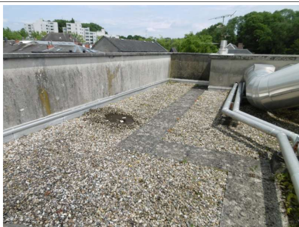
Prélèvement - P018 : CPAM / R+4 / Toitures terrasses plate - Revêtement d'étanchéité- (Absence d'amiante)
