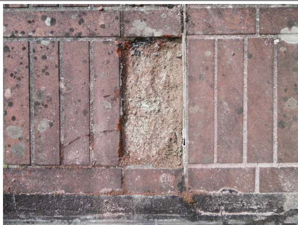
Prélèvement - P006 : CPAM / R+2 / Toiture terrasse en pente - Colle, Revêtement d'étanchéité- (Absence d'amiante)
