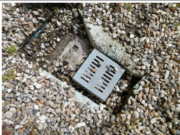
Prélèvement - P001 : CPAM / R+2 / Toiture terrasse plate - Revêtement d'étanchéité- (Absence d'amiante)
