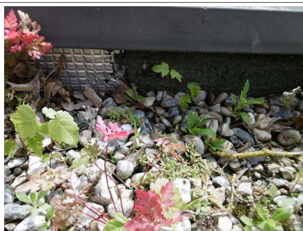
Prélèvement - P003 : CPAM / R+2 / Toiture terrasse plate - Relevé d'étanchéité- (Absence d'amiante)
