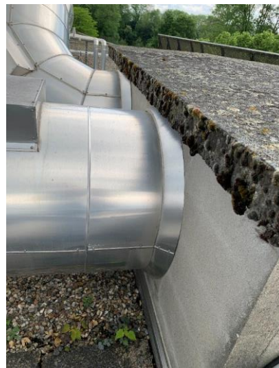
Gaines calorifugées
