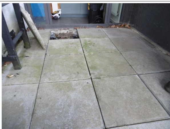
Prélèvement - P016 : CPAM / R+3 / Toiture terrasse dalles - Relevé d'étanchéité- (Absence d'amiante)
