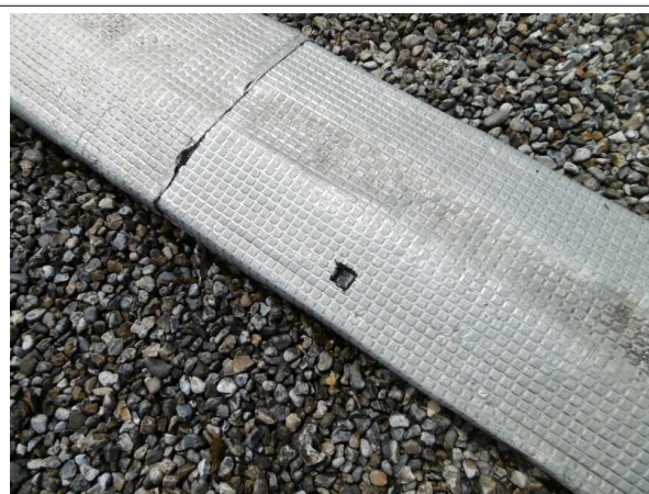
Prélèvement - P021 : CPAM / R+4 / Toitures terrasses plate - Relevé d'étanchéité- (Absence d'amiante)
