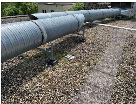
Gaines non calorifugées
