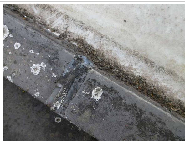
Prélèvement - P015 : CPAM / R+2 / Toiture terrasse en pente - Mastic- (Absence d'amiante)
