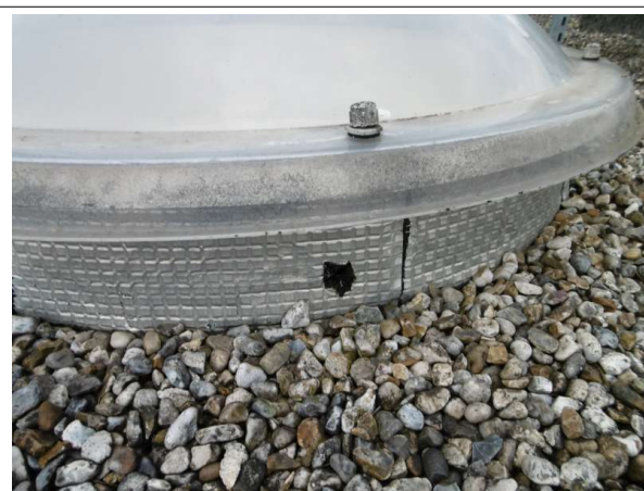
Prélèvement - P025 : CPAM / R+4 / Toitures terrasses plate - Relevé d'étanchéité- (Absence d'amiante)
