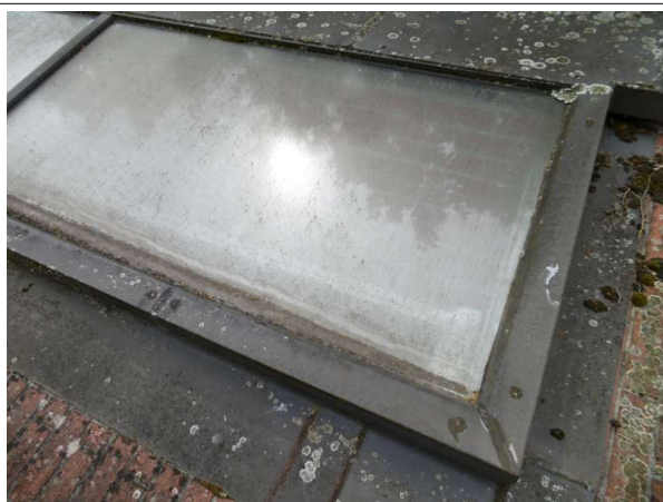
Prélèvement - P014 : CPAM / R+2 / Toiture terrasse en pente - Mastic- (Absence d'amiante)
