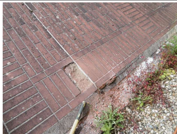
Prélèvement - P012 : CPAM / R+2 / Toiture terrasse en pente - Joint- (Absence d'amiante)
