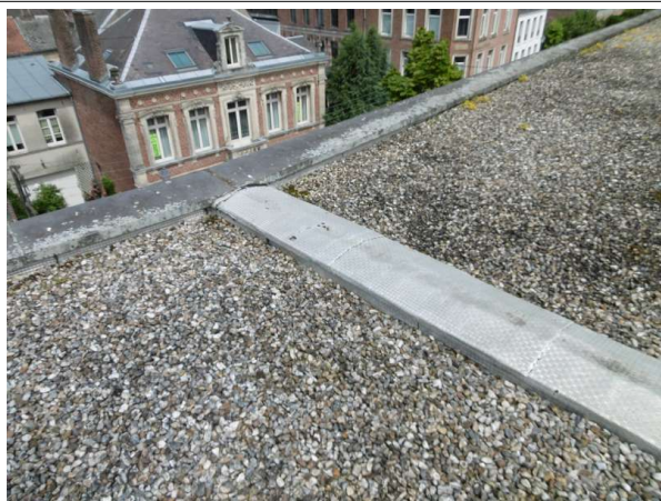
Prélèvement - P023 : CPAM / R+4 / Toitures terrasses plate - Relevé d'étanchéité- (Absence d'amiante)
