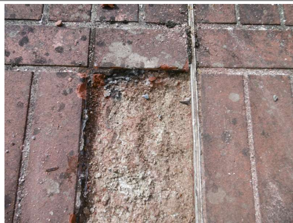
Prélèvement - P006 : CPAM / R+2 / Toiture terrasse en pente - Colle, Revêtement d'étanchéité- (Absence d'amiante)
