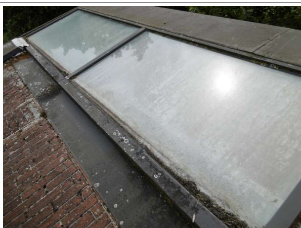
Prélèvement - P015 : CPAM / R+2 / Toiture terrasse en pente - Mastic- (Absence d'amiante)
