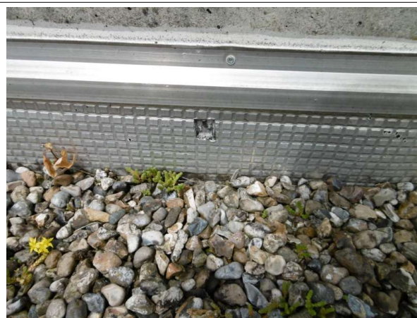
Prélèvement - P020 : CPAM / R+4 / Toitures terrasses plate - Relevé d'étanchéité- (Absence d'amiante)
