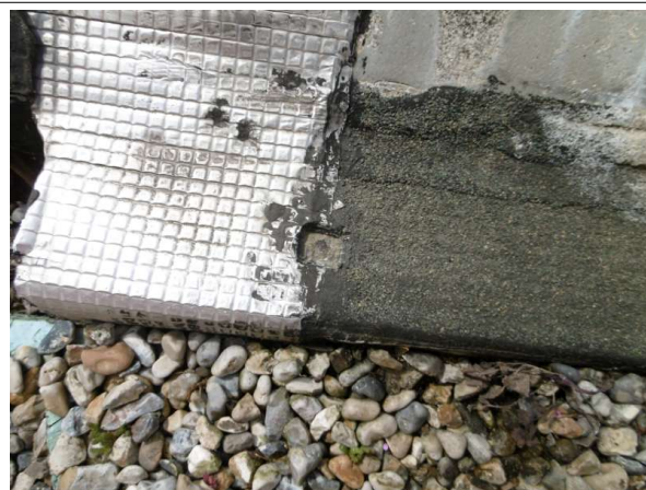
Prélèvement - P008 : CPAM / R+2 / Toiture terrasse en pente - Relevé d'étanchéité- (Absence d'amiante)
