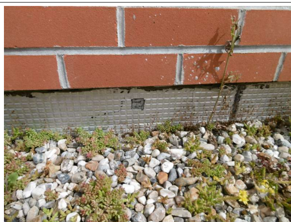
Prélèvement - P002 : CPAM / R+2 / Toiture terrasse plate - Relevé d'étanchéité- (Absence d'amiante)
