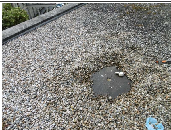
Prélèvement - P024 : CPAM / R+4 / Toitures terrasses plate - Revêtement d'étanchéité- (Absence d'amiante)
