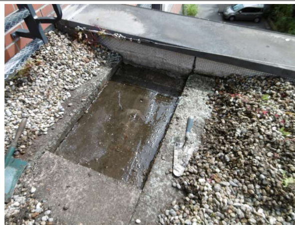
Prélèvement - P004 : CPAM / R+2 / Toiture terrasse plate - Revêtement d'étanchéité- (Absence d'amiante)
