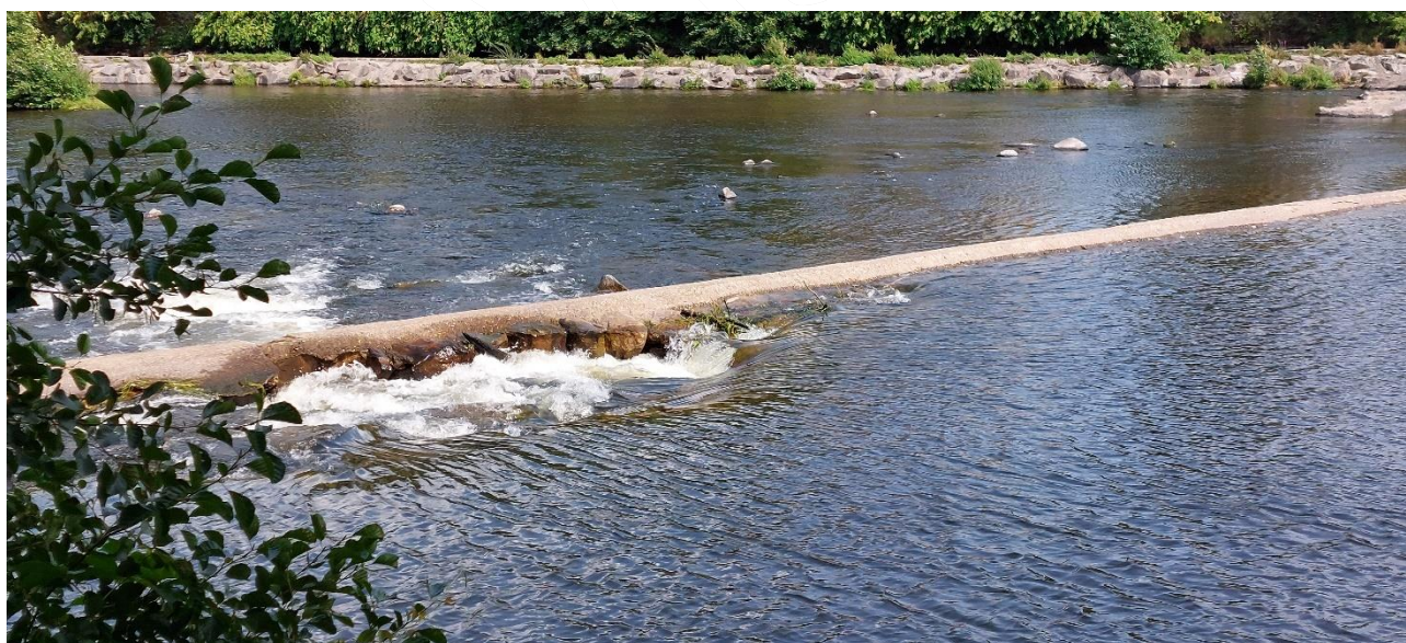
Figure 3 - Vue du seuil fixe à la suite de la rupture depuis la rive gauche amont
