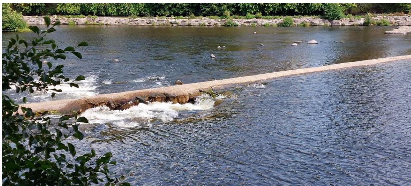
Figure 16 - Rupture du seuil fixe (août 2023)
