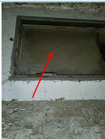
Matériaux : ZPSO-013 Prélèvement : P013 Description : Revêtement dur (plaque) sur menuiseries extérieures Localisation : Chaudière 1 Résultat : Absence d'amiante
