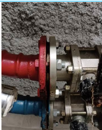
Matériaux : ZPSO-031 Prélèvement : P03C Description : Vanne Aller Gymnase - Joint Localisation : Chaufferie Résultat : Présence d'amiante
