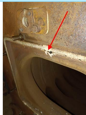
Matériaux : ZPSO-022 Prélèvement : P022 Description : Joint tresse brûleur Localisation : Chaudière 2; Chaudière 3 Résultat : Présence d'amiante
