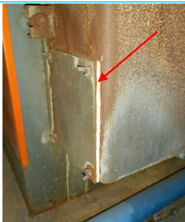
Matériaux : ZPSO-019 Prélèvement : P019 Description : Joint plat (bas trappe latérale droite) Localisation : Chaudière 1 Résultat : Présence d'amiante
