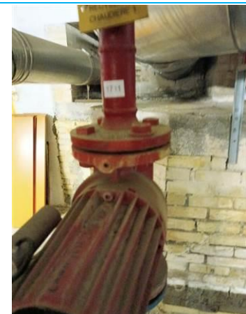
Matériaux : ZPSO-034 Prélèvement : P06C Description : Pompe recyclage Chaudière 1 - Joint Localisation : Chaufferie Résultat : Présence d'amiante
