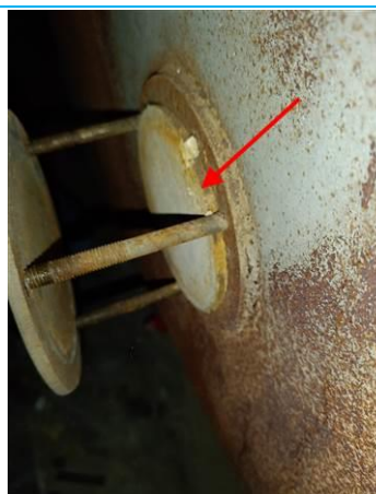
Matériaux : ZPSO-018 Prélèvement : P018 Description : Joint plat (arrière bas) Localisation : Chaudière 1 Résultat : Présence d'amiante
