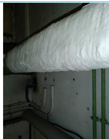
Matériaux : ZPSO-006 Prélèvement : P006 Description : Calorifugeage (haut mur droite) Localisation : Chauffage Résultat : Absence d'amiante
