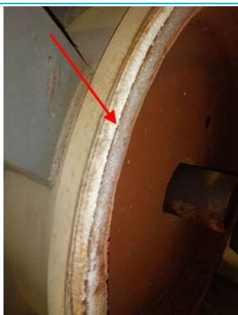
Matériaux : ZPSO-015 Prélèvement : P015 Description : Joint tresse corps de chauffe Localisation : Chaudière 1 Résultat : Présence d'amiante
