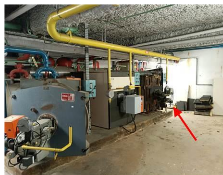
Matériaux : ZPSO-008 Prélèvement : P008 Description : Calorifugeage (bas mur gauche) Localisation : Chaufferie Résultat : Absence d'amiante
