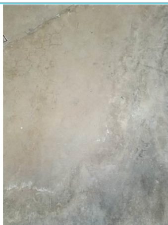
Matériaux : ZPSO-011 Prélèvement : P011 Description : Sol coulé Localisation : Chaufferie Résultat : Absence d'amiante
