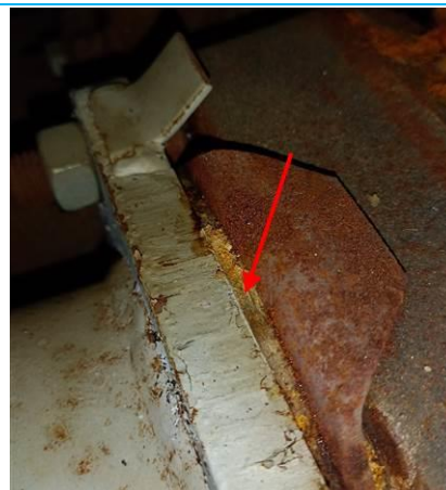
Matériaux : ZPSO-028 Prélèvement : P028 Description : Joint plat (dessus arrière haut) Localisation : Chaudière 3 Résultat : Présence d'amiante
