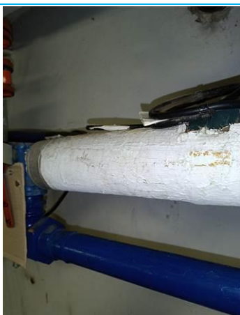
Matériaux : ZPSO-005 Prélèvement : P005 Description : Calorifugeage (intermédiaire mur droite) Localisation : Chauffage Résultat : Absence d'amiante
