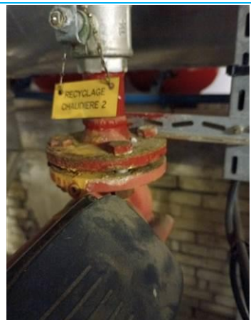
Matériaux : ZPSO-033 Prélèvement : P05C Description : Pompe recyclage Chaudière 2 - Joint Localisation : Chaufferie Résultat : Absence d'amiante
