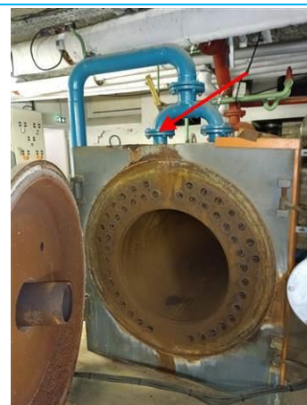
Matériaux : ZPSO-016 Prélèvement : P016 Description : Joint de bride (bleu avant) Localisation : Chaudière 1 Résultat : Présence d'amiante
