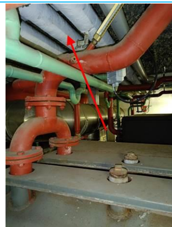
Matériaux : ZPSO-010 Prélèvement : P010 Description : Calorifugeage (haut fin derrière chaudières) Localisation : Chaufferie Résultat : Absence d'amiante
