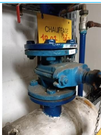
Matériaux : ZPSO-030 Prélèvement : P02C Description : Vanne Retour Bât D - Joint Localisation : Chaufferie Résultat : Présence d'amiante
