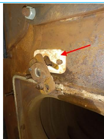
Matériaux : ZPSO-024 Prélèvement : P024 Description : Joint plat (sur visuel flamme) Localisation : Chaudière 2; Chaudière 3 Résultat : Présence d'amiante
