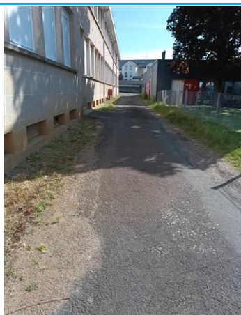
Matériaux : ZPSO-001 Prélèvement : P001 Description : Enrobé bitumineux Localisation : Extérieur bâti Résultat : Absence d'amiante / HAP <50 mg/kg
