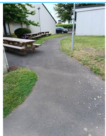
Matériaux : ZPSO-035 Prélèvement : E02 Description : Enrobé bitumineux Localisation : Extérieur bâti Résultat : Absence d'amiante
