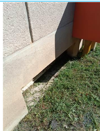
Matériaux : ZPSO-002 Prélèvement : P002 Description : Enduit mural extérieur Localisation : Extérieur bâti Résultat : Absence d'amiante
