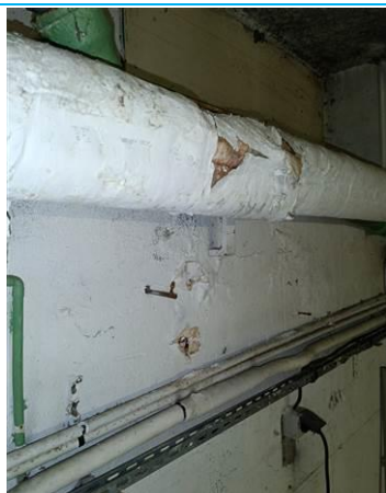
Matériaux : ZPSO-007 Prélèvement : P007 Description : Calorifugeage (mur du fond) Localisation : Chaufferie Résultat : Absence d'amiante
