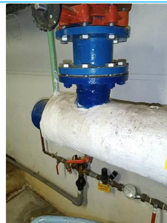
Matériaux : ZPSO-004 Prélèvement : P004 Description : Calorifugeage (bas mur droite) Localisation : Chauffage Résultat : Absence d'amiante
