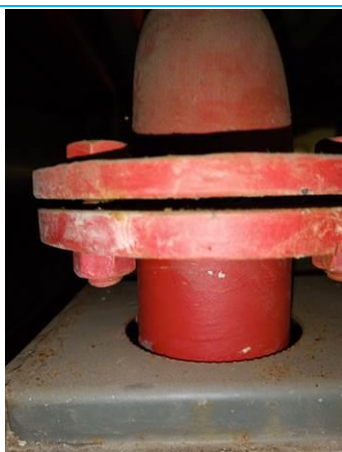
Matériaux : ZPSO-017 Prélèvement : P017 Description : Joint de bride (rouge arrière haut) Localisation : Chaudière 1 Résultat : Présence d'amiante
