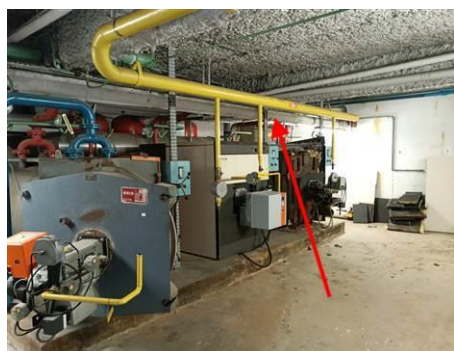
Matériaux : ZPSO-009 Prélèvement : P009 Description : Calorifugeage (gros au dessus chaudières) Localisation : Chaufferie Résultat : Absence d'amiante
