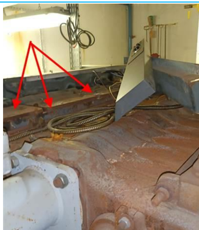
Matériaux : ZPSO-027 Prélèvement : P027 Description : Joint tresse (dessus chaudière x8) Localisation : Chaudière 2; Chaudière 3 Résultat : Présence d'amiante
