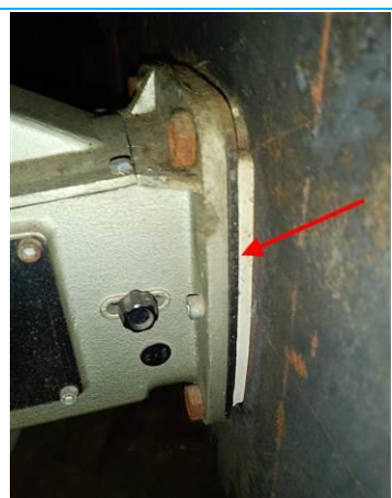
Matériaux : ZPSO-023 Prélèvement : P023 Description : Joint de bride (extérieur porte) Localisation : Chaudière 2; Chaudière 3 Résultat : Présence d'amiante
