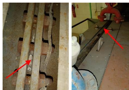
Matériaux : ZPSO-020 Prélèvement : P020 Description : Joint d'étanchéité (central haut entre les 2 éléments) Localisation : Chaudière 1 Résultat : Présence d'amiante
