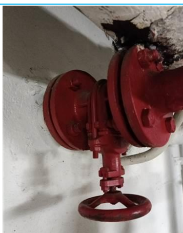
Matériaux : ZPSO-029 Prélèvement : P01C Description : Vanne Aller Bât A - Joint Localisation : Chaufferie Résultat : Présence d'amiante
