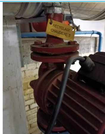
Matériaux : ZPSO-032 Prélèvement : P04C Description : Pompe recyclage Chaudière 3 - Joint Localisation : Chaufferie Résultat : Absence d'amiante
