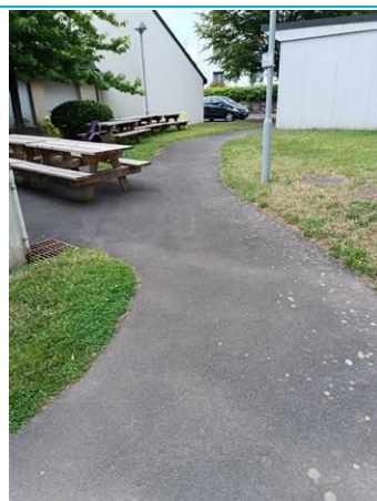
Matériaux : ZPSO-035 Prélèvement : E02 Description : Enrobé bitumineux Localisation : Extérieur bâti Résultat : Absence d'amiante / HAP <50 mg/kg
