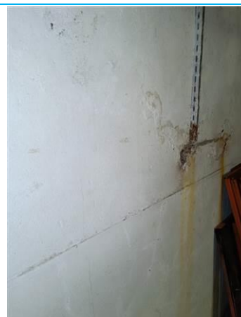
Matériaux : ZPSO-012 Prélèvement : P012 Description : Enduit mural + peinture Localisation : Chaufferie Résultat : Absence d'amiante
