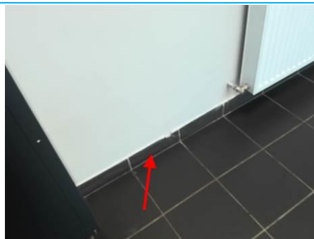
Matériaux : ZPSO-002 Prélèvement : P002 Description : Colle de plinthe carrelage Localisation : Rez de chaussée - Ciruclation 1 Résultat : Absence d'amiante
