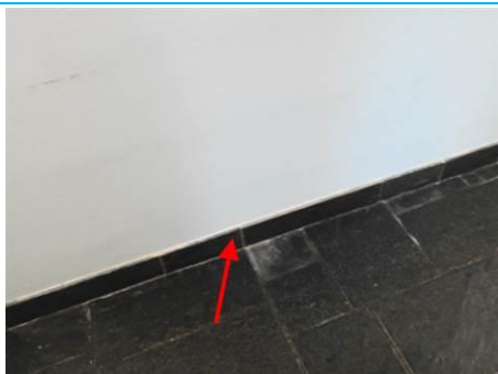
Matériaux : ZPSO-008 Prélèvement : P009 Description : Colle de plinthe carrelage Localisation : Rez de chaussée - Dégagement Résultat : Absence d'amiante
