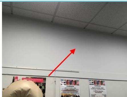
Matériaux : ZPSO-011 Prélèvement : P012 Description : Bandes calicot Localisation : Rez de chaussée - Salle de réunion 152 Résultat : Absence d'amiante
