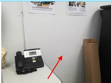
Matériaux : ZPSO-010 Prélèvement : P011 Description : Enduit à base de plâtre lissé ou taloché Localisation : Rez de chaussée - Salle de réunion 152 Résultat : Absence d'amiante
