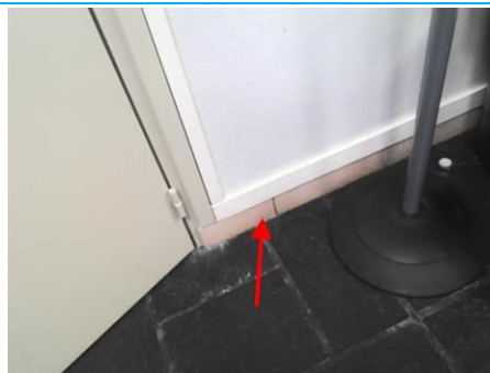
Matériaux : ZPSO-009 Prélèvement : P010 Description : Colle de plinthe carrelage Localisation : Rez de chaussée - Salle de réunion 152 Résultat : Absence d'amiante
