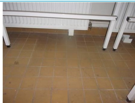
Matériaux : ZPSO-095 Prélèvement : P095 Description : Colle de plinthe Localisation : 5ème étage - S DE TPS A5.1/3 Résultat : Présence d'amiante
