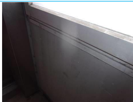
Matériaux : ZPSO-113 Prélèvement : P113 Description : Allège enduit peinture Localisation : 3ème étage - A3 SAS CIR Résultat : Absence d'amiante
