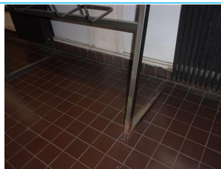
Matériaux : ZPSO-127 Prélèvement : P127 Description : Colle de plinthe Localisation : 3ème étage - S de TP A3.1/3; 3ème étage - TP A3.1a; 3ème étage - TP A3.5/7; 3ème étage - TP A3.7a Résultat : Absence d'amiante
