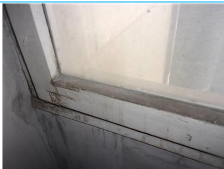
Matériaux : ZPSO-109 Prélèvement : P109 Description : Mastic vitrier Localisation : 5ème étage - B5 SAS CIR Résultat : Présence d'amiante
