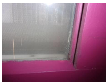
Matériaux : ZPSO-103 Prélèvement : P103 Description : Mastic vitrier Localisation : 4ème étage - S de TP A4.1/3; 4ème étage - S de TP A4.5/7; 4ème étage - A4.14/16/18; 4ème étage - A4.12; 4ème étage - A4.10; 4ème étage - A4.8; 4ème étage - A4.6; 4ème étage - A4.2/4 Résultat : Présence d'amiante
