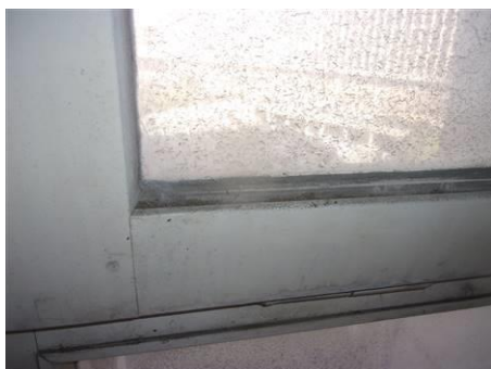
Matériaux : ZPSO-097 Prélèvement : P097 Description : Mastic vitrier Localisation : 5ème étage - C5. 6 Résultat : Absence d'amiante
