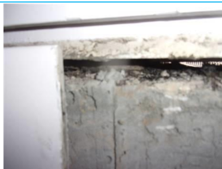
Matériaux : ZPSO-016 Prélèvement : P016 Description : Joint de menuiserie Localisation : 10ème étage - C10. 1; 10ème étage - C10.b 2; 10ème étage - C10.c 2; 10ème étage - C10. 4; 10ème étage - C10.a 5; 10ème étage - C10. 6; 10ème étage - C10. 7; 10ème étage - C10. 8; 10ème étage - C10.a 9; 10ème étage - C10. 10; 10ème étage - C10. 11; 10ème étage - C10. 12; 10ème étage - C10. 13 Résultat : Absence d'amiante
