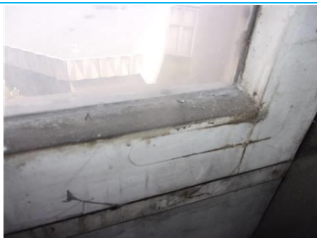
Matériaux : ZPSO-113 Prélèvement : P113 Description : Mastic vitrier Localisation : 3ème étage - B3 SAS CIR Résultat : Présence d'amiante
