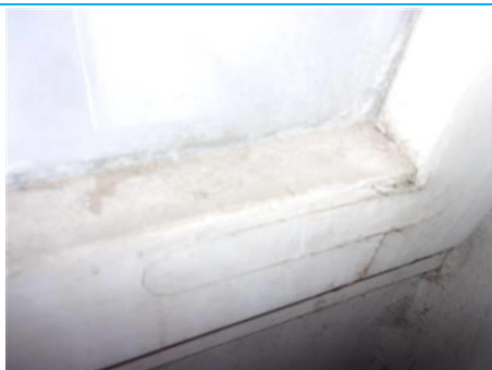
Matériaux : ZPSO-031 Prélèvement : P031 Description : Mastic vitrier Localisation : 8 ème étage - A8.SAS.CIR Résultat : Présence d'amiante
