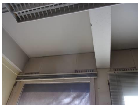
Matériaux : ZPSO-099 Prélèvement : P099 Description : Imposte Localisation : 5ème étage - C5. 1; 5ème étage - C5.4a; 5ème étage - C5. 3; 5ème étage - C5. 5; 5ème étage - C5. 6; 5ème étage - C5. 7; 5ème étage - C5. 9; 5ème étage - C5. 10; 5ème étage - C5. 11; 5ème étage - C5. 12; 5ème étage - C5. 13; 5ème étage - C5. 14; 5ème étage - C5. 15; 5ème étage - C5.14b Résultat : Absence d'amiante
