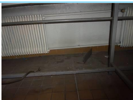
Matériaux : ZPSO-143 Prélèvement : P143 Description : Colle de plinthe Localisation : 2ème étage - A2.1b; 2ème étage - A2.1; 2ème étage - A2.3; 2ème étage - A2.5c; 2ème étage - A2.5d; 2ème étage - A2.7b; 2ème étage - A2.7a Résultat : Présence d'amiante
