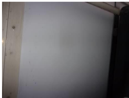
Matériaux : ZPSO-064 Prélèvement : P064 Description : Allèges en fibres ciment Localisation : 7ème étage - C7. 1; 7ème étage - C7.2/4; 7ème étage - C7. 3; 7ème étage - C7. 5; 7ème étage - C7. 6; 7ème étage - C7. 7; 7ème étage - C7. 8; 7ème étage - C7.7a; 7ème étage - C7.10a; 7ème étage - C7.9/9a; 7ème étage - C7. 12; 7ème étage - C7. 14 Résultat : Présence d'amiante
