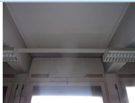
Matériaux : ZPSO-071 Prélèvement : P071 Description : Imposte Localisation : 6ème étage - C2VN 3 LAB; 6ème étage - C2VN 1 LAB A6.7; 6ème étage - A6.18a; 6ème étage - A6.16 C2VN 5 LAB; 6ème étage - A6.14; 6ème étage - A6.12; 6ème étage - A6.10; 6ème étage - A6.8 Reserve sto; 6ème étage - A6.6; 6ème étage - A6.4 Salle prepa; 6ème étage - A6.2 Salle prepa Résultat : Absence d'amiante
