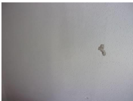
Matériaux : ZPSO-009 Prélèvement : P009 Description : Enduit peinture murs Localisation : 10 ème étage - BUREAU B10.2 BUR Résultat : Absence d'amiante
