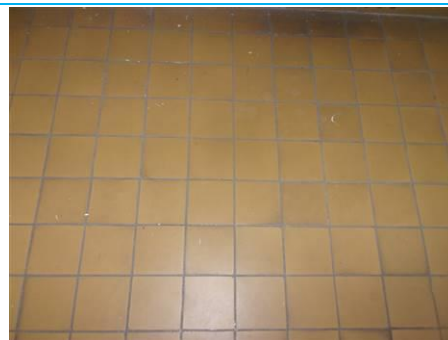
Matériaux : ZPSO-048 Prélèvement : P048 Description : Colle de carrelage ragréage Localisation : 8ème étage - C8.a 1; 8ème étage - C8.2/4; 8ème étage - C8. 3; 8ème étage - C8. 5; 8ème étage - C8. 6; 8ème étage - C8. 7; 8ème étage - C8. 8; 8ème étage - C8. 9; 8ème étage - C8. 10; 8ème étage - C8.11/13; 8ème étage - C8.12b; 8ème étage - C8. 14; 8ème étage - C8. 15; Résultat : Absence d'amiante
