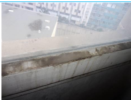
Matériaux : ZPSO-107 Prélèvement : P107 Description : Mastic vitrier Localisation : 6ème étage - B6 SAS CIR Résultat : Présence d'amiante
