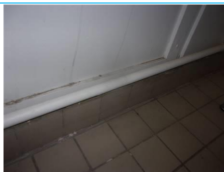
Matériaux : ZPSO-028 Prélèvement : P028 Description : Colle de plinthe Localisation : 9ème étage - C9. 1; 9ème étage - C9. 3; 9ème étage - C9. 5; 9ème étage - C9. 7; 9ème étage - C9. 9; 9ème étage - C9. 11; 9ème étage - C9. 13; 9ème étage - C9. 15 Résultat : Absence d'amiante
