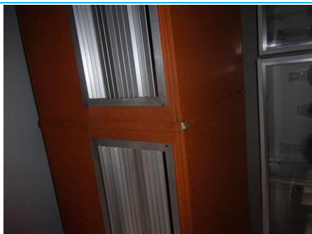
Matériaux : ZPSO-082 Prélèvement : P082 Description : Peinture conduit de ventilation Localisation : 6ème étage - S de cours A6.1/3 TPS Résultat : Absence d'amiante
