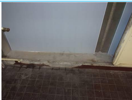
Matériaux : ZPSO-153 Prélèvement : P159 Description : Assise en ciment châssis fenêtre Localisation : 6ème étage - C2VN 1 LAB A6.7 Résultat : Absence d'amiante
