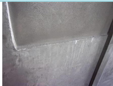
Matériaux : ZPSO-066 Prélèvement : P066 Description : Enduit peinture façade Localisation : 6ème étage - Façades; 5ème étage - Façades Résultat : Absence d'amiante
