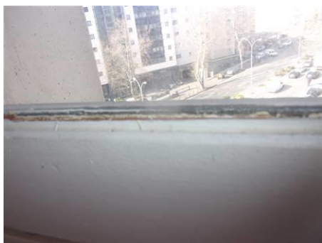
Matériaux : ZPSO-067 Prélèvement : P067 Description : Mastic vitrier Localisation : 5ème étage - ICR B5.11 BUR Résultat : Absence d'amiante
