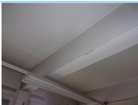
Matériaux : ZPSO-080 Prélèvement : P080 Description : Enduit peinture plafond poutre Localisation : 6ème étage - S de cours A6.1/3 TPS; 6ème étage - C2VN 3 LAB; 6ème étage - C2VN 1 LAB A6.7; 6ème étage - A6.18a; 6ème étage - A6.16 C2VN 5 LAB; 6ème étage - A6.14; 6ème étage - A6.12; 6ème étage - A6.10; 6ème étage - A6.8 Reserve sto; 6ème étage - A6.6; 6ème étage - A6.4 Salle prepa; 6ème étage - A6.2 Salle prepa Résultat : Absence d'amiante
