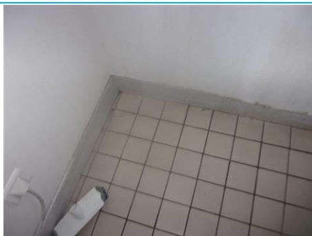
Matériaux : ZPSO-196 Prélèvement : P196Bis Description : colle de carrelage ragréage Localisation : 9 ème étage - Detente A9.10 PAU Résultat : Absence d'amiante Quantité :
