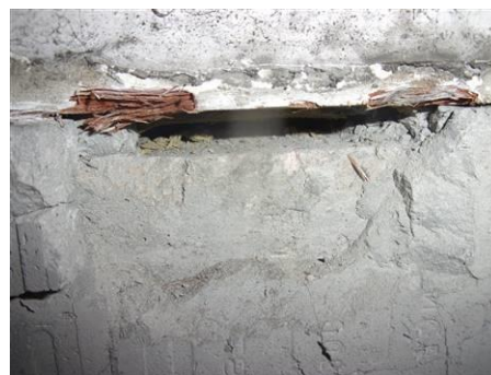
Matériaux : ZPSO-079 Prélèvement : P079 Description : Joint de menuiserie Localisation : 6ème étage - A6.2 Salle prepa Résultat : Présence d'amiante
