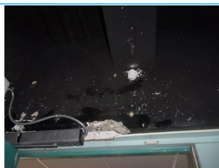
Matériaux : ZPSO-164 Prélèvement : P171 Description : Enduit peinture mur Localisation : 10ème étage - Couloir Résultat : Absence d'amiante
