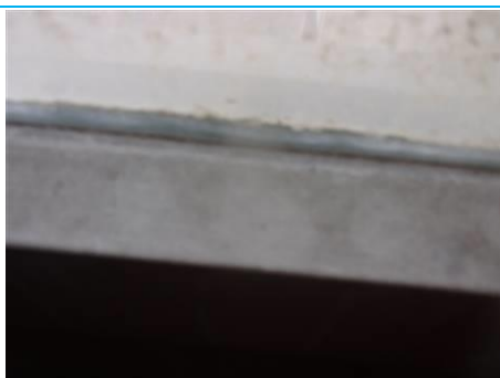
Matériaux : ZPSO-128 Prélèvement : P128 Description : Mastic vitrier Localisation : 2ème étage - A2 SAS CIR Résultat : Présence d'amiante
