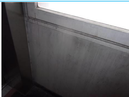
Matériaux : ZPSO-084 Prélèvement : P084 Description : Allège enduit peinture Localisation : 5ème étage - A5 SAS CIR Résultat : Absence d'amiante
