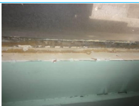
Matériaux : ZPSO-114 Prélèvement : P114 Description : Mastic châssis fixe Localisation : 3ème étage - S de TP A3.1/3; 3ème étage - TP A3.1a; 3ème étage - TP A3.5/7; 3ème étage - TP A3.7a; 3ème étage - A3.12; 3ème étage - A3.10; 3ème étage - A3.8; 3ème étage - A3.4; 3ème étage - A3.2 Résultat : Présence d'amiante
