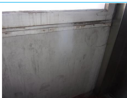
Matériaux : ZPSO-106 Prélèvement : P106 Description : Allège Localisation : 7ème étage - B7 SAS CIR Résultat : Absence d'amiante
