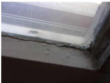
Matériaux : ZPSO-051 Prélèvement : P051 Description : Mastic vitrier Localisation : 7ème étage - Salle de cours/A7.5/7 Résultat : Absence d'amiante
