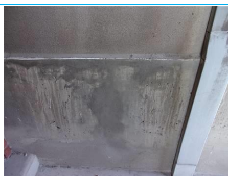
Matériaux : ZPSO-044 Prélèvement : P044 Description : Enduit peinture façade Localisation : 11ème étage - Façades; 10ème étage - Façades; 9ème étage - Façades Résultat : Absence d'amiante
