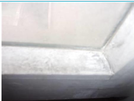
Matériaux : ZPSO-112 Prélèvement : P112 Description : Mastic vitrier Localisation : 3ème étage - A3 SAS CIR Résultat : Présence d'amiante
