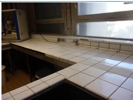
Matériaux : ZPSO-133 Prélèvement : P133 Description : Colle de carrelage pailasse Localisation : 2ème étage - A2.7a Résultat : Absence d'amiante
