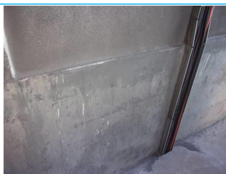
Matériaux : ZPSO-034 Prélèvement : P034 Description : Enduit peinture façade - Localisation : 8 ème étage - Façades; 7ème étage - Façades Résultat : Absence d'amiante
