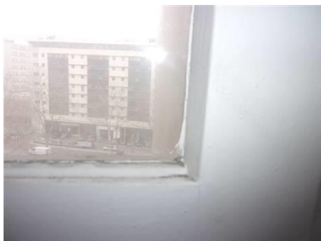
Matériaux : ZPSO-086 Prélèvement : P086 Description : Mastic vitrier Localisation : 5ème étage - A5.6 Résultat : Absence d'amiante
