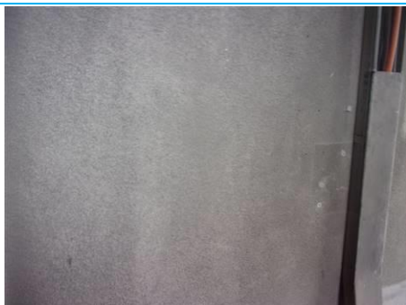
Matériaux : ZPSO-100 Prélèvement : P100 Description : Enduit peinture façade - Localisation : 4ème étage - Façades; 3ème étage - Façades Résultat : Absence d'amiante
