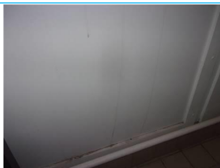
Matériaux : ZPSO-030 Prélèvement : P030 Description : Allèges en fibres-ciment Localisation : 9ème étage - C9. 1; 9ème étage - C9. 2; 9ème étage - C9. 3; 9ème étage - C9. 4; 9ème étage - C9. 5; 9ème étage - C9. 6; 9ème étage - C9. 7; 9ème étage - C9. 8; 9ème étage - C9. 9; 9ème étage - C9. 10; 9ème étage - C9. 11; 9ème étage - C9. 13; 9ème étage - C9. 15 Résultat : Présence d'amiante
