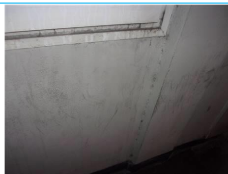
Matériaux : ZPSO-129 Prélèvement : P129 Description : Allège enduit peinture Localisation : 2ème étage - A2 SAS CIR Résultat : Absence d'amiante
