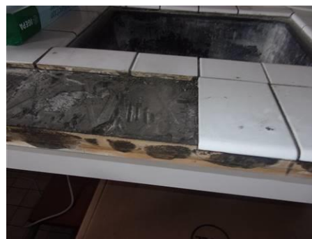
Matériaux : ZPSO-125 Prélèvement : P125 Description : Colle de carrelage pailleasse Localisation : 3ème étage - A3.8 Résultat : Absence d'amiante
