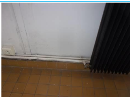
Matériaux : ZPSO-049 Prélèvement : P049 Description : Colle de plinthe Localisation : 8ème étage - C8.a 1; 8ème étage - C8.2/4; 8ème étage - C8. 3; 8ème étage - C8. 5; 8ème étage - C8. 6; 8ème étage - C8. 7; 8ème étage - C8. 8; 8ème étage - C8. 9; 8ème étage - C8. 10; 8ème étage - C8.11/13; 8ème étage - C8.12b; 8ème étage - C8. 14; 8ème étage - C8. 15; Résultat : Absence d'amiante
