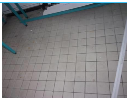
Matériaux : ZPSO-186 Prélèvement : P193 Description : Colle de carrelage ragréage Localisation : 6ème étage - C2VN 1 LAB A6.7 Résultat : Absence d'amiante
