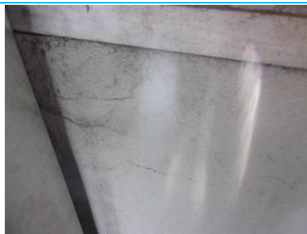
Matériaux : ZPSO-108 Prélèvement : P108 Description : Allège enduit peinture Localisation : 4ème étage - C4.SAS CIR Résultat : Absence d'amiante
