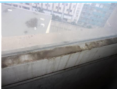
Matériaux : ZPSO-105 Prélèvement : P105 Description : Mastic vitrier Localisation : 7ème étage - B7 SAS CIR Résultat : Présence d'amiante
