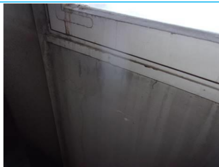
Matériaux : ZPSO-032 Prélèvement : P032 Description : Allège enduit peinture Localisation : 8 ème étage - A8.SAS.CIR Résultat : Absence d'amiante
