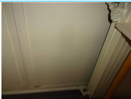
Matériaux : ZPSO-104 Prélèvement : P104 Description : Allèges en fibres ciment Localisation : 4ème étage - S de TP A4.1/3; 4ème étage - S de TP A4.5/7; 4ème étage - A4.14/16/18; 4ème étage - A4.12; 4ème étage - A4.10; 4ème étage - A4.8; 4ème étage - A4.6; 4ème étage - A4.2/4 Résultat : Présence d'amiante
