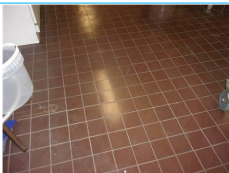
Matériaux : ZPSO-126 Prélèvement : P126 Description : Colle de carrelage ragréage Localisation : 3ème étage - S de TP A3.1/3; 3ème étage - TP A3.1a; 3ème étage - TP A3.5/7; 3ème étage - TP A3.7a Résultat : Absence d'amiante
