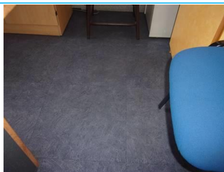
Matériaux : ZPSO-158 Prélèvement : Description : Dalle de sol Localisation : 4ème étage - A4.12 Résultat : Absence d'amiante
