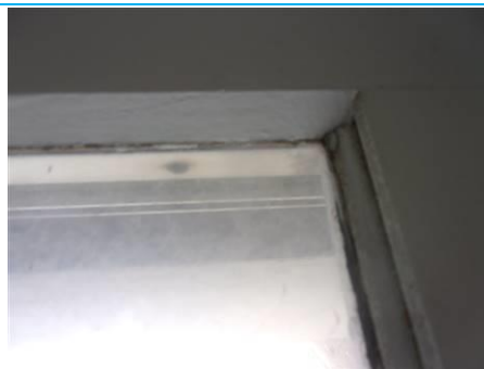
Matériaux : ZPSO-016 Prélèvement : P016 Description : Mastic vitriers partie fixe Localisation : 10 ème étage - BUREAU B10.2 BUR; 10 ème étage - DETENTE B10.4 PAU; 10 ème étage - BUREAU B10.10 BUR; 10 ème étage - BUREAU B10.12 BUR; 10 ème étage - BUREAU B10.14 BUR; 10 ème étage - BUREAU B10.16 BUR; 10 ème étage - BUREAU B10.18 BUR; 10 ème étage - LABO B10.1.b LAB; 10 ème étage - LABO B10.7 LAB; 10 ème étage - LABO B10.7.a LAB; 10 ème étage - LABO B10.7.b LAB; 10 ème étage - TE B10.7c LTE; 9 ème étage - LABO B9.15 LAB; 9 ème étage - LABO B9.9 LAB; 9 ème étage - LABO B9.7 LAB; 9 ème étage - LABO B9.5 b LAB; 9 ème étage - LABO B9.5 a LAB; 9 ème étage - LABO B9.3 LAB; 9 ème étage - BUREAU B9.2 BUR; 9 ème étage - LABO B9.4 LAB; 9 ème étage - LABO B9.6 LAB; 9 ème étage - LABO B9.8 LAB; 9 ème étage - STOCK B9.10 STO; 9 ème étage - BUREAU (FP) B9.12 BUR; 9 ème étage - BUREAU B9.14 BUR; 9 ème étage - BUREAU B9.16 BUR Résultat : Présence d'amiante
