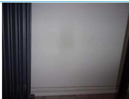
Matériaux : ZPSO-087 Prélèvement : P087 Description : Allèges en fibres ciment Localisation : 5ème étage - S DE TPS A5.1/3; 5ème étage - Salle de prepa A5.5.a; 5ème étage - S De TP A5.5/7 TPS; 5ème étage - ICR Salle de travail STR A5.16/18; 5ème étage - A5.14; 5ème étage - A5.12; 5ème étage - A5.10; 5ème étage - A5.8; 5ème étage - A5.6; 5ème étage - A5.4; 5ème étage - A5.2 BUR Résultat : Présence d'amiante
