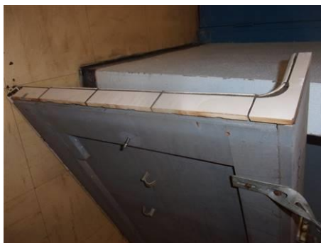
Matériaux : ZPSO-125 Prélèvement : P125 Description : Colle carrelage pailleasse Localisation : 3ème étage - C3.4a Résultat : Absence d'amiante
