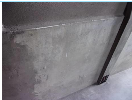
Matériaux : ZPSO-101 Prélèvement : P101 Description : Enduit peinture façade - Localisation : 4ème étage - Façades; 3ème étage - Façades Résultat : Absence d'amiante
