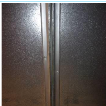
Matériaux : ZPSO-017 Prélèvement : P017 Description : Joints de gaine de ventilation Localisation : 10 ème étage - CIR B10.0 CIR Résultat : Absence d'amiante
