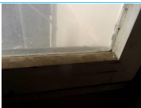
Matériaux : ZPSO-045 Prélèvement : P045 Description : Mastic vitrier Localisation : 8ème étage - C8 SAS CIR Résultat : Présence d'amiante
