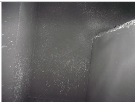
Matériaux : ZPSO-167 Prélèvement : P174 Description : Enduit peinture plafond Localisation : 8ème étage - Couloir Résultat : Absence d'amiante
