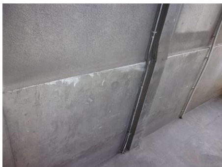
Matériaux : ZPSO-131 Prélèvement : P131 Description : Enduit peinture façade Localisation : 2ème étage - Façades Résultat : Absence d'amiante
