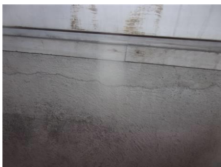
Matériaux : ZPSO-027 Prélèvement : P027 Description : Allège enduit peinture Localisation : 10ème étage - C10 SAS CIR Résultat : Absence d'amiante
