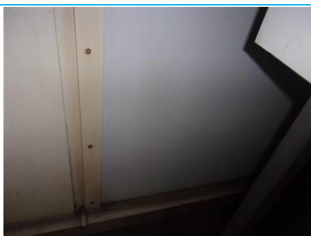
Matériaux : ZPSO-116 Prélèvement : P116 Description : Allèges en fibres ciment Localisation : 3ème étage - TP A3.1a; 3ème étage - TP A3.5/7; 3ème étage - TP A3.7a; 3ème étage - A3.12; 3ème étage - A3.10; 3ème étage - A3.8; 3ème étage - A3.4; 3ème étage - A3.2 Résultat : Présence d'amiante
