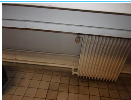
Matériaux : ZPSO-143 Prélèvement : P143 Description : Colle de plinthe Localisation : 2ème étage - C2. 1; 2ème étage - C2. 2; 2ème étage - C2.3c; 2ème étage - C2.3b; 2ème étage - C2. 4; 2ème étage - C2. 5; 2ème étage - C2. 6; 2ème étage - C2. 7; 2ème étage - C2.8a; 2ème étage - C2. 11; 2ème étage - C2. 12; 2ème étage - C2. 13; 2ème étage - C2. 14; 2ème étage - C2. 15 Résultat : Absence d'amiante
