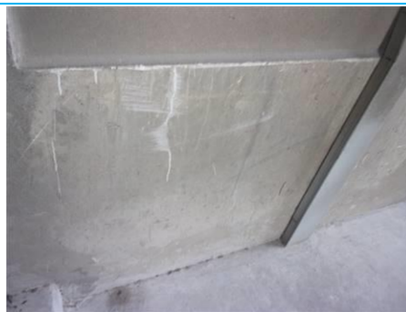
Matériaux : ZPSO-124 Prélèvement : P124 Description : Enduit peinture façade Localisation : 3ème étage - Façades; 2ème étage - Façades Résultat : Absence d'amiante
