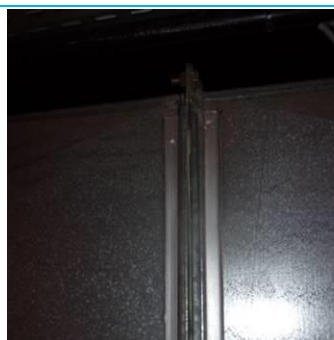
Matériaux : ZPSO-018 Prélèvement : P018 Description : Joints gaines de ventilation Localisation : 10 ème étage - CIR B10.0 CIR Résultat : Présence d'amiante
