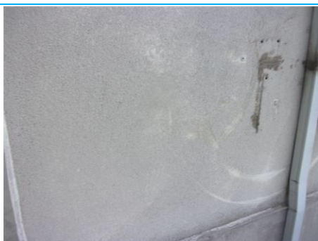
Matériaux : ZPSO-003 Prélèvement : P003 Description : Enduit peinture façade Localisation : 10 ème étage - Façades; 9 ème étage - Façades Résultat : Absence d'amiante
