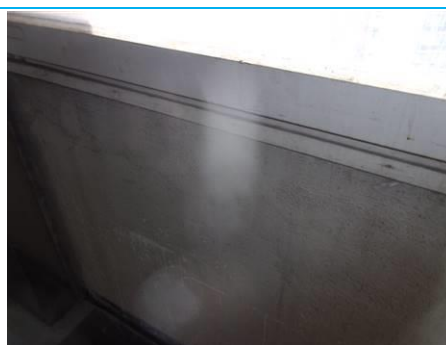
Matériaux : ZPSO-046 Prélèvement : P046 Description : Allège enduit peinture Localisation : 8ème étage - C8 SAS CIR Résultat : Absence d'amiante
