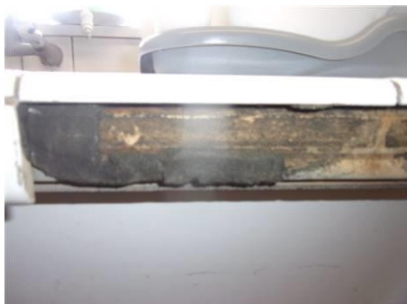
Matériaux : ZPSO-047 Prélèvement : P047 Description : Colle de carrelage pailasse Localisation : 8ème étage - C8. 9 Résultat : Absence d'amiante
