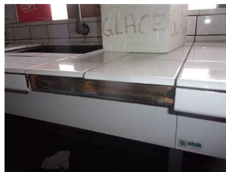
Matériaux : ZPSO-081 Prélèvement : P081 Description : Colle de carrelage pailleasse Localisation : 6ème étage - S de cours A6.1/3 TPS Résultat : Absence d'amiante
