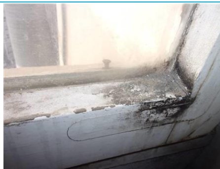
Matériaux : ZPSO-026 Prélèvement : P026 Description : Mastic vitrier Localisation : 10ème étage - C10 SAS CIR Résultat : Présence d'amiante
