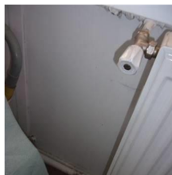
Matériaux : ZPSO-022 Prélèvement : P022 Description : Allèges en fibres-ciment Localisation : 9 ème étage - Salle TP A9.1/3 TPS; 9 ème étage - Salle info A9.5/7 INF; 9 ème étage - Salle TP A9.9/11 TPS; 9 ème étage - Reserve A9.11.a; 9 ème étage - Bureau A9.20 BUR; 9 ème étage - Bureau A9.18 BUR; 9 ème étage - Bureau A9.16 BUR; 9 ème étage - Bureau A9.14 BUR; 9 ème étage - Bureau A9.12 BUR; 9 ème étage - Detente A9.10 PAU; 9 ème étage - Bureau A9.8 BUR; 9 ème étage - Bureau A9.6 BUR; 9 ème étage - Bureau A9.4 BUR; 9 ème étage - Bureau A9.2 BUR Résultat : Présence d'amiante
