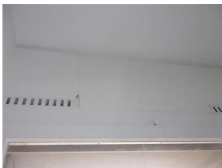
Matériaux : ZPSO-019 Prélèvement : P019 Description : Imposte Localisation : 10ème étage - C10. 4 Résultat : Absence d'amiante
