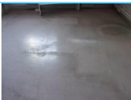
Matériaux : ZPSO-126 Prélèvement : P126 Description : Dalle de sol colle Localisation : 2ème étage - INP B2.2 DES; 2ème étage - INP B2.4 DES Résultat : Absence d'amiante
