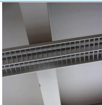
Matériaux : ZPSO-098 Prélèvement : P098 Description : Enduit peinture plafond poutre Localisation : 5ème étage - C5. 1; 5ème étage - C5.4a; 5ème étage - C5. 3; 5ème étage - C5. 5; 5ème étage - C5. 6; 5ème étage - C5. 7; 5ème étage - C5. 9; 5ème étage - C5. 10; 5ème étage - C5. 11; 5ème étage - C5. 12; 5ème étage - C5. 13; 5ème étage - C5. 14; 5ème étage - C5. 15; 5ème étage - C5.14b Résultat : Absence d'amiante
