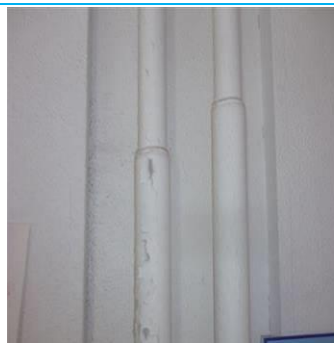
Matériaux : ZPSO-068 Prélèvement : P068 Description : Peinture sur conduit Localisation : 5ème étage - ICR B5.15 BUR; 5ème étage - ICR B5.1 LAB; 5ème étage - ICR B5.2 BUR; 5ème étage - BUREAU ICR B5.12 BUR Résultat : Absence d'amiante
