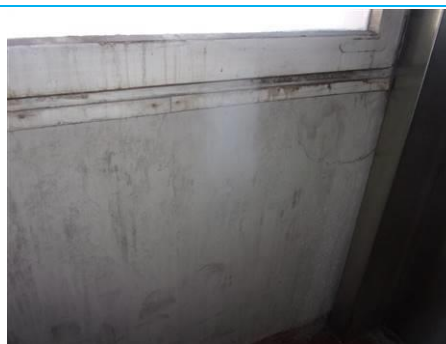
Matériaux : ZPSO-108 Prélèvement : P108 Description : Allège Localisation : 6ème étage - B6 SAS CIR Résultat : Absence d'amiante
