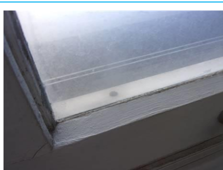
Matériaux : ZPSO-036 Prélèvement : P036 Description : Mastic vitrier Localisation : 8 ème étage - Salle TP A8.1/3 TPS; 8 ème étage - Salle TP A8.5/7 TPS; 8 ème étage - Prepa TP A8.5/7 TPA; 8 ème étage - Salle TD A8.12 TDS; 8 ème étage - Bureau A8.10B BUR; 8 ème étage - Bureau A8.10 BUR; 8 ème étage - Botani Herbiere A8.4 TPS; 8 ème étage - AFF GENERALE A8.2 BUR Résultat : Présence d'amiante
