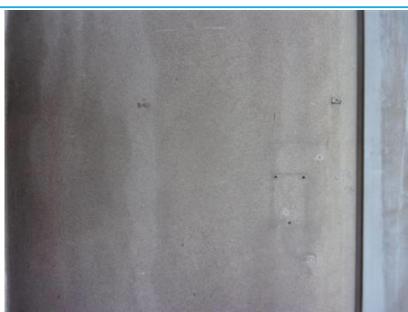
Matériaux : ZPSO-043 Prélèvement : P043 Description : Enduit peinture façade Localisation : 11ème étage - Façades; 10ème étage - Façades; 9ème étage - Façades Résultat : Absence d'amiante
