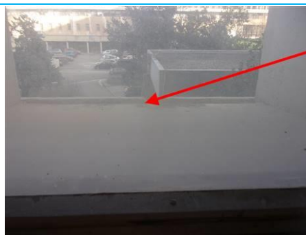
Matériaux : ZPSO-132 Prélèvement : P132 Description : Gargouilles en fibres ciment Localisation : 2ème étage - A2.1b; 2ème étage - A2.1; 2ème étage - A2.3; 2ème étage - A2.5c; 2ème étage - A2.5d; 2ème étage - A2.7b; 2ème étage - A2.7a; 2ème étage - A2.14; 2ème étage - A2.12; 2ème étage - A2.10; 2ème étage - A2.6; 2ème étage - A2.4; 2ème étage - A2.4a; 2ème étage - A2.2 Résultat : Présence d'amiante
