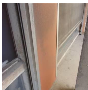
Matériaux : ZPSO-127 Prélèvement : P127 Description : Plaque plane en fibres-ciment en façade Localisation : ensemble des étages Résultat : Présence d'amiante
