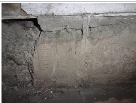
Matériaux : ZPSO-013 Prélèvement : P013 Description : Colle de plinthe Localisation : 10 ème étage - BUREAU B10.2 BUR; 10 ème étage - DETENTE B10.4 PAU; 10 ème étage - BUREAU B10.10 BUR; 10 ème étage - BUREAU B10.12 BUR; 10 ème étage - BUREAU B10.14 BUR; 10 ème étage - BUREAU B10.16 BUR; 10 ème étage - BUREAU B10.18 BUR; 10ème étage - TE B10.7c LTE Résultat : Présence d'amiante
