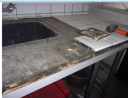
Matériaux : ZPSO-141 Prélèvement : P141 Description : Colle de carrelage paillassse Localisation : 2ème étage - C2. 12 Résultat : Absence d'amiante
