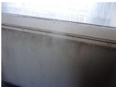
Matériaux : ZPSO-019 Prélèvement : P019 Description : Allèges enduit peinture Localisation : 9 ème étage - A9.SAS.CIR Résultat : Absence d'amiante
