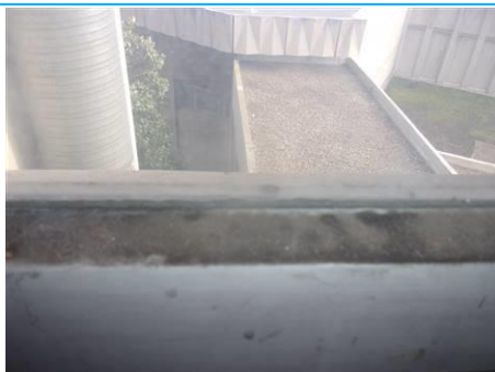
Matériaux : ZPSO-115 Prélèvement : P115 Description : Eléments fibres-ciment Localisation : 2ème étage - B2 SAS CIR Résultat : Présence d'amiante
