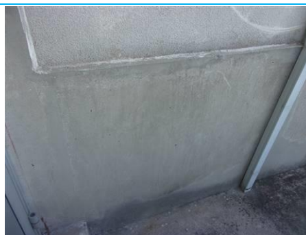
Matériaux : ZPSO-004 Prélèvement : P004 Description : Enduit peinture façade Localisation : 10 ème étage - Façades; 9 ème étage - Façades Résultat : Absence d'amiante
