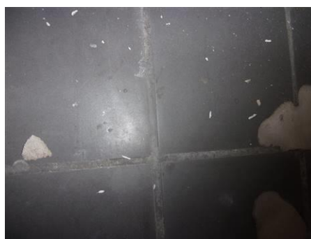
Matériaux : ZPSO-014 Prélèvement : P014 Description : Colle de carrelage ragréage Localisation : 10 ème étage - BUREAU B10.2 BUR; 10 ème étage - DETENTE B10.4 PAU; 10 ème étage - BUREAU B10.10 BUR; 10 ème étage - BUREAU B10.12 BUR; 10 ème étage - BUREAU B10.14 BUR; 10 ème étage - BUREAU B10.16 BUR; 10 ème étage - BUREAU B10.18 BUR; 10ème étage - TE B10.7c LTE Résultat : Absence d'amiante
