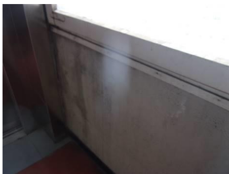
Matériaux : ZPSO-061 Prélèvement : P061 Description : Allège enduit peinture Localisation : 7ème étage - C7 SAS CIR Résultat : Absence d'amiante
