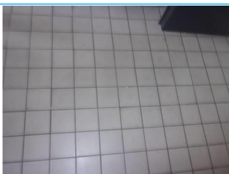
Matériaux : ZPSO-081 Prélèvement : P081 Description : Colle de carrelage ragréage Localisation : 3ème étage - BUREAU 3.2 BUR; 3ème étage - BUREAU 3.4 BUR; 3ème étage - SERVICE C2VN B3.6 LSE Résultat : Absence d'amiante
