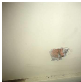
Matériaux : ZPSO-105 Prélèvement : P105 Description : Isolants sous allèges avec pare vapeur bitumineux Localisation : 4ème étage - S de TP A4.1/3; 4ème étage - S de TP A4.5/7; 4ème étage - A4.14/16/18; 4ème étage - A4.12; 4ème étage - A4.10; 4ème étage - A4.8; 4ème étage - A4.6; 4ème étage - A4.2/4 Résultat : Présence d'amiante
