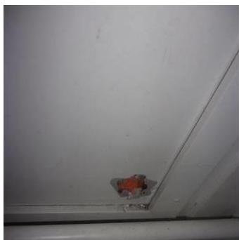
Matériaux : ZPSO-075 Prélèvement : P075 Description : Isolants sous allèges Localisation : 4ème étage - C2VN S TRAVAIL BUR Résultat : Absence d'amiante
