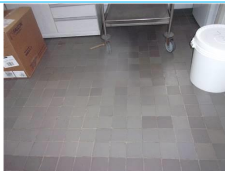
Matériaux : ZPSO-020 Prélèvement : P020 Description : Colle de carrelage ragréage Localisation : 10ème étage - C10. 1; 10ème étage - C10.a 5; 10ème étage - C10. 11; 10ème étage - C10. 13 Résultat : Absence d'amiante
