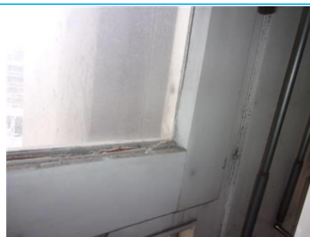
Matériaux : ZPSO-068 Prélèvement : P068 Description : Mastic vitrier - Localisation : 6ème étage - A6.2 Salle prepa Résultat : Absence d'amiante
