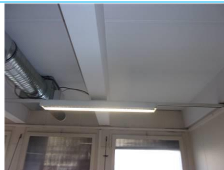
Matériaux : ZPSO-140 Prélèvement : P140 Description : Enduit peinture plafond poutre Localisation : 2ème étage - A2.1b; 2ème étage - A2.1; 2ème étage - A2.3; 2ème étage - A2.5c; 2ème étage - A2.5d; 2ème étage - A2.7b; 2ème étage - A2.7a; 2ème étage - A2.14; 2ème étage - A2.12; 2ème étage - A2.10; 2ème étage - A2.6; 2ème étage - A2.4; 2ème étage - A2.4a; 2ème étage - A2.2 Résultat : Absence d'amiante
