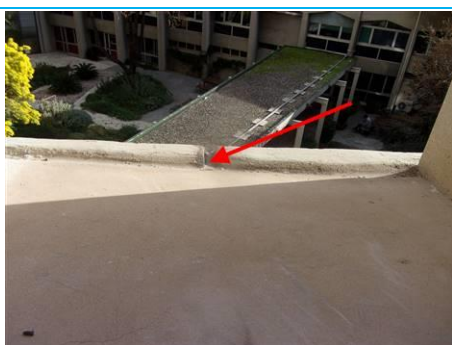
Matériaux : ZPSO-128 Prélèvement : P128 Description : Gargouilles en fibres-ciment sur la façade Localisation : 2ème étage - INP B2.15a DES; 2ème étage - INP B2.15b DES; 2ème étage - BUR INP B2.9c DES; 2ème étage - INP B2.9b DES; 2ème étage - INP B2.9a DES; 2ème étage - INP B2.9c DES; 2ème étage - INP B2.3 DES; 2ème étage - INP B2.3b DES; 2ème étage - INP B2.2 DES; 2ème étage - INP B2.4 DES; 2ème étage - INP B2.6 DES; 2ème étage - INP B2.8 DES; 2ème étage - INP B2.10 DES Résultat : Présence d'amiante
