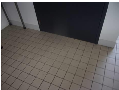
Matériaux : ZPSO-182 Prélèvement : P189 Description : Colle de carrelage ragréage Localisation : 9 ème étage - Reserve A9.11.a Résultat : Absence d'amiante
