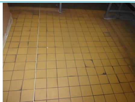
Matériaux : ZPSO-142 Prélèvement : P142 Description : Colle de carrelage ragréage Localisation : 2ème étage - A2.1b; 2ème étage - A2.1; 2ème étage - A2.3; 2ème étage - A2.5c; 2ème étage - A2.5d; 2ème étage - A2.7b; 2ème étage - A2.7a Résultat : Absence d'amiante
