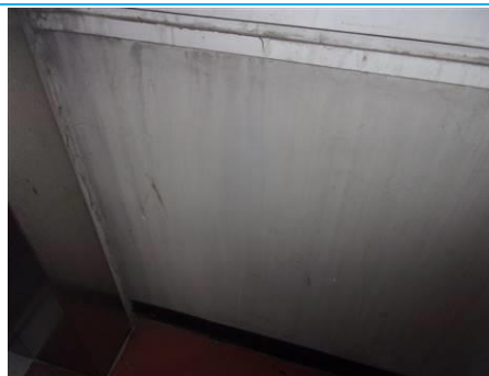
Matériaux : ZPSO-052 Prélèvement : P052 Description : Allèges en fibres-ciment Localisation : 7ème étage - Salle de Prepa/A7.1.a; 7ème étage - Salle de cours/A7.5/7; 7ème étage - Salle de cours/A7.5/7 2; 7ème étage - PREPA TP A7.14/16 TPA; 7ème étage - Reserve A7/12 STO; 7ème étage - Local Stockage A7.10 STO; 7ème étage - Droguier A7.6 EXP; 7ème étage - Piece broyage A7.4 ATE; 7ème étage - Bureau Imbe A7.2 BUR; Résultat : Présence d'amiante
