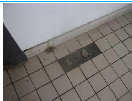
Matériaux : ZPSO-195 Prélèvement : P195Bis Description : colle de carrelage ragréage Localisation : 9 ème étage - Salle TP A9.1/3 TPS Résultat : Absence d'amiante Quantité :
