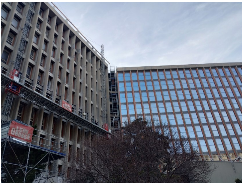
Figure 4 : Photo de la façade rénoverée (à droite) et de la façade en cours de rénovation (à gauche)
