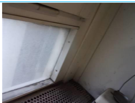
Matériaux : ZPSO-126 Prélèvement : P126 Description : Mastic vitrier partie fixe Localisation : 3ème étage - C3. 1; 3ème étage - C3.4a; 3ème étage - C3. 3; 3ème étage - C3. 5; 3ème étage - C3.4/6; 3ème étage - C3. 7; 3ème étage - C3.8/10; 3ème étage - C3. 9; 3ème étage - C3. 11; 3ème étage - C3. 12; 3ème étage - C3. 13; 3ème étage - C3. 14; 3ème étage - C3. 15 Résultat : Présence d'amiante
