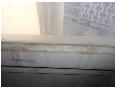
Matériaux : ZPSO-103 Prélèvement : P103 Description : Mastic vitrier Localisation : 8ème étage - B8 SAS CIR Résultat : Présence d'amiante
