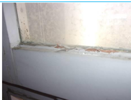
Matériaux : ZPSO-118 Prélèvement : P118 Description : Mastic vitrier Localisation : 2ème étage - INP B2.15a DES; 2ème étage - INP B2.15b DES; 2ème étage - BUR INP B2.9c DES; 2ème étage - INP B2.9b DES; 2ème étage - INP B2.9a DES; 2ème étage - INP B2.9c DES; 2ème étage - INP B2.3 DES; 2ème étage - INP B2.3b DES; 2ème étage - INP B2.2 DES; 2ème étage - INP B2.4 DES; 2ème étage - INP B2.6 DES; 2ème étage - INP B2.8 DES; 2ème étage - INP B2.10 DES Résultat : Présence d'amiante
