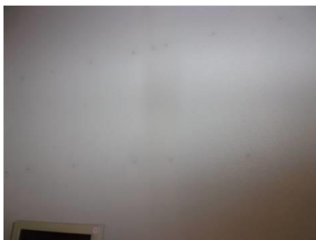
Matériaux : ZPSO-139 Prélèvement : P139 Description : Enduit peinture mur Localisation : 2ème étage - A2.1b; 2ème étage - A2.7a; 2ème étage - A2.2 Résultat : Absence d'amiante
