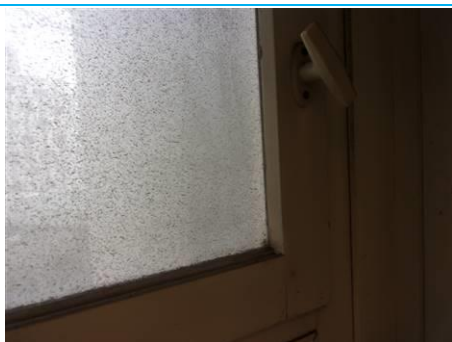
Matériaux : ZPSO-127 Prélèvement : P127 Description : Mastic vitrier Localisation : 3ème étage - C3. 1; 3ème étage - C3.4a; 3ème étage - C3. 3; 3ème étage - C3. 5; 3ème étage - C3.4/6; 3ème étage - C3. 7; 3ème étage - C3.8/10; 3ème étage - C3. 9; 3ème étage - C3. 11; 3ème étage - C3. 12; 3ème étage - C3. 13; 3ème étage - C3. 14; 3ème étage - C3. 15 Résultat : Présence d'amiante
