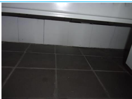
Matériaux : ZPSO-021 Prélèvement : P021 Description : Colle de plinthe Localisation : 10ème étage - C10. 1; 10ème étage - C10.a 5; 10ème étage - C10. 7; 10ème étage - C10.a 9; 10ème étage - C10. 11; 10ème étage - C10. 13 Résultat : Absence d'amiante
