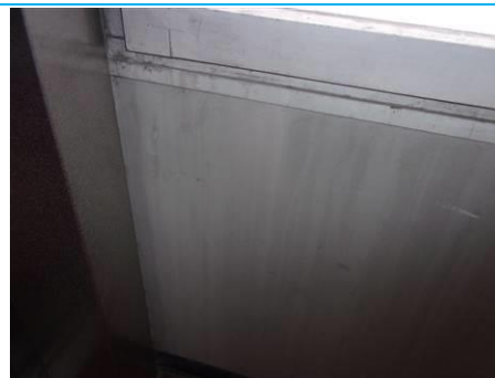
Matériaux : ZPSO-099 Prélèvement : P099 Description : Allège enduit peinture Localisation : 4ème étage - A4 SAS CIR Résultat : Absence d'amiante
