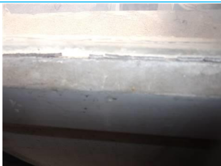
Matériaux : ZPSO-107 Prélèvement : P107 Description : Mastic vitrier Localisation : 4ème étage - C4.SAS CIR Résultat : Présence d'amiante
