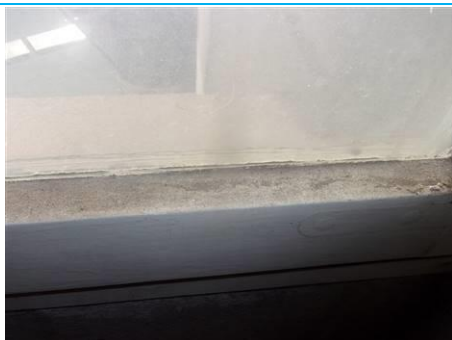
Matériaux : ZPSO-075 Prélèvement : P075 Description : Mastic vitrier Localisation : 6ème étage - C6.SAS CIR Résultat : Présence d'amiante
