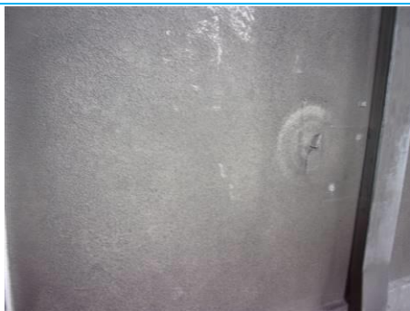
Matériaux : ZPSO-065 Prélèvement : P065 Description : Enduit peinture façade Localisation : 6ème étage - Façades; 5ème étage - Façades Résultat : Absence d'amiante
