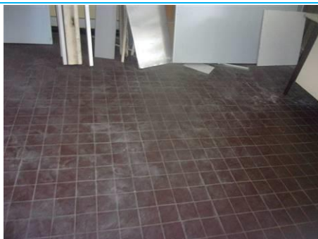
Matériaux : ZPSO-187 Prélèvement : P194 Description : Colle de carrelage ragréage Localisation : 6ème étage - A6.18a Résultat : Absence d'amiante
