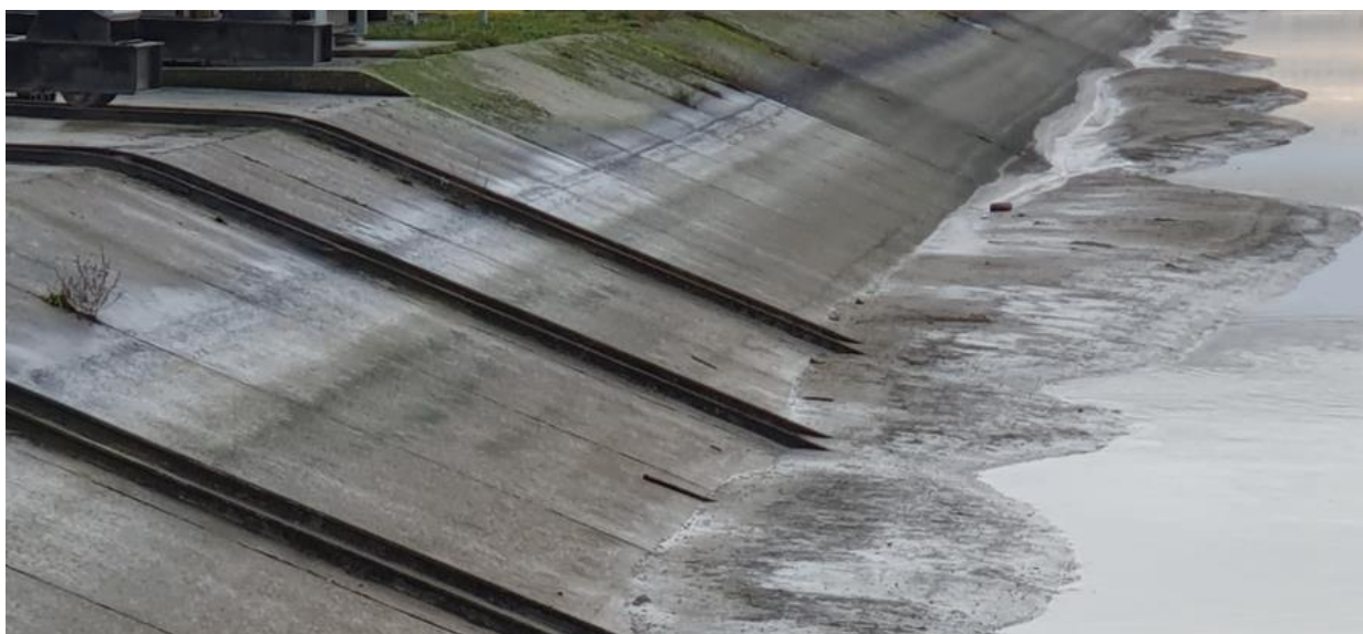
Figure 5 : Atterrissements des sédiments sur la rampe (le niveau d'eau est en dessous de la normale)
