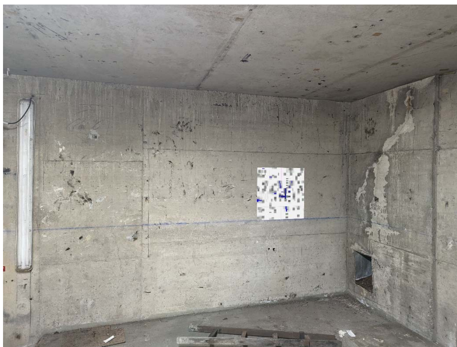
Scan fenêtre réalisé sur le mur de soutènement de la station de réfrigération
