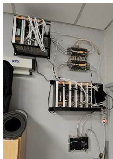
Vue des équipements de distribution de la télévision
