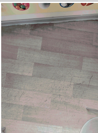
Prélèvement - P009 : R+1 / S 1.31 - Lé plastique avec sous-couche- (Absence d'amiante)
