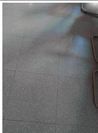
Prélèvement - P002 : RDC / LOCAL S 0.07 PASTEL - Lé plastique avec sous-couche- (Absence d'amiante)
