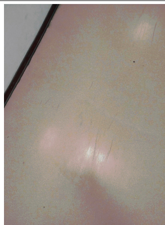
Prélèvement - P008 : R+1 / S 1.44 - Lé plastique avec sous-couche- (Absence d'amiante)
