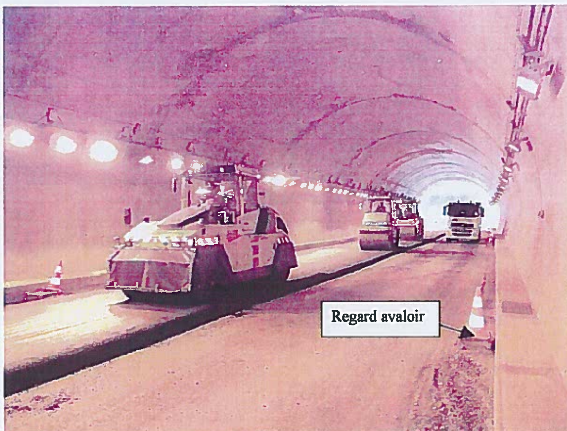
Assainissement dans le tunnel
