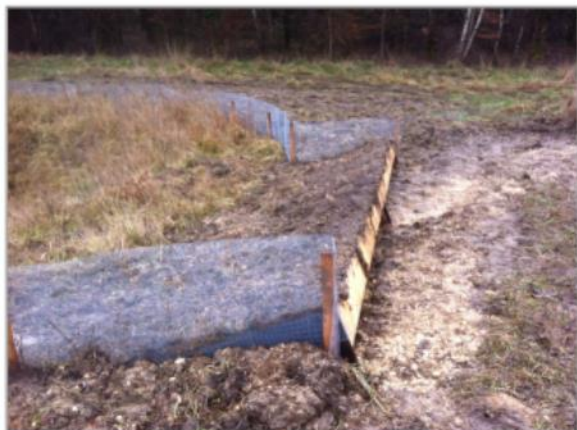
Dispositif d'échappatoire avec la clôture amphibien plaquée
