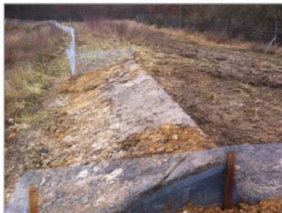
Dispositif d'échappatoire avec la clôture amphibien plaquée
