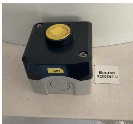
Figure 10 : Bouton de rondier du bâtiment 330
