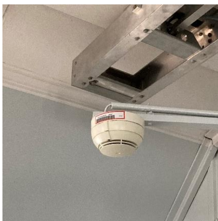
Figure 8 : Détection Alarme Incendie du bâtiment 330
