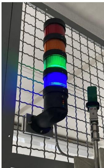
Figure 13 : Signalisation visuelle de l'aire grillagée du bâtiment 330
