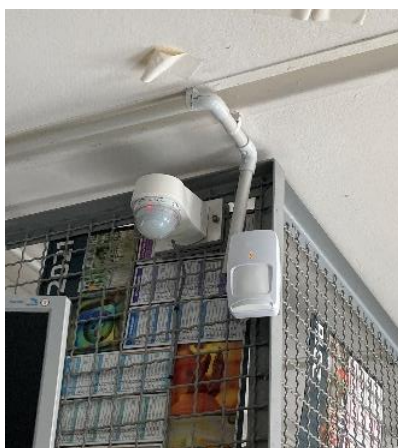
Figure 9 : Radar volumétrique du bâtiment 330
