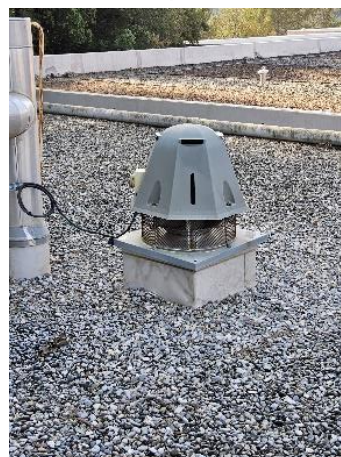
Tourelle d'extraction simple-flux
