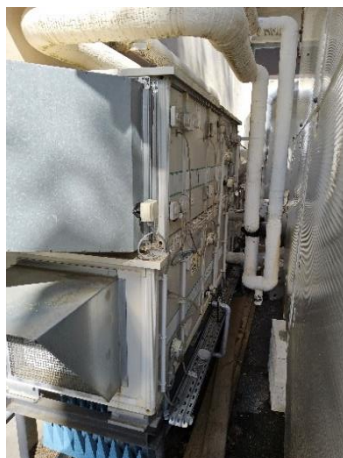
CTA de l'espace robotique du bâtiment KAHN (non fonctionnelle)
