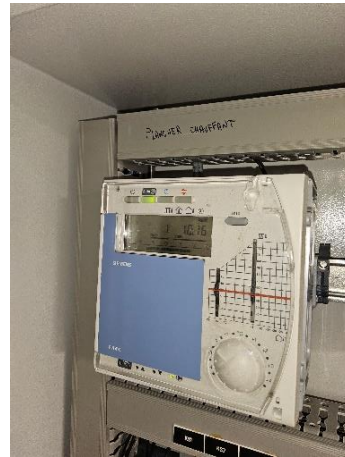
Régulateur du plancher chauffant du bâtiment KAHN
