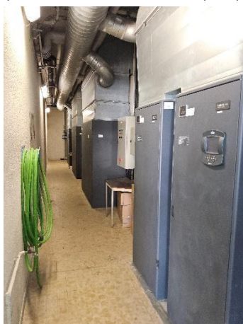
Armoires de climatisation du Data Center
