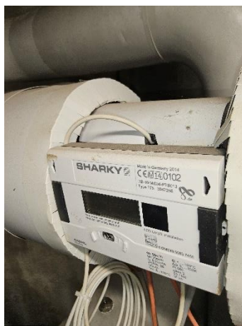
Compteur de frigorie sur départ d'eau glacée
