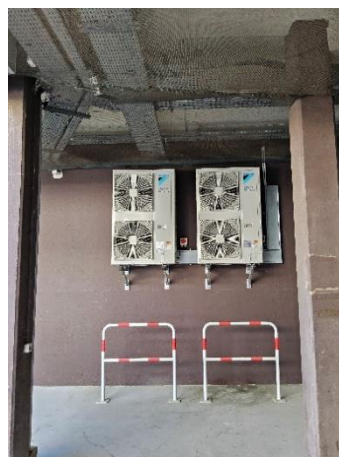
Unités extérieures de climatisation pour les onduleurs
