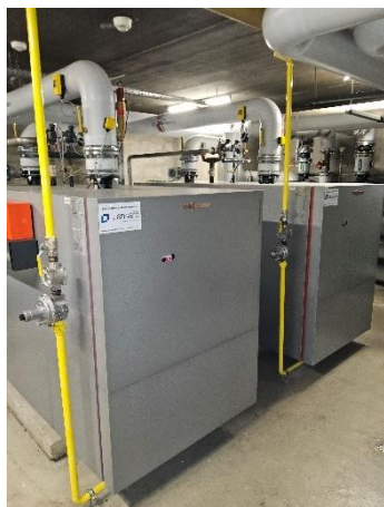
Chaudières gaz à condensation
