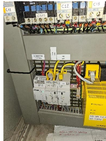
Sous-compteur électrique pour local technique en toiture
