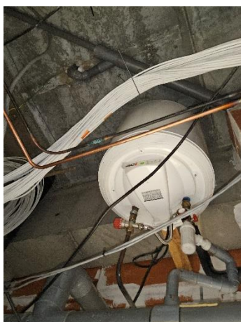
Ballon électrique en faux-plafond
