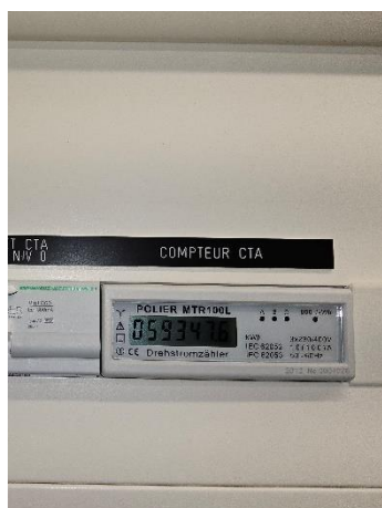
Sous-compteur électrique CTA
