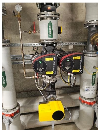
Départ régulé vers ventilo-convecteurs/plancher chauffant
