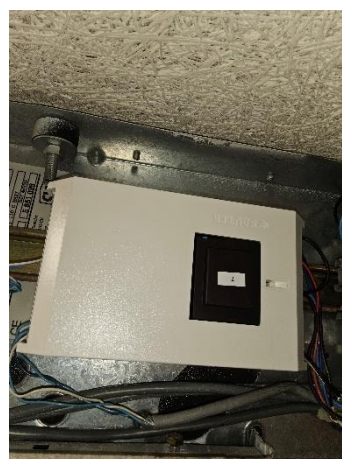
Régulateur des ventilo-convecteurs
