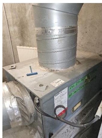
Caisson d'extraction simple-flux
