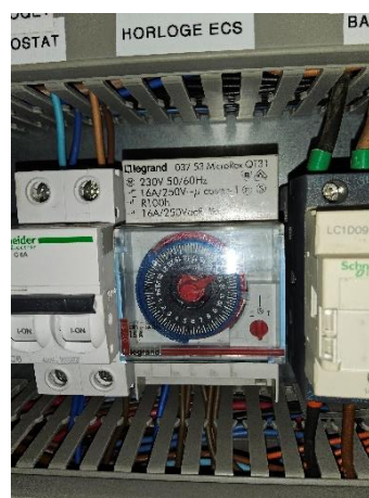
Horloge pour les ballons ECS de la cuisine
