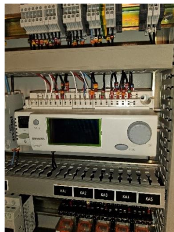
Régulateur CTA du hall du bâtiment KAHN
