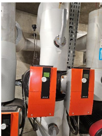
Pompes à débit variable sur départ froid
