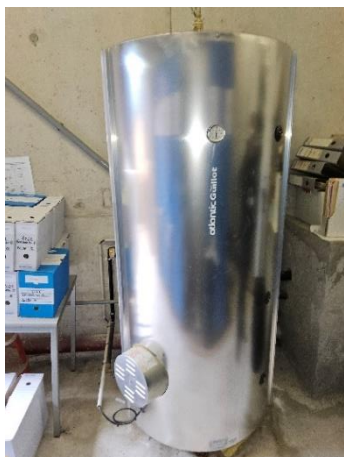
Ballon ECS des douches du bâtiment AMPERE
