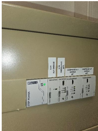
Sous-compteurs électriques dans un TD
