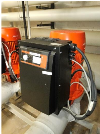
Pompes de chauffage en sous-station principale
