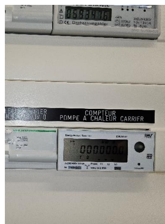
Sous-compteur électrique PAC
