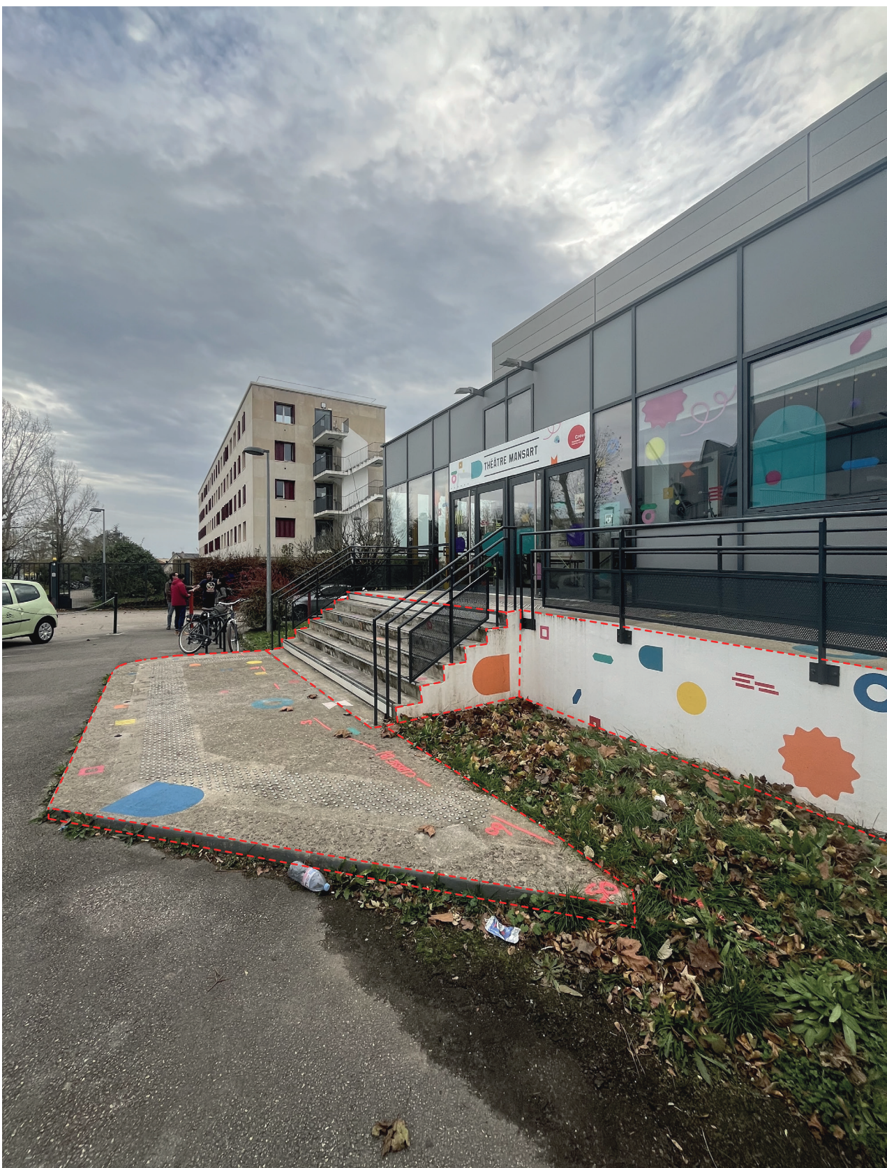
Escalier d'entrée non conforme
