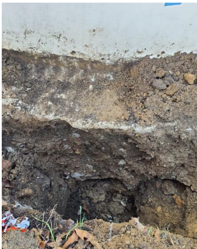
Figure 3 : Photographie de la reconnaissance de fondation RF21
