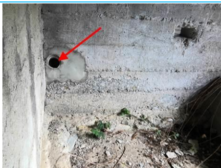
Matériaux : ZPSO-001 Prélèvement : P001 Description : Conduit en fibres-ciment Localisation : Local 1; Local 2; Parties extérieures Résultat : Présence d'amiante
