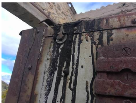
Matériaux : ZPSO-005 Prélèvement : P007 Description : Revêtement bitumineux Localisation : Rez de chaussée - Local 1 Résultat : Absence d'amiante
