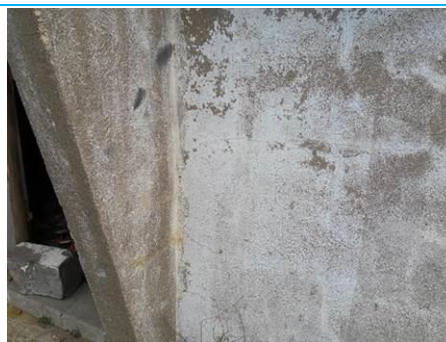
Matériaux : ZPSO-006 Prélèvement : P006 Description : Enduit extérieur (projeté, lissé ou taloché) Localisation : Façade Nord; Façade Sud; Façade Est; Façade Ouest Résultat : Absence d'amiante
