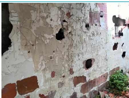
Matériaux : ZPSO-003 Prélèvement : P003 Description : Enduit à base de plâtre lissé ou taloché Localisation : Local 1 Résultat : Absence d'amiante
