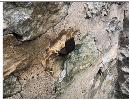
Matériaux : ZPSO-004 Prélèvement : P006 Description : Enduit de scellement Localisation : Rez de chaussée - Local 1 Résultat : Absence d'amiante
