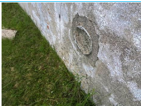
Matériaux : ZPSO-005 Prélèvement : P005 Description : Conduit en fibres-ciment Localisation : Local 1; Façade Nord; Façade Ouest Résultat : Présence d'amiante
