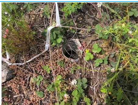
Matériaux : ZPSO-005 Prélèvement : P005 Description : Conduit en fibres-ciment Localisation : Rez de jardin - Local 4; Rez de jardin - Local 5 Résultat : Présence d'amiante
