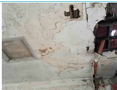
Matériaux : ZPSO-004 Prélèvement : P004 Description : Enduit à base de plâtre lissé ou taloché Localisation : Local 1 Résultat : Absence d'amiante
