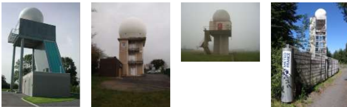
Exemples d'architectures de bâtiments radar, les salles techniques principales sont situées sous le radôme qui protège l'antenne, les salles techniques énergie sont au sol
