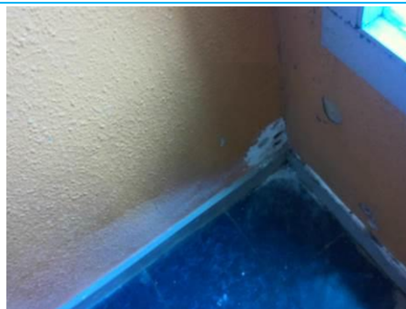
Matériaux : ZPSO-105 Prélèvement : P112 Description : Panneaux de cloisons lisses ou moulurées, préfabriquées ou non Localisation : 2ème étage - Palier 1 Résultat : Présence d'amiante
