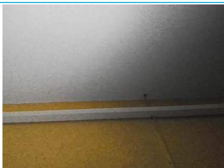
Matériaux : ZPSO-092 Prélèvement : P099 Description : Enduit à base de plâtre lissé ou taloché Localisation : 1er étage - Escalier 3 Résultat : Absence d'amiante
