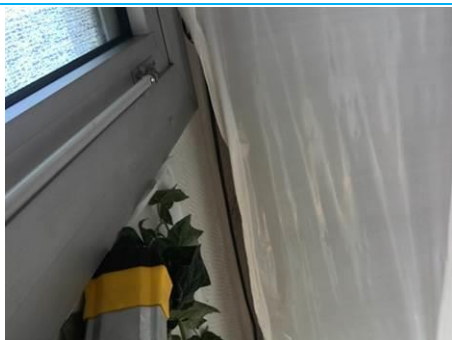
Matériaux : ZPSO-067 Prélèvement : P067 Description : Enduit à base de plâtre lissé ou taloché Localisation : 1er étage - D-214 Résultat : Absence d'amiante
