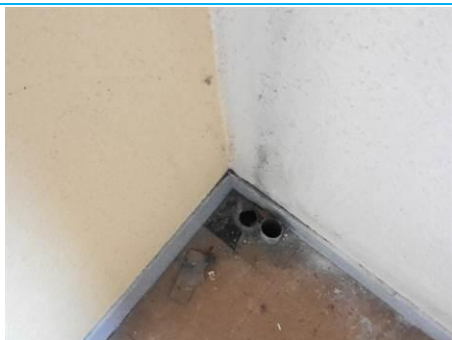
Matériaux : ZPSO-088 Prélèvement : P091 Description : Dalle de sol marron + colle noire Localisation : 1er étage - D-207 Résultat : Présence d'amiante
