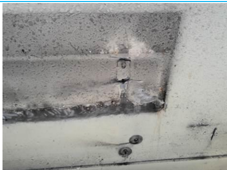
Matériaux : ZPSO-005 Prélèvement : P005 Description : Béton + peinture Localisation : 1er étage - Rgt D-201 Résultat : Présence d'amiante
