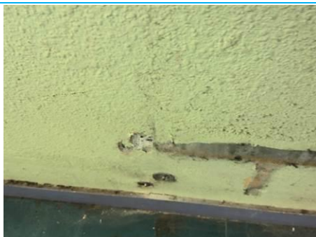
Matériaux : ZPSO-079 Prélèvement : P079 Description : Béton + peinture Localisation : 1er étage - Dgt 1 Résultat : Absence d'amiante
