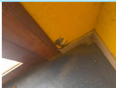
Matériaux : ZPSO-142 Prélèvement : P164 Description : Béton + peinture Localisation : Rez de chaussée - Cage d'escalier 3 Résultat : Absence d'amiante
