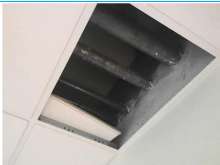
Matériaux : ZPSO-159 Prélèvement : P183 Description : Enduit à base de plâtre lissé ou taloché Localisation : Rez de jardin - Sanit. H Résultat : Présence d'amiante
