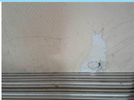
Matériaux : ZPSO-011 Prélèvement : P011 Description : Cloison plâtre Localisation : 1er étage - D-202 Résultat : Absence d'amiante
