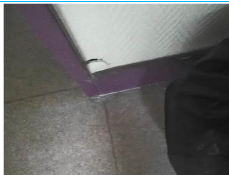
Matériaux : ZPSO-184 Prélèvement : P208 Description : Cloison plâtre Localisation : 2ème étage - Ch. 19 Résultat : Absence d'amiante
