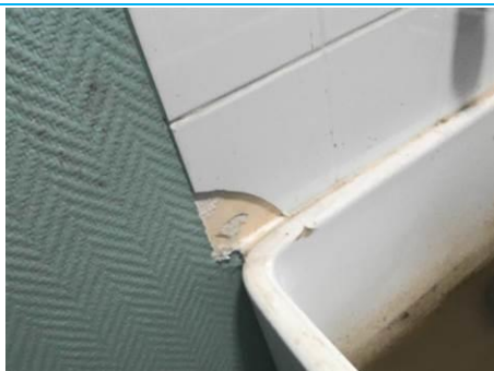
Matériaux : ZPSO-085 Prélèvement : P085 Description : Colle de faïence Localisation : 1er étage - Rgt D-210 Résultat : Absence d'amiante
