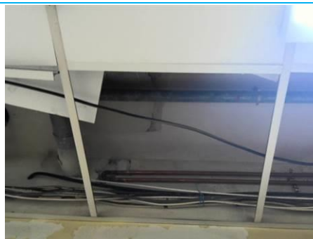
Matériaux : ZPSO-056 Prélèvement : P056 Description : Enduit à base de plâtre lissé ou taloché Localisation : 1er étage - Rgt D-212 Résultat : Présence d'amiante
