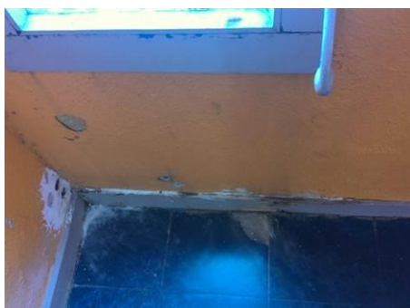
Matériaux : ZPSO-104 Prélèvement : P111 Description : Béton + peinture Localisation : 2ème étage - Palier 1 Résultat : Présence d'amiante
