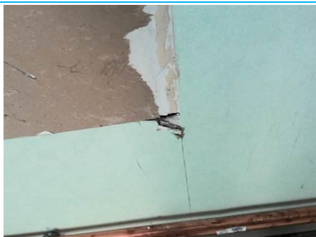
Matériaux : ZPSO-128 Prélèvement : P135 Description : doublage placo plâtre Localisation : 2ème étage - Ch. 7 Résultat : Absence d'amiante
