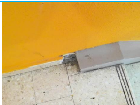
Matériaux : ZPSO-091 Prélèvement : P097 Description : Colle de plinthes Localisation : 1er étage - Escalier 1 Résultat : Présence d'amiante
