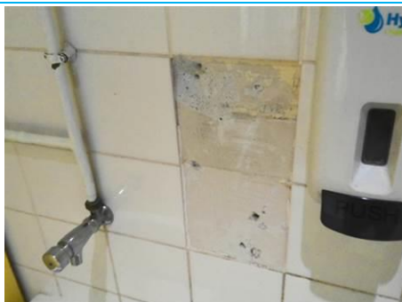
Matériaux : ZPSO-086 Prélèvement : P087 Description : Colle de faïence Localisation : 1er étage - Sanitaires G Résultat : Absence d'amiante
