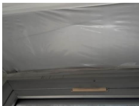
Matériaux : ZPSO-070 Prélèvement : P070 Description : Enduit à base de plâtre lissé ou taloché Localisation : 1er étage - Rgt D-214 Résultat : Absence d'amiante
