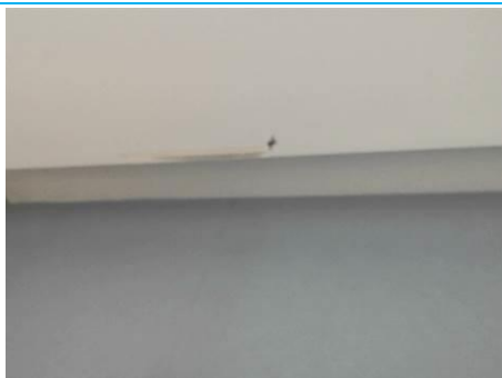
Matériaux : ZPSO-126 Prélèvement : P147 Description : Placo plâtre Localisation : 2ème étage - Ch. 3 Résultat : Absence d'amiante
