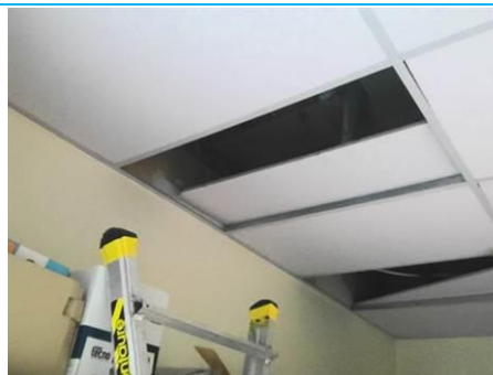
Matériaux : ZPSO-194 Prélèvement : P218 Description : Panneaux et plaques Localisation : 1er étage - Salle coiffure Résultat : Absence d'amiante
