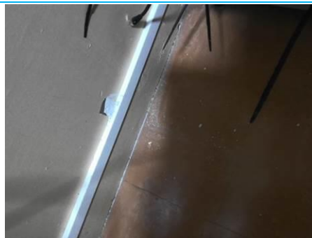
Matériaux : ZPSO-036 Prélèvement : P036 Description : Cloison plâtre Localisation : 1er étage - Rgt D-208 Résultat : Absence d'amiante
