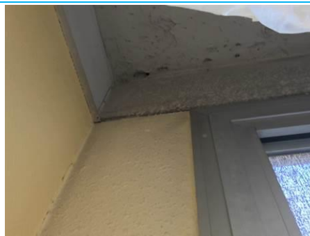
Matériaux : ZPSO-064 Prélèvement : P064 Description : Enduit à base de plâtre lissé ou taloché Localisation : 1er étage - D-213 Résultat : Absence d'amiante
