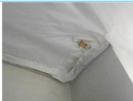
Matériaux : ZPSO-158 Prélèvement : P182 Description : Enduit à base de plâtre lissé ou taloché Localisation : Rez de jardin - Dgt 1 Résultat : Présence d'amiante
