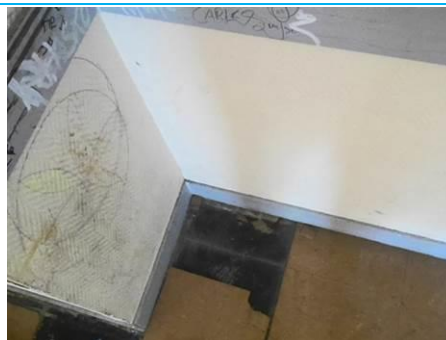
Matériaux : ZPSO-088 Prélèvement : P092 Description : Dalle de sol marron + colle noire Localisation : 1er étage - D-207 Résultat : Présence d'amiante
