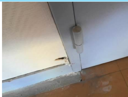
Matériaux : ZPSO-066 Prélèvement : P066 Description : Cloison plâtre Localisation : 1er étage - D-213 Résultat : Absence d'amiante
