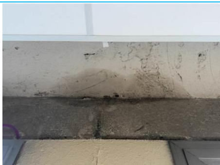
Matériaux : ZPSO-001 Prélèvement : P001 Description : Enduit à base de plâtre lissé ou taloché Localisation : 1er étage - D-201 Résultat : Présence d'amiante
