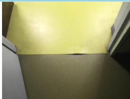
Matériaux : ZPSO-192 Prélèvement : P216 Description : Ragréage + colle Localisation : 1er étage - Salon de coiffure 1 Résultat : Absence d'amiante
