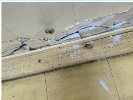
Matériaux : ZPSO-057 Prélèvement : P057 Description : Cloison plâtre Localisation : 1er étage - Rgt D-212 Résultat : Absence d'amiante
