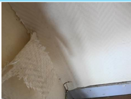
Matériaux : ZPSO-039 Prélèvement : P039 Description : Cloison plâtre Localisation : 1er étage - D-209 Résultat : Absence d'amiante
