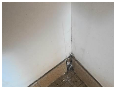
Matériaux : ZPSO-170 Prélèvement : P194 Description : Joint de plinthes Localisation : 2ème étage - Sanitaires Résultat : Absence d'amiante
