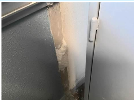
Matériaux : ZPSO-045 Prélèvement : P045 Description : Cloison plâtre Localisation : 1er étage - Rgt D-210 Résultat : Absence d'amiante
