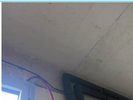
Matériaux : ZPSO-049 Prélèvement : P049 Description : Enduit à base de plâtre lissé ou taloché Localisation : 1er étage - D-211 Résultat : Présence d'amiante
