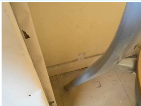
Matériaux : ZPSO-063 Prélèvement : P063 Description : Cloison plâtre Localisation : 1er étage - Rgt D-213 Résultat : Absence d'amiante
