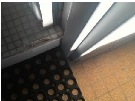
Matériaux : ZPSO-177 Prélèvement : P201 Description : Colle de carrelage Localisation : 2ème étage - Sanitaires Résultat : Absence d'amiante
