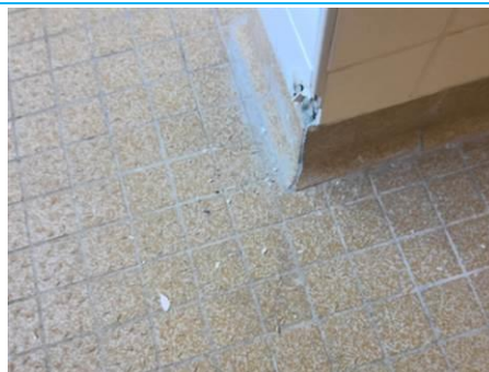
Matériaux : ZPSO-178 Prélèvement : P202 Description : Colle de faïence Localisation : 2ème étage - Sanitaires Résultat : Absence d'amiante
