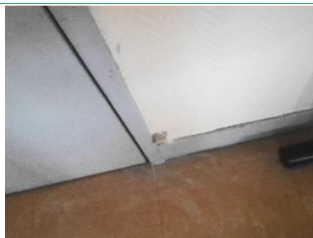
Matériaux : ZPSO-060 Prélèvement : P060 Description : Cloison plâtre Localisation : 1er étage - D-212 Résultat : Absence d'amiante
