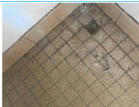
Matériaux : ZPSO-174 Prélèvement : P198 Description : Ragréage Localisation : 2ème étage - Sanitaires Résultat : Absence d'amiante
