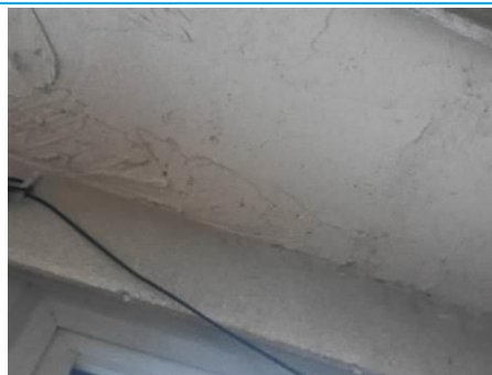
Matériaux : ZPSO-058 Prélèvement : P058 Description : Enduit à base de plâtre lissé ou taloché Localisation : 1er étage - D-212 Résultat : Absence d'amiante
