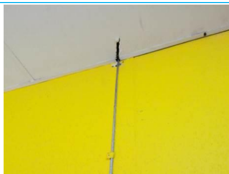
Matériaux : ZPSO-107 Prélèvement : P114 Description : Panneaux et plaques Localisation : 2ème étage - Palier 2 Résultat : Absence d'amiante
