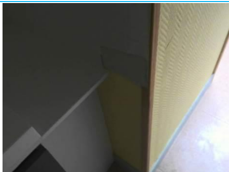
Matériaux : ZPSO-179 Prélèvement : P203 Description : Colle de faïence Localisation : 2ème étage - Ch. 19 Résultat : Absence d'amiante
