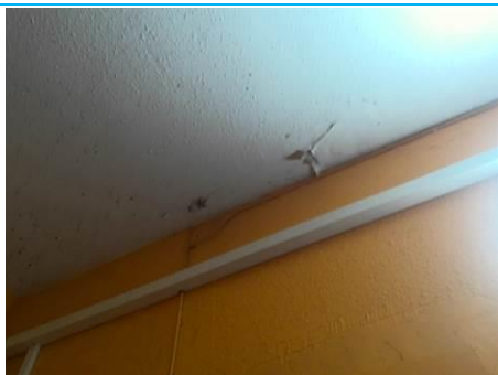
Matériaux : ZPSO-157 Prélèvement : P181 Description : Enduit à base de plâtre lissé ou taloché Localisation : Rez de jardin - Escalier 1 Résultat : Présence d'amiante
