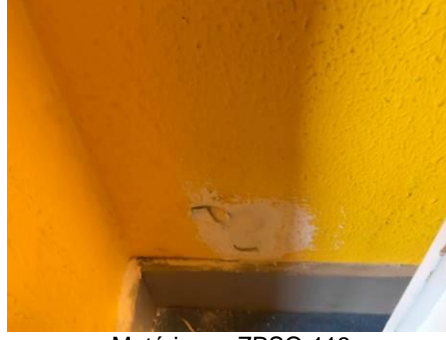
Matériaux : ZPSO-113 Prélèvement : P120 Description : Panneaux de cloisons lisses ou moulurées, préfabriquées ou non Localisation : 2ème étage - Palier 3 Résultat : Absence d'amiante
