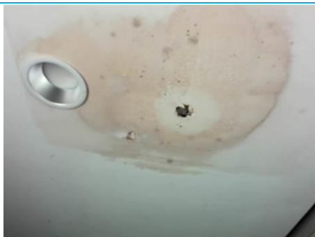
Matériaux : ZPSO-126 Prélèvement : P133 Description : Placo plâtre Localisation : 2ème étage - Ch. 7 Résultat : Absence d'amiante
