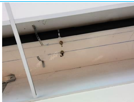
Matériaux : ZPSO-018 Prélèvement : P018 Description : Enduit à base de plâtre lissé ou taloché Localisation : 1er étage - D-205 Résultat : Absence d'amiante
