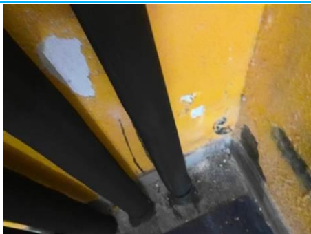
Matériaux : ZPSO-100 Prélèvement : P107 Description : Cloison plâtre Localisation : 1er étage - Escalier 1 Résultat : Absence d'amiante
