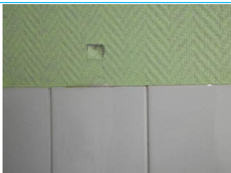
Matériaux : ZPSO-053 Prélèvement : P053 Description : Cloison plâtre Localisation : 1er étage - Sanitaires G Résultat : Absence d'amiante
