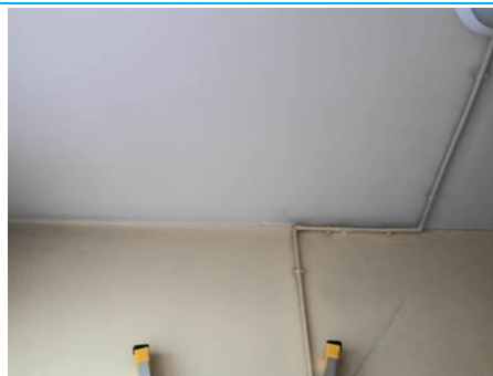
Matériaux : ZPSO-040 Prélèvement : P040 Description : Enduit à base de plâtre lissé ou taloché Localisation : 1er étage - Rgt D-209 Résultat : Absence d'amiante
