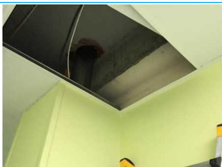
Matériaux : ZPSO-081 Prélèvement : P081 Description : Enduit à base de plâtre lissé ou taloché Localisation : 1er étage - Dgt 4 Résultat : Absence d'amiante
