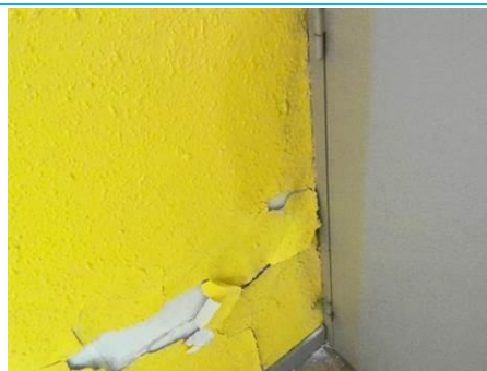
Matériaux : ZPSO-097 Prélèvement : P104 Description : Cloison plâtre Localisation : 1er étage - Escalier 2 Résultat : Absence d'amiante
