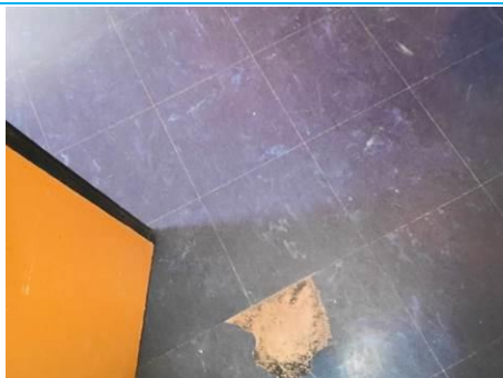
Matériaux : ZPSO-090 Prélèvement : P095 Description : Dalle de sol Localisation : 1er étage - Escalier 1 Résultat : Présence d'amiante
