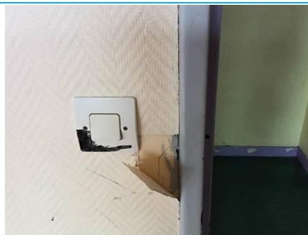
Matériaux : ZPSO-020 Prélèvement : P020 Description : Cloison plâtre Localisation : 1er étage - D-205 Résultat : Absence d'amiante
