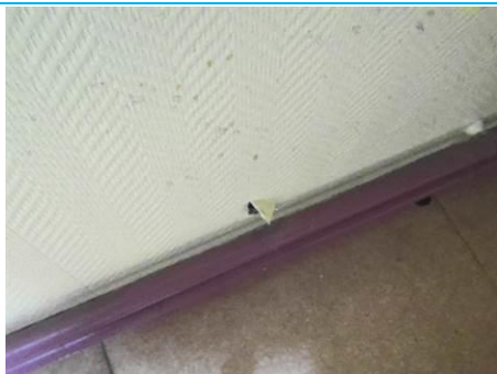
Matériaux : ZPSO-185 Prélèvement : P209 Description : Placo plâtre Localisation : 2ème étage - Ch. 19 Résultat : Absence d'amiante
