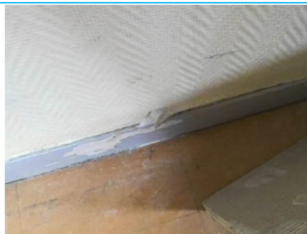
Matériaux : ZPSO-026 Prélèvement : P026 Description : Cloison plâtre Localisation : 1er étage - D-207 Résultat : Absence d'amiante
