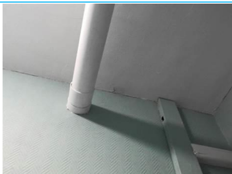
Matériaux : ZPSO-043 Prélèvement : P043 Description : Enduit à base de plâtre lissé ou taloché Localisation : 1er étage - Rgt D-210 Résultat : Absence d'amiante
