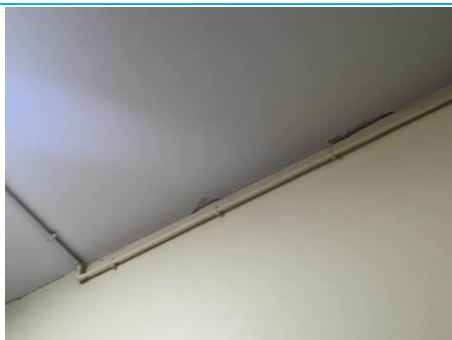
Matériaux : ZPSO-061 Prélèvement : P061 Description : Enduit à base de plâtre lissé ou taloché Localisation : 1er étage - Rgt D-213 Résultat : Absence d'amiante
