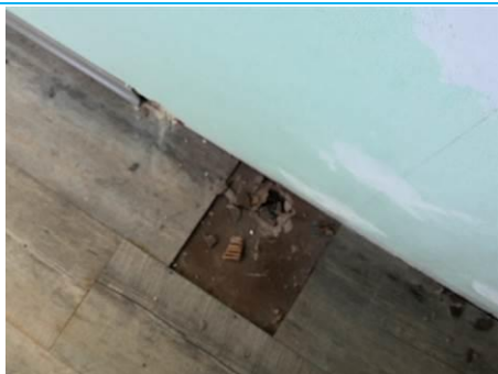
Matériaux : ZPSO-124 Prélèvement : P131 Description : Ragréage Localisation : 2ème étage - Ch. 7 Résultat : Absence d'amiante
