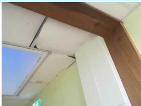
Matériaux : ZPSO-189 Prélèvement : P213 Description : Panneaux et plaques Localisation : 2ème étage - Dgt 1 Résultat : Absence d'amiante
