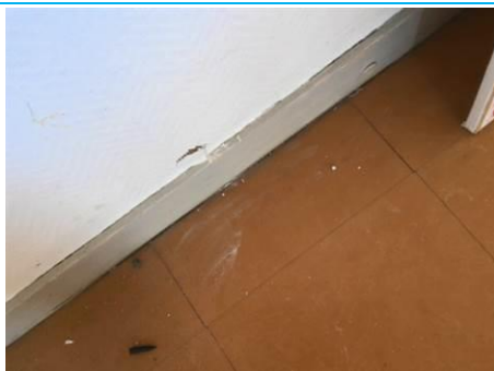
Matériaux : ZPSO-069 Prélèvement : P069 Description : Panneaux de cloisons lisses ou moulurées, préfabriquées ou non Localisation : 1er étage - D-214 Résultat : Absence d'amiante
