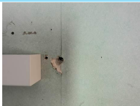
Matériaux : ZPSO-129 Prélèvement : P136 Description : Cloison plâtre Localisation : 2ème étage - Ch. 7 Résultat : Absence d'amiante
