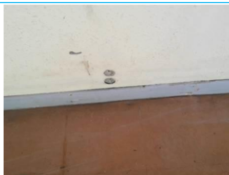
Matériaux : ZPSO-016 Prélèvement : P016 Description : Béton + peinture Localisation : 1er étage - D-204 Résultat : Présence d'amiante
