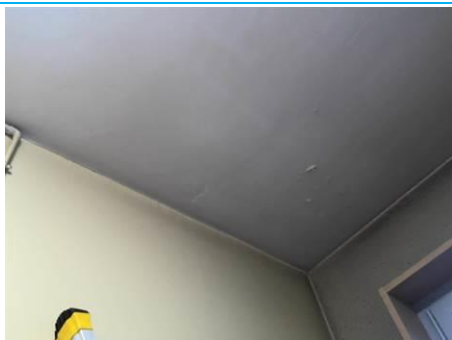
Matériaux : ZPSO-027 Prélèvement : P027 Description : Enduit à base de plâtre lissé ou taloché Localisation : 1er étage - Rgt D-207 Résultat : Absence d'amiante
