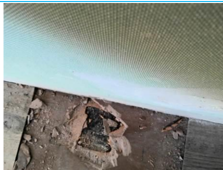
Matériaux : ZPSO-125 Prélèvement : P132 Description : Dalle de sol + colle Localisation : 2ème étage - Ch. 7 Résultat : Présence d'amiante
