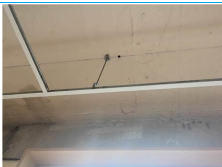
Matériaux : ZPSO-015 Prélèvement : P015 Description : Enduit à base de plâtre lissé ou taloché Localisation : 1er étage - D-204 Résultat : Absence d'amiante
