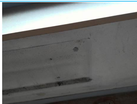
Matériaux : ZPSO-038 Prélèvement : P038 Description : Béton + peinture Localisation : 1er étage - D-209 Résultat : Absence d'amiante
