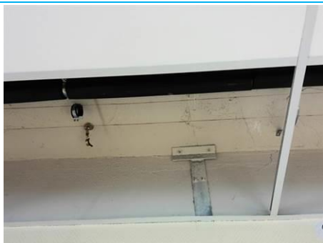
Matériaux : ZPSO-009 Prélèvement : P009 Description : Enduit à base de plâtre lissé ou taloché Localisation : 1er étage - D-202 Résultat : Absence d'amiante
