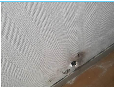
Matériaux : ZPSO-071 Prélèvement : P071 Description : Béton + peinture Localisation : 1er étage - Rgt D-214 Résultat : Absence d'amiante
