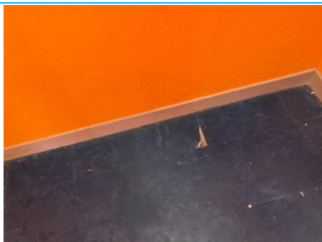
Matériaux : ZPSO-102 Prélèvement : P109 Description : Dalle de sol bleue + colle noire Localisation : 2ème étage - Palier 1 Résultat : Présence d'amiante
