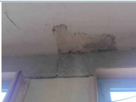
Matériaux : ZPSO-037 Prélèvement : P037 Description : Enduit à base de plâtre lissé ou taloché Localisation : 1er étage - D-209 Résultat : Absence d'amiante
