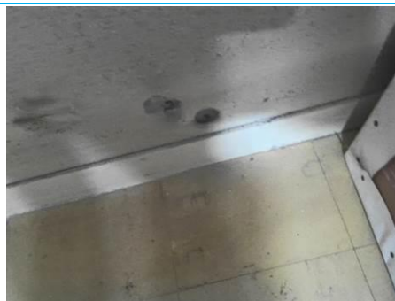
Matériaux : ZPSO-062 Prélèvement : P062 Description : Béton + peinture Localisation : 1er étage - Rgt D-213 Résultat : Absence d'amiante
