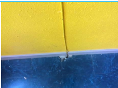
Matériaux : ZPSO-110 Prélèvement : P117 Description : Dalle de sol bleue + colle noire Localisation : 2ème étage - Palier 3 Résultat : Présence d'amiante
