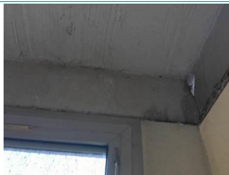
Matériaux : ZPSO-046 Prélèvement : P046 Description : Enduit à base de plâtre lissé ou taloché Localisation : 1er étage - D-210 Résultat : Absence d'amiante
