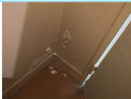
Matériaux : ZPSO-008 Prélèvement : P008 Description : Cloison plâtre Localisation : 1er étage - Rgt D-202 Résultat : Absence d'amiante
