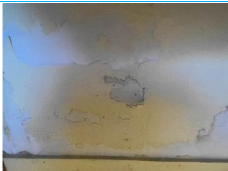
Matériaux : ZPSO-029 Prélèvement : P029 Description : Cloison plâtre Localisation : 1er étage - Rgt D-207 Résultat : Absence d'amiante
