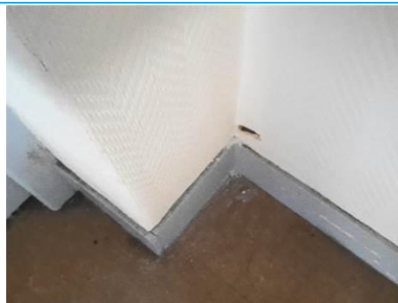
Matériaux : ZPSO-048 Prélèvement : P048 Description : Cloison plâtre Localisation : 1er étage - D-210 Résultat : Absence d'amiante
