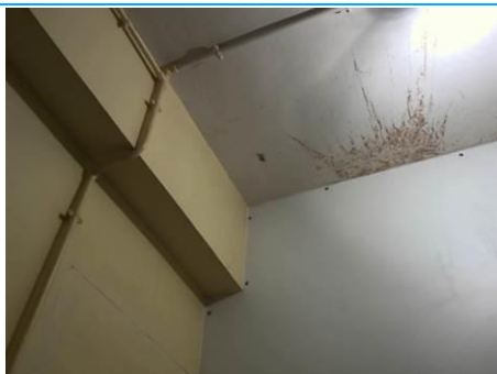
Matériaux : ZPSO-007 Prélèvement : P007 Description : Enduit à base de plâtre lissé ou taloché Localisation : 1er étage - Rgt D-202 Résultat : Présence d'amiante
