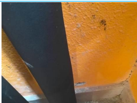
Matériaux : ZPSO-135 Prélèvement : P157 Description : Cloison plâtre Localisation : Rez de chaussée - Cage d'escalier 1 Résultat : Présence d'amiante
