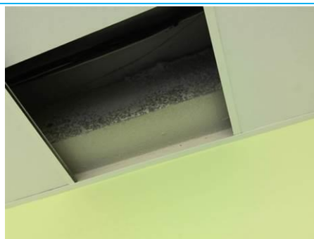
Matériaux : ZPSO-082 Prélèvement : P082 Description : Enduit à base de plâtre lissé ou taloché Localisation : 1er étage - Dgt 1 Résultat : Absence d'amiante
