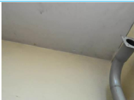
Matériaux : ZPSO-073 Prélèvement : P073 Description : Enduit à base de plâtre lissé ou taloché Localisation : 1er étage - Rgt 4 Résultat : Absence d'amiante
