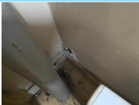
Matériaux : ZPSO-075 Prélèvement : P075 Description : Cloison plâtre Localisation : 1er étage - Rgt 4 Résultat : Absence d'amiante
