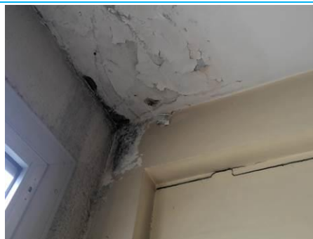
Matériaux : ZPSO-004 Prélèvement : P004 Description : Enduit à base de plâtre lissé ou taloché Localisation : 1er étage - Rgt D-201 Résultat : Présence d'amiante
