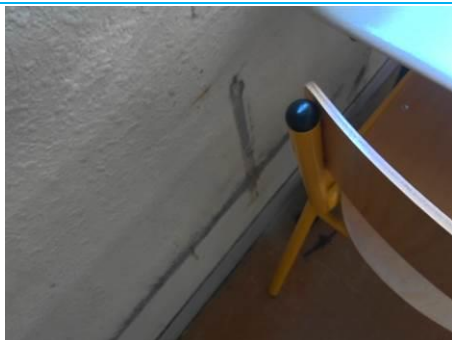
Matériaux : ZPSO-065 Prélèvement : P065 Description : Béton + peinture Localisation : 1er étage - D-213 Résultat : Absence d'amiante
