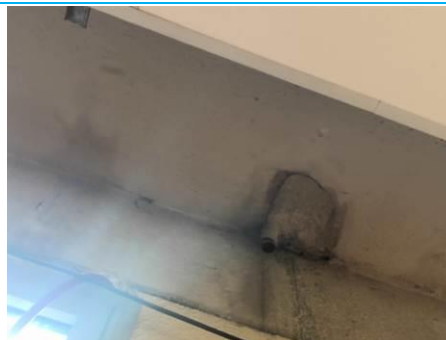
Matériaux : ZPSO-012 Prélèvement : P012 Description : Enduit à base de plâtre lissé ou taloché Localisation : 1er étage - D-203 Résultat : Présence d'amiante
