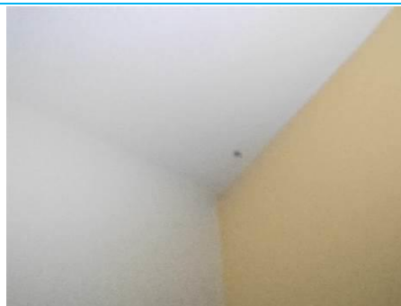
Matériaux : ZPSO-119 Prélèvement : P140 Description : Placo plâtre Localisation : 2ème étage - Bains 3 Résultat : Absence d'amiante
