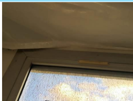
Matériaux : ZPSO-076 Prélèvement : P076 Description : Enduit à base de plâtre lissé ou taloché Localisation : 1er étage - D-215 Résultat : Absence d'amiante
