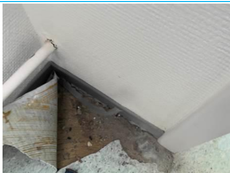
Matériaux : ZPSO-122 Prélèvement : P129 Description : dalle de sol Localisation : 2ème étage - Bains 7 Résultat : Absence d'amiante
