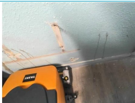
Matériaux : ZPSO-044 Prélèvement : P044 Description : Béton + peinture Localisation : 1er étage - Rgt D-210 Résultat : Absence d'amiante
