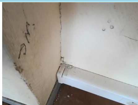
Matériaux : ZPSO-034 Prélèvement : P034 Description : Cloison plâtre Localisation : 1er étage - D-208 Résultat : Absence d'amiante
