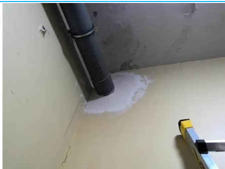
Matériaux : ZPSO-035 Prélèvement : P035 Description : Enduit à base de plâtre lissé ou taloché Localisation : 1er étage - Rgt D-208 Résultat : Absence d'amiante
