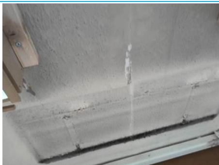
Matériaux : ZPSO-033 Prélèvement : P033 Description : Béton + peinture Localisation : 1er étage - D-208 Résultat : Absence d'amiante
