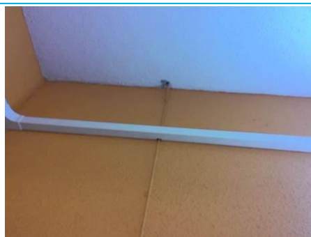
Matériaux : ZPSO-132 Prélèvement : P154 Description : Enduit à base de plâtre lissé ou taloché Localisation : Rez de chaussée - Cage d'escalier 1 Résultat : Présence d'amiante
