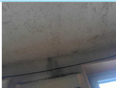
Matériaux : ZPSO-032 Prélèvement : P032 Description : Enduit à base de plâtre lissé ou taloché Localisation : 1er étage - D-208 Résultat : Absence d'amiante
