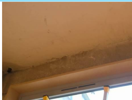
Matériaux : ZPSO-024 Prélèvement : P024 Description : Enduit à base de plâtre lissé ou taloché Localisation : 1er étage - D-207 Résultat : Absence d'amiante
