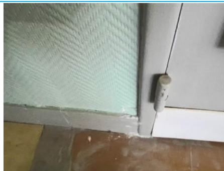
Matériaux : ZPSO-078 Prélèvement : P078 Description : Cloison plâtre Localisation : 1er étage - D-215 Résultat : Absence d'amiante
