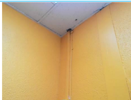
Matériaux : ZPSO-103 Prélèvement : P110 Description : Panneaux et plaques Localisation : 2ème étage - Palier 1 Résultat : Absence d'amiante
