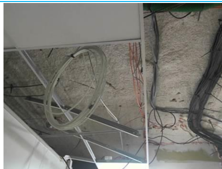
Matériaux : ZPSO-146 Prélèvement : P168 Description : Enduit à base de plâtre lissé ou taloché Localisation : Rez de chaussée - Couloir Résultat : Absence d'amiante
