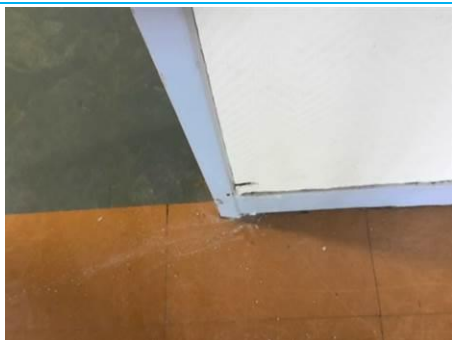
Matériaux : ZPSO-051 Prélèvement : P051 Description : Cloison plâtre Localisation : 1er étage - D-211 Résultat : Absence d'amiante
