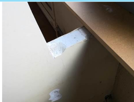
Matériaux : ZPSO-042 Prélèvement : P042 Description : Cloison plâtre Localisation : 1er étage - Rgt D-209 Résultat : Absence d'amiante
