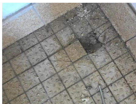
Matériaux : ZPSO-172 Prélèvement : P196 Description : Colle de carrelage Localisation : 2ème étage - Sanitaires Résultat : Absence d'amiante
