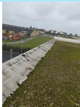
Matériaux : ZPSO-200 Prélèvement : P226 Description : Colle + isolant Localisation : Bâtiment D - Toiture Résultat : Absence d'amiante
