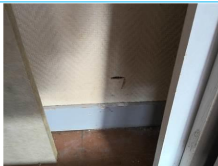
Matériaux : ZPSO-014 Prélèvement : P014 Description : Cloison plâtre Localisation : 1er étage - D-203 Résultat : Absence d'amiante
