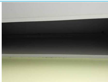
Matériaux : ZPSO-084 Prélèvement : P084 Description : Enduit à base de plâtre lissé ou taloché Localisation : 1er étage - Dgt 3 Résultat : Absence d'amiante
