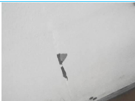
Matériaux : ZPSO-059 Prélèvement : P059 Description : Béton + peinture Localisation : 1er étage - D-212 Résultat : Absence d'amiante
