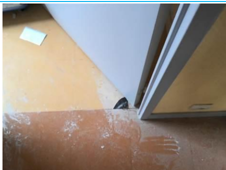
Matériaux : ZPSO-089 Prélèvement : P093 Description : Dalle de sol jaune + colle noire Localisation : 1er étage - Rgt D-201 Résultat : Présence d'amiante
