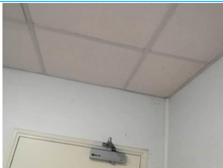
Matériaux : ZPSO-161 Prélèvement : P185 Description : Enduit à base de plâtre lissé ou taloché Localisation : Rez de jardin - Vestiaire F Résultat : Présence d'amiante
