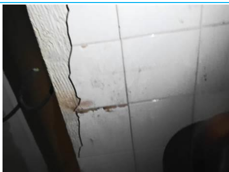
Matériaux : ZPSO-131 Prélèvement : P153 Description : Colle de faïence Localisation : 2ème étage - Local sanitaire Résultat : Présence d'amiante
