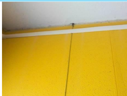
Matériaux : ZPSO-140 Prélèvement : P162 Description : Enduit à base de plâtre lissé ou taloché Localisation : Rez de chaussée - Cage d'escalier 3 Résultat : Absence d'amiante
