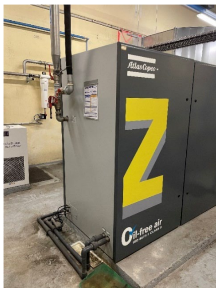
Figure 5 Compresseur d'air refroidi par Eau glacée
