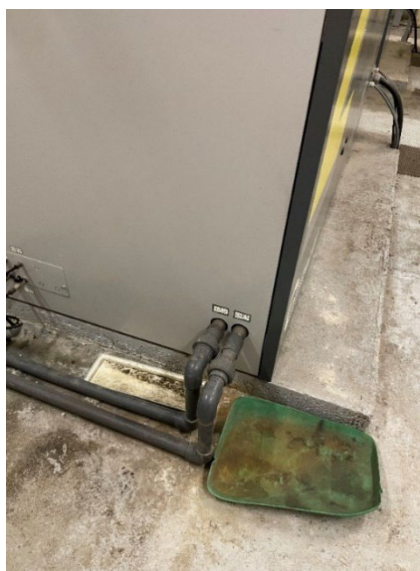
Figure 5 Compresseur d'air refroidi par Eau glacée
