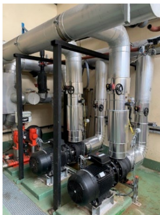
Figure 3 Photo des pompes de distributions d'eau glacée et réseau associé
