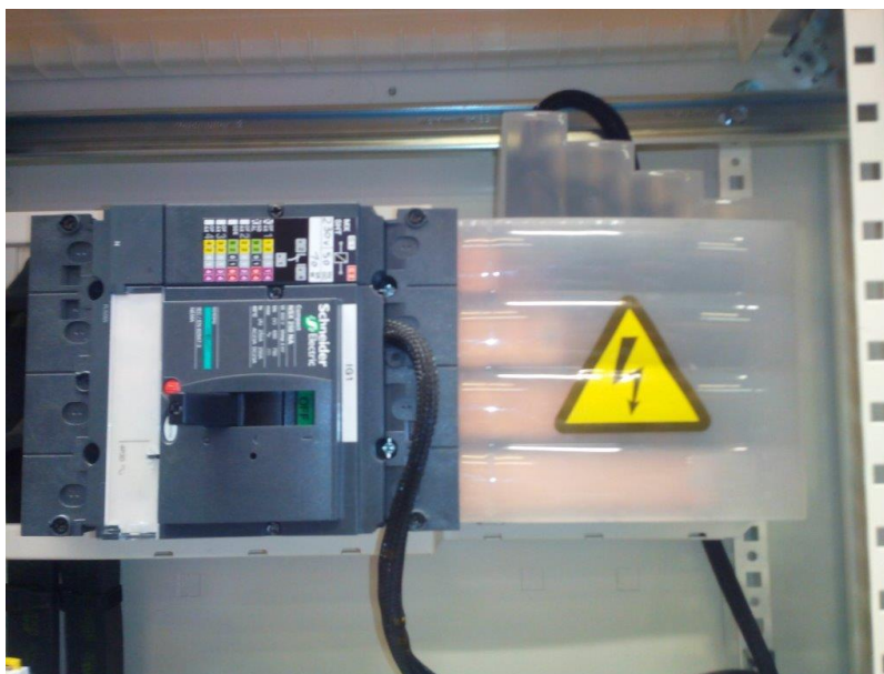
Dispositifs de protection transparente de forme 4 sur queues de barres
