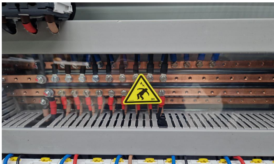
Figure 2 – Dispositifs de raccordement du câblage interne
