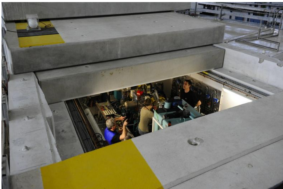
Figure 7 - Ouverture d'une partie du toit du tunnel
