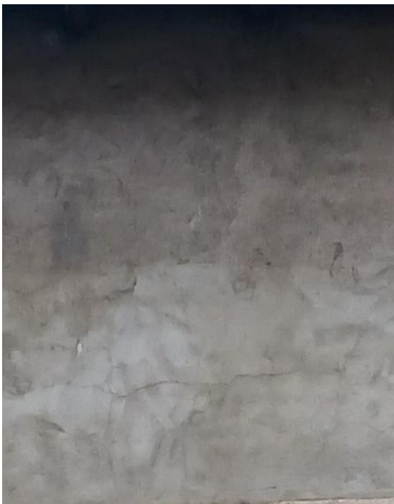
Fissuration de l'enduit sur cour.
