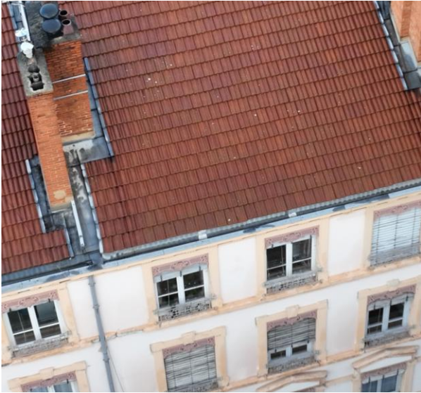
Présence de réparations au droit du caniveau de la rue Bugeaud.
