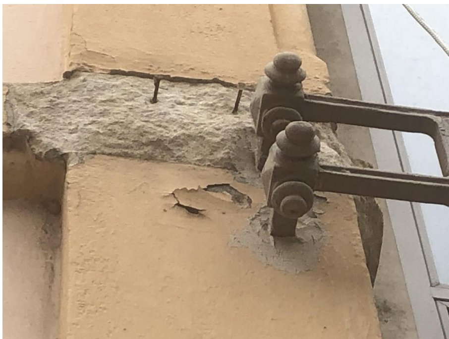
Zoom sur Jambage de baie : ancien ragréage avec gougeons métalliques
