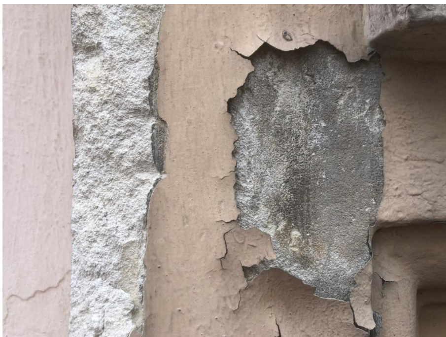
Zoom sur Jambage de baie dans les étages courant : pierre de Saint Restitut + peinture
