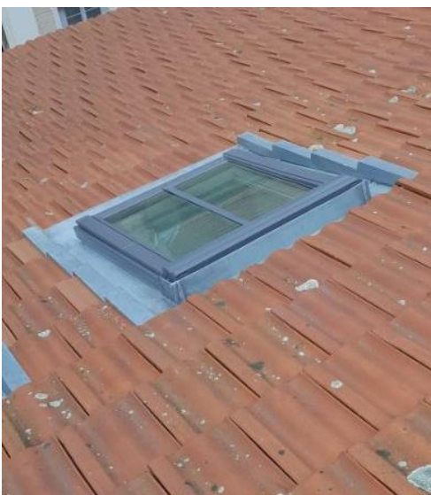
Châssis de toiture récent en bon état
