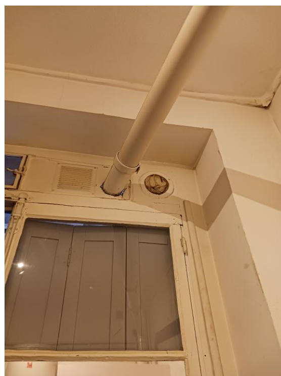
Vue intérieure du conduit condamné.
