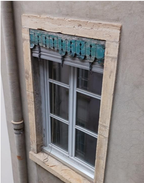
Lambrequin sur cour ancien en bois en mauvais état.
