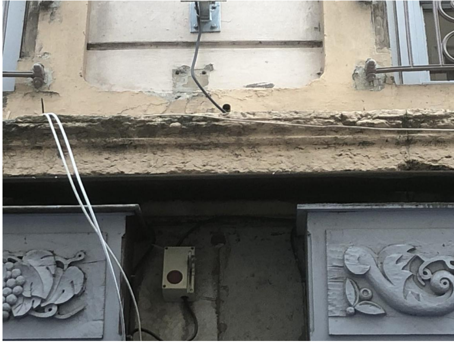
Bandeau du rez-de-chaussée : pierre de Villebois peinte et altérée
