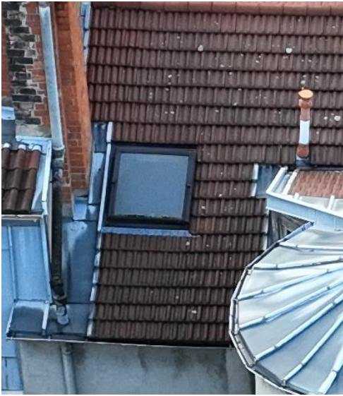
Châssis de toiture récent mais en mauvais état (châssis n°07)
