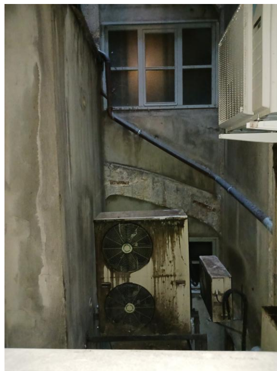
Vue sur les extracteurs de climatisation et une jambette.
