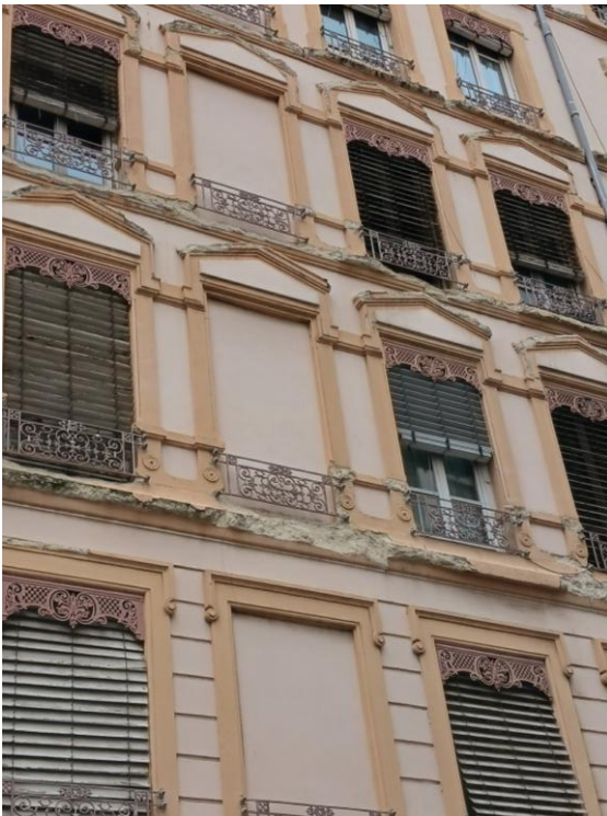
Zoom sur les corniches de la rue Bugeaud fortement altérées
