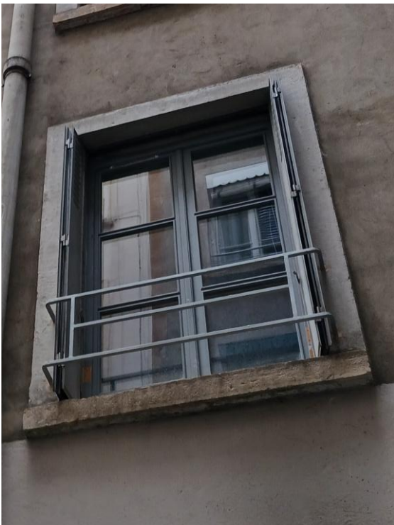
Baie de la façade nord : présence de persiennes métalliques garde-corps déporté .
