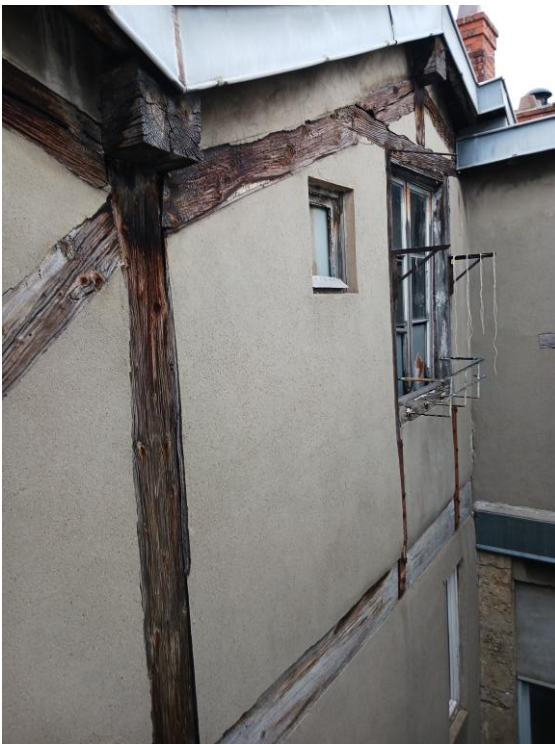
Partie supérieure de la façade ouest (ossature bois)
