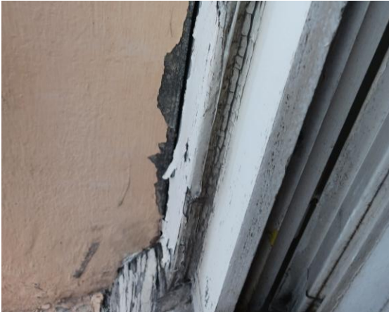
Calfeutrement extérieur des menuiseries lacunaire.
