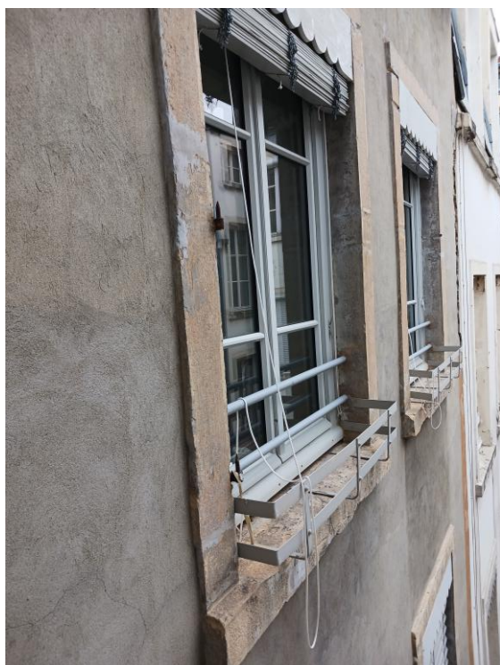
Baie de la façade sud: présence de jardinière en fer plat et de garde-corps de section tubulaire
