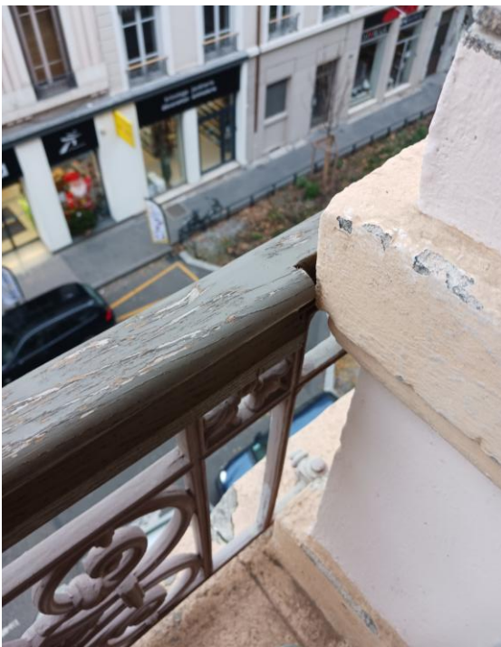
Main courante bois adaptée à la maçonnerie.
