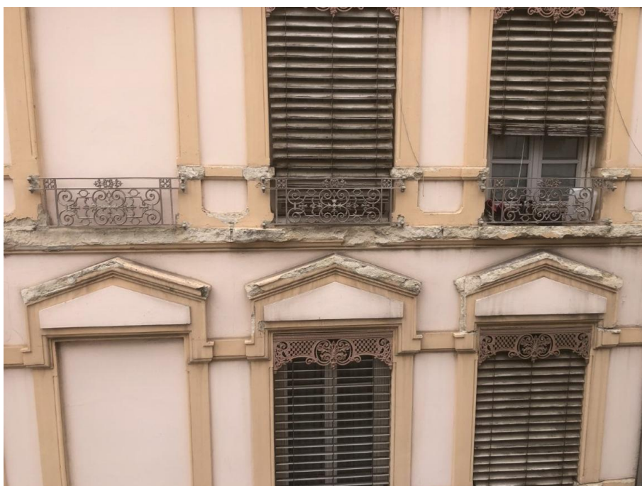
Bandeau, allèges et encadrement de baies dans les étages courants
