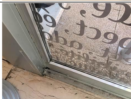
Photo n° PhA013 Localisation : RDC - Espace libre service Ouvrage : Fenetre alu Description : Joint dur pare close
