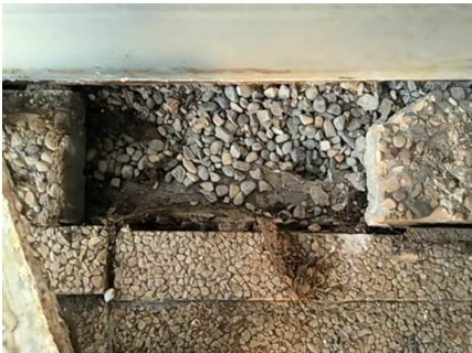
Photo n° PhA036 Localisation : RDC - Espace libre service Ouvrage : Coté extérieur fenetre alu Description : Ragréage beige sous dalle de sol gravier
