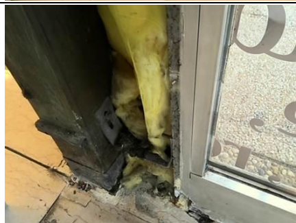
Photo n° PhA024 Localisation : RDC - Espace libre service Ouvrage : Fenetre alu Description : Caisson alu - Laine minérale + craft
