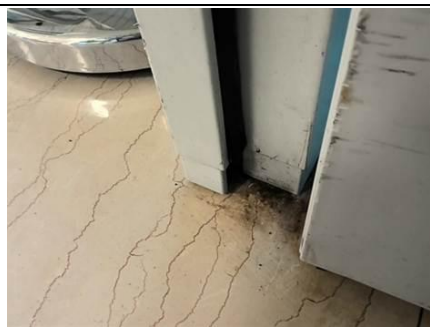
Photo n° PhA030 Localisation : RDC - Bureau accueil 1 Ouvrage : Porte sv alu Description : Joint souple noir dormant
