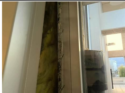
Photo n° PhA028 Localisation : RDC - Espace libre service Ouvrage : Caisson alu Description : Joint souple d'étanchéité blanc
