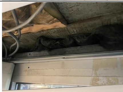
Photo n° PhA034 Localisation : RDC - Espace libre service Ouvrage : Faux plafond lame en alu Description : Laine minérale noir sur dormant
