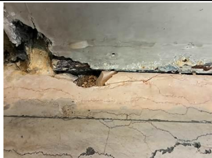
Photo n° PhA026 Localisation : RDC - Espace libre service Ouvrage : Fenetre alu Description : Joint ciment rejingot / Dormant
