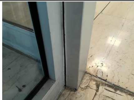
Photo n° PhA033 Localisation : RDC - Espace libre service Ouvrage : Caisson alu Description : Joint souple d'étanchéité blanc
