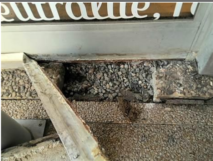
Photo n° PhA037 Localisation : RDC - Espace libre service Ouvrage : Coté extérieur fenetre alu Description : Joint souple sous plinthe alu
