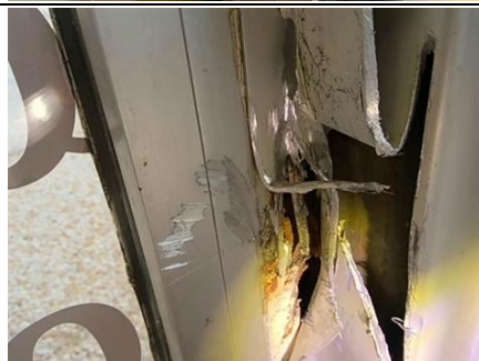
Photo n° PhA029 Localisation : RDC - Espace libre service Ouvrage : Caisson alu droit Description : Cale bois + alu
