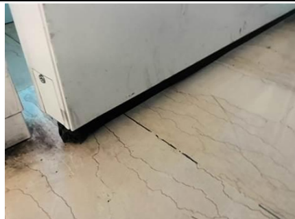
Photo n° PhA031 Localisation : RDC - Bureau accueil 1 Ouvrage : Porte sv alu Description : Joint balet sous porte souple noir
