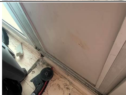
Photo n° PhA014 Localisation : RDC - Bureau accueil 1 Ouvrage : Sol Description : Colle ciment pierre marbre 70x40
