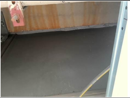
Photo n° PhA045 Localisation : RDC - Espace libre service Ouvrage : Poutre fixation event Description : Béton + mousse grise
