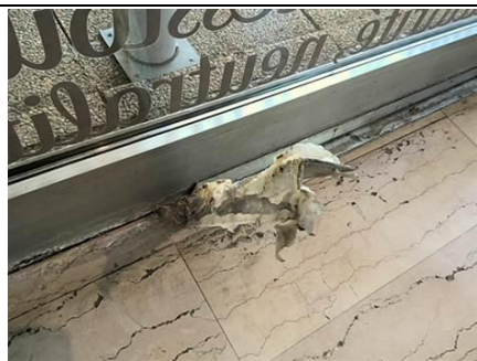
Photo n° PhA025 Localisation : RDC - Espace libre service Ouvrage : Fenetre alu Description : Joint souple transparent sous plinthe alu
