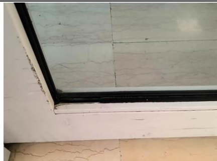
Photo n° PhA023 Localisation : RDC - Bureau accueil 1 Ouvrage : Vitrage porte alu Description : Joint souple sv ouvrant
