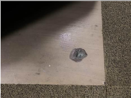
Photo n° PhA038 Localisation : RDC - Réunion 2 Ouvrage : Dalle de sol Description : Dalle de sol moquette marron + ragréage ciment
