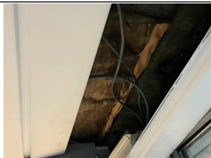
Photo n° PhA022 Localisation : RDC - Espace libre service Ouvrage : Fenetre alu Description : Faux plafond lame en alu
