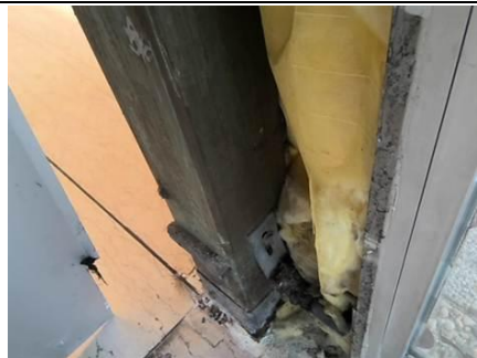
Photo n° PhA027 Localisation : RDC - Espace libre service Ouvrage : Poteau caisson alu Description : Poteau acier peinture vert
