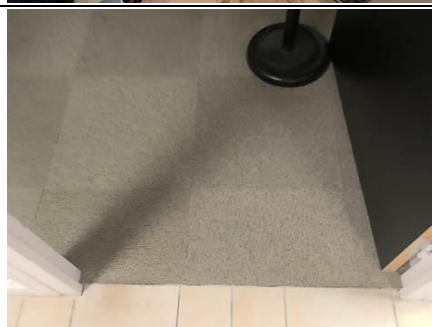
Photo n° PhA015 Localisation : RDC - Réunion 2 Ouvrage : Dalle de sol Description : Dalle de sol moquette marron + ragréage ciment
