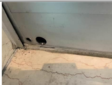
Photo n° PhA032 Localisation : RDC - Espace libre service Ouvrage : Dormant alu Description : Joint souple blanc carrelage / dormant bas
