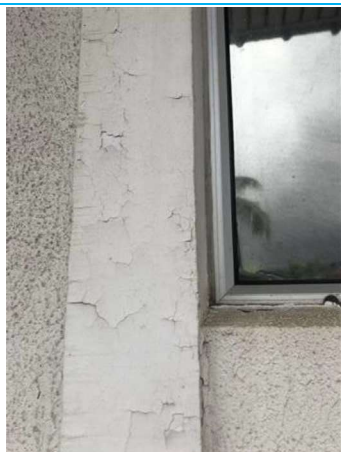
Matériaux : ZPSO-022 Prélèvement : 38 Description : Peinture sur béton Localisation : BAT14/RDC - Parties extérieures Résultat : Absence d'amiante
