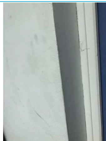
Matériaux : ZPSO-002 Prélèvement : 33 Description : Peinture bleu/Enduit Localisation : BAT17/RDC - 006 Résultat : Présence d'amiante
