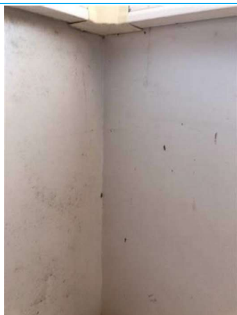
Matériaux : ZPSO-002 Prélèvement : 30 Description : Peinture bleu/Enduit Localisation : BAT17/RDC - 005 Résultat : Absence d'amiante
