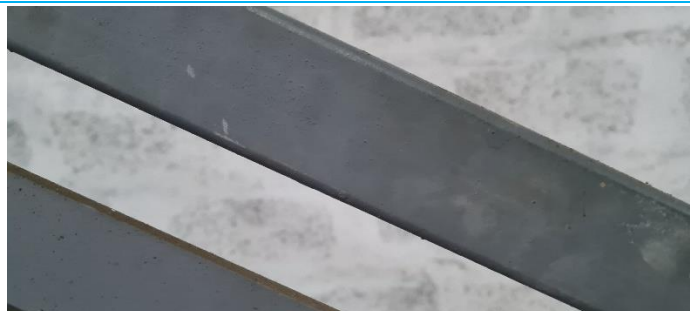
Matériaux : 02P Description : Peinture (grise) Localisation : structures métalliques escaliers Résultat : Concentration massique en plomb acido-soluble <1.5mg/g
