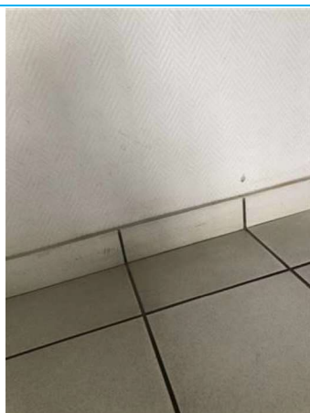
Matériaux : ZPSO-006 Prélèvement : 07 Description : Plinthe beige 30x10/Colle de carrelage Localisation : BAT14/RDC - 012 Résultat : Absence d'amiante
