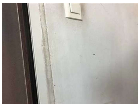
Matériaux : ZPSO-007 Prélèvement : 25 Description : Peinture blanche/Enduit Localisation : BAT17/RDC - 004 Résultat : Absence d'amiante
