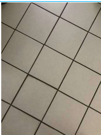
Matériaux : ZPSO-010 Prélèvement : 11 Description : Carrelage beige 30x30/Colle de carrelage Localisation : BAT14/RDC - 009 Résultat : Absence d'amiante
