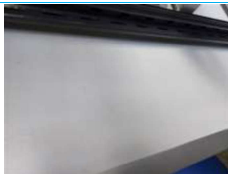
Matériaux : ZPSO-055 Prélèvement : P108 Description : Panneaux de cloisons lisses en plâtre Localisation : Rdc - 003 Résultat : Absence d'amiante
