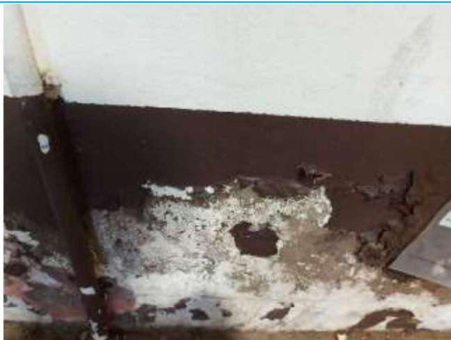
Matériaux : 10P Description : Peinture (marron) Localisation : R+1 – Hangar Résultat : Concentration massique en plomb acido-soluble <1.5mg/g
