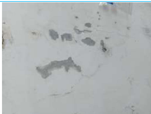
Matériaux : 17P Description : Peinture (blanc) Localisation : Rdc – Partie extérieure Résultat : Concentration massique en plomb acido-soluble <1.5mg/g
