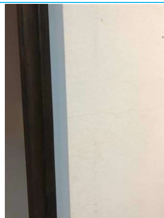
Matériaux : ZPSO-007 Prélèvement : 24 Description : Peinture blanche/Enduit Localisation : BAT17/RDC - 004 Résultat : Absence d'amiante
