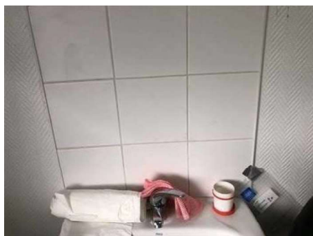
Matériaux : ZPSO-012 Prélèvement : 20 Description : Faïence blanc 20x20/Colle de faïence Localisation : BAT14/RDC - 006 Résultat : Absence d'amiante
