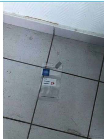
Matériaux : ZPSO-017 Prélèvement : 27 Description : Carrelage 30x30 gris tacheté/Colle de carrelage Localisation : BAT14/RDC - 018 Résultat : Absence d'amiante
