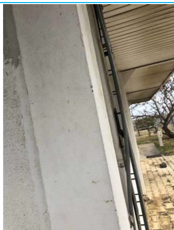
Matériaux : ZPSO-023 Prélèvement : 40 Description : Peinture blanche/Enduit lisse Localisation : BAT14/RDC - Parties extérieures Résultat : Absence d'amiante
