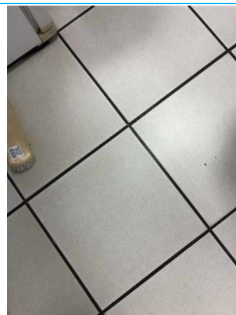
Matériaux : ZPSO-010 Prélèvement : 13 Description : Carrelage beige 30x30/Colle de carrelage Localisation : BAT14/RDC - 001 Résultat : Absence d'amiante
