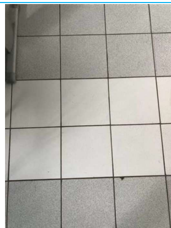
Matériaux : ZPSO-019 Prélèvement : 29 Description : Carrelage blanc 30x30/Colle de carrelage Localisation : BAT14/RDC - 016 Résultat : Absence d'amiante
