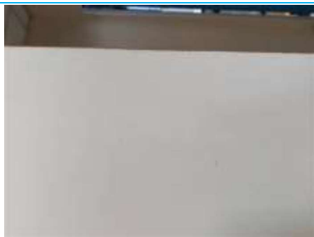
Matériaux : ZPSO-026 Prélèvement : P037 Description : Enduit à base de plâtre lissé + peinture (beige) Localisation : R+1 - 011 Résultat : Absence d'amiante
