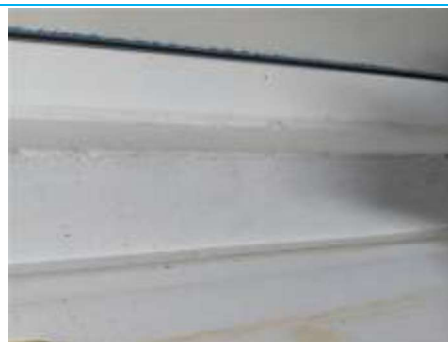
Matériaux : ZPSO-032 Prélèvement : P048 Description : Enduit à base de plâtre lissé + peinture (blanc) Localisation : R+1 - 013 Résultat : Absence d'amiante
