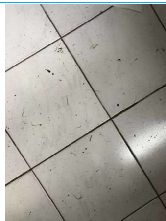
Matériaux : ZPSO-011 Prélèvement : 17 Description : Carrelage blanc 30x30/Colle Localisation : BAT17/RDC - 003 Résultat : Absence d'amiante
