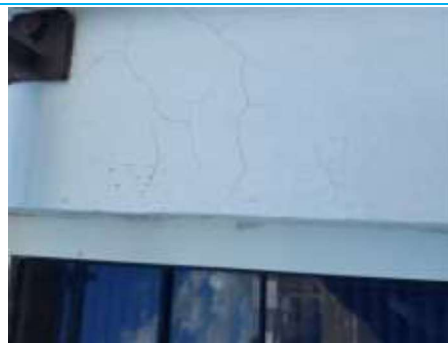
Matériaux : ZPSO-081 Prélèvement : P092 Description : Enduit extérieur + peinture (blanc) Localisation : Façade 005 Résultat : Présence d'amiante
