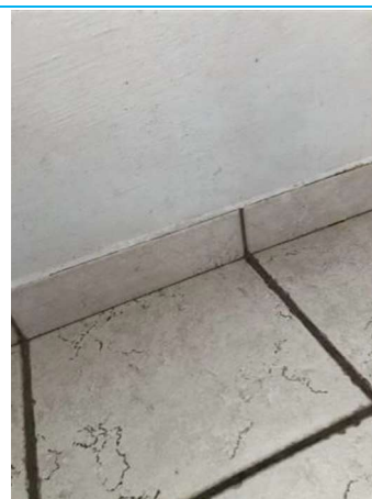
Matériaux : ZPSO-003 Prélèvement : 04 Description : Plinthe 35x5 beige/Colle Localisation : BAT17/RDC - 001 Résultat : Absence d'amiante
