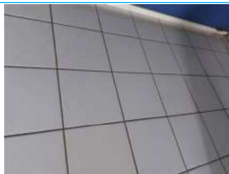
Matériaux : ZPSO-049 Prélèvement : P102 Description : Colle de carrelage 20x20 (blanc) Localisation : Rdc - 006 Résultat : Absence d'amiante
