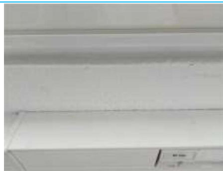
Matériaux : ZPSO-028 Prélèvement : P044 Description : Revêtement mural + sous couche Localisation : R+1 - 012 Résultat : Présence d'amiante
