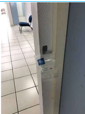
Matériaux : ZPSO-011 Prélèvement : 12 Description : Papier blanc motif/Enduit Localisation : BAT14/RDC - 022 Résultat : Absence d'amiante
