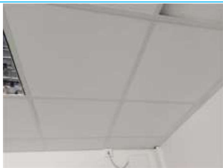
Matériaux : ZPSO-004 Prélèvement : P007 Description : Plaques démontables 60x60 (blanc) Localisation : R+1 - 003 Résultat : Absence d'amiante
