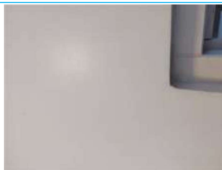
Matériaux : ZPSO-015 Prélèvement : P022 Description : Enduit à base de plâtre lissé + peinture (blanc) Localisation : R+1 - 005 Résultat : Absence d'amiante
