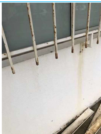
Matériaux : ZPSO-021 Prélèvement : 36 Description : Peinture blanche/Enduit Localisation : BAT14/RDC - Parties extérieures Résultat : Absence d'amiante
