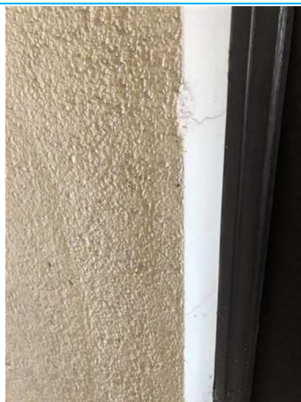
Matériaux : ZPSO-021 Prélèvement : 44 Description : Peinture bleu/beige/Enduit Localisation : BAT17/RDC - Parties extérieures Résultat : Absence d'amiante
