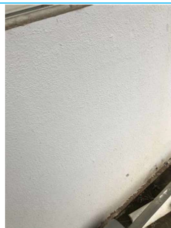
Matériaux : ZPSO-021 Prélèvement : 37 Description : Peinture blanche/Enduit Localisation : BAT14/RDC - Parties extérieures Résultat : Absence d'amiante
