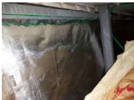
Matériaux : ZPSO-073 Prélèvement : P133 Description : Isolant sous tôles Localisation : Rdc - 017 Résultat : Absence d'amiante
