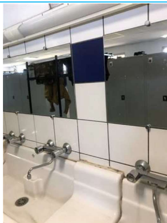
Matériaux : ZPSO-009 Prélèvement : 13 Description : Faïence 20x20 liseré bleu/Colle Localisation : BAT17/RDC - 002 Résultat : Absence d'amiante
