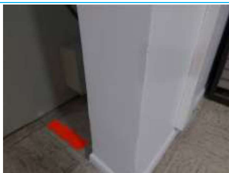
Matériaux : ZPSO-065 Prélèvement : P123 Description : Enduit à base de plâtre lissé + peinture (blanc) Localisation : Rdc - 017 Résultat : Absence d'amiante
