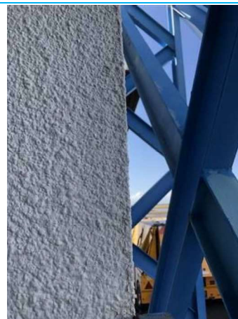
Matériaux : ZPSO-021 Prélèvement : 45 Description : Peinture bleu/beige/Enduit Localisation : BAT17/RDC - Parties extérieures Résultat : Présence d'amiante
