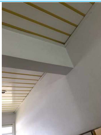
Matériaux : ZPSO-004 Prélèvement : 04 Description : Peinture blanche/Enduit Localisation : BAT14/RDC - 013 Résultat : Absence d'amiante
