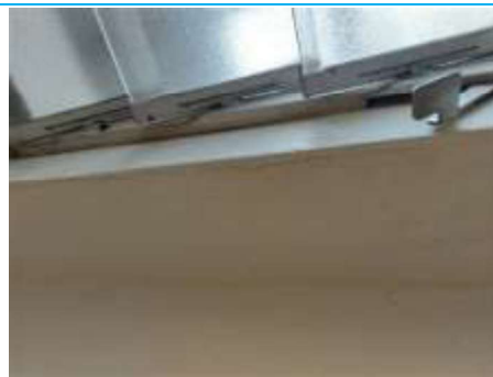
Matériaux : ZPSO-014 Prélèvement : P020 Description : Enduit à base de plâtre lissé + peinture (blanc) Localisation : R+1 - 005 Résultat : Présence d'amiante
