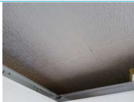
Matériaux : ZPSO-005 Prélèvement : P008 Description : Panneaux bois + enduit taloché Localisation : R+1 - 003 Résultat : Absence d'amiante
