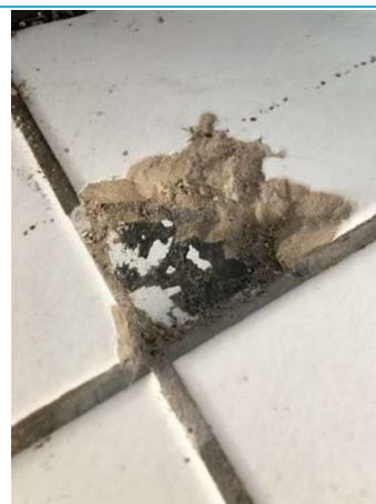
Matériaux : ZPSO-022 Prélèvement : 49 Description : Colle bitumineuse Localisation : BAT17/RDC - 003 Résultat : Absence d'amiante
