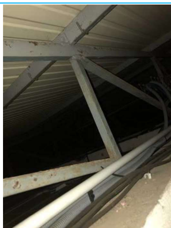
Matériaux : ZPSO-014 Prélèvement : 23 Description : Peinture grise Localisation : BAT14/RDC - 012 Résultat : Absence d'amiante
