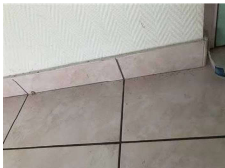
Matériaux : ZPSO-016 Prélèvement : 26 Description : Plinthe beige 60x10/Colle de carrelage Localisation : BAT14/RDC - 017 Résultat : Absence d'amiante
