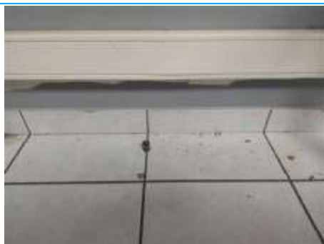
Matériaux : ZPSO-067 Prélèvement : P125 Description : Colle de plinthe 30x8 (blanc) Localisation : Rdc - 011 Résultat : Absence d'amiante
