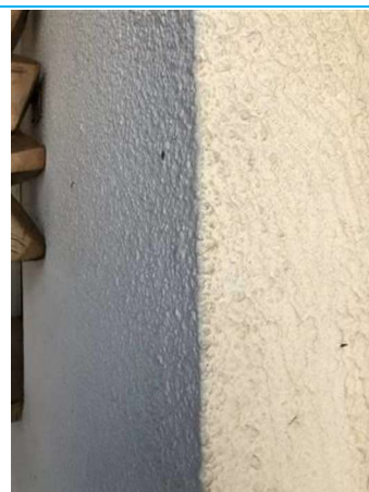
Matériaux : ZPSO-021 Prélèvement : 43 Description : Peinture bleu/beige/Enduit Localisation : BAT17/RDC - Parties extérieures Résultat : Absence d'amiante
