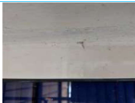
Matériaux : ZPSO-086 Prélèvement : P144 Description : Joint d'étanchéité entre menuiserie et structure Localisation : Façade 010 Résultat : Absence d'amiante
