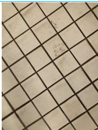
Matériaux : ZPSO-010 Prélèvement : 15 Description : Carrelage 10x10 beige/Colle Localisation : BAT17/RDC - 002 Résultat : Absence d'amiante
