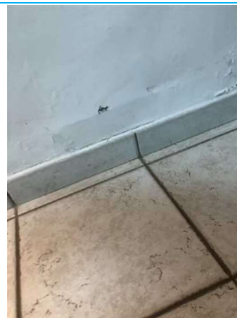
Matériaux : ZPSO-003 Prélèvement : 23 Description : Plinthe 35x5 beige/Colle Localisation : BAT17/RDC - 004 Résultat : Absence d'amiante
