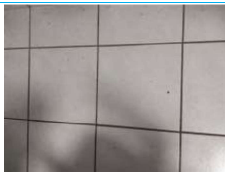
Matériaux : ZPSO-066 Prélèvement : P124 Description : Colle de carrelage 30x30 (blanc) Localisation : Rdc - 011 Résultat : Absence d'amiante
