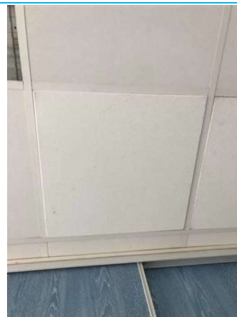
Matériaux : ZPSO-008 Prélèvement : 09 Description : Plaques 60x60 blanc tacheté Localisation : BAT14/RDC - 012 Résultat : Absence d'amiante
