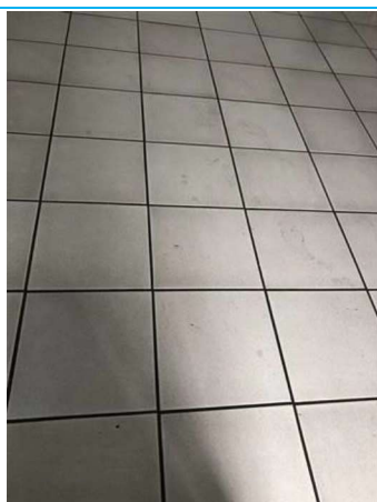
Matériaux : ZPSO-005 Prélèvement : 06 Description : Carrelage beige 30x30/Colle de carrelage Localisation : BAT14/RDC - 012 Résultat : Absence d'amiante
