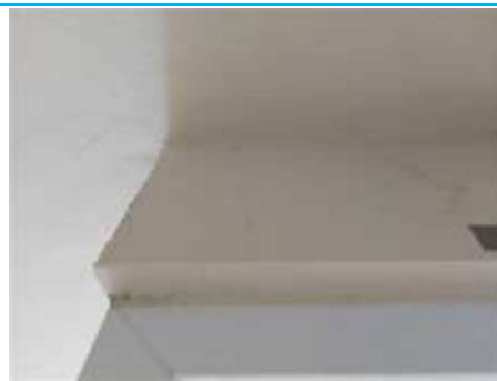
Matériaux : ZPSO-026 Prélèvement : P038 Description : Enduit à base de plâtre lissé + peinture (beige) Localisation : R+1 - 011 Résultat : Absence d'amiante
