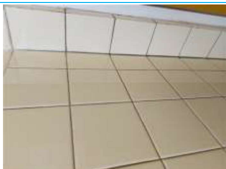
Matériaux : ZPSO-022 Prélèvement : P033 Description : Colle de faïence 15X15 (jaune) Localisation : R+1 - 011 Résultat : Absence d'amiante
