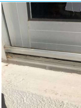
Matériaux : ZPSO-005 Prélèvement : 42 Description : Joint de menuiserie gris Localisation : BAT17/RDC - Parties extérieures Résultat : Absence d'amiante
