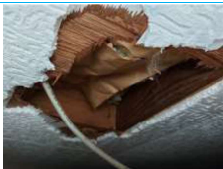
Matériaux : ZPSO-006 Prélèvement : P009 Description : Isolant posé dans le plénum au-dessus du panneau de faux plafond Localisation : R+1 - 003 Résultat : Absence d'amiante
