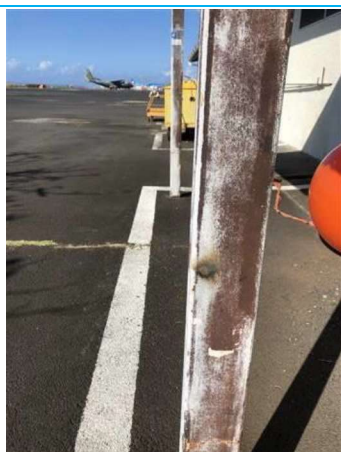
Matériaux : ZPSO-020 Prélèvement : 41 Description : Peinture rouge sur structure métallique Localisation : BAT17/RDC - 010 Résultat : Absence d'amiante
