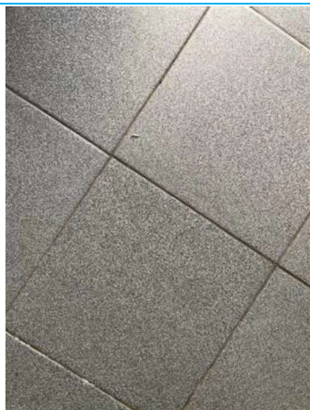
Matériaux : ZPSO-017 Prélèvement : 37 Description : Carrelage gris foncé 30x30/Colle Localisation : BAT17/RDC - 008 Résultat : Absence d'amiante
