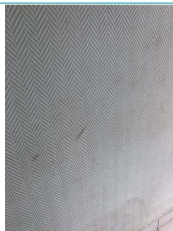
Matériaux : ZPSO-020 Prélèvement : 31 Description : Revêtement mural/Enduit Localisation : BAT14/RDC - 019 Résultat : Absence d'amiante
