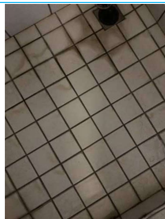
Matériaux : ZPSO-010 Prélèvement : 16 Description : Carrelage 10x10 beige/Colle Localisation : BAT17/RDC - 002 Résultat : Absence d'amiante
