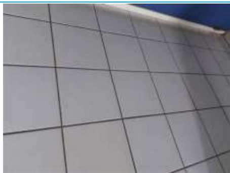
Matériaux : ZPSO-050 Prélèvement : P103 Description : Colle de faïence 20x20 (blanc) Localisation : Rdc - 006 Résultat : Absence d'amiante
