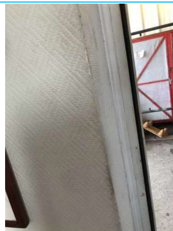
Matériaux : ZPSO-018 Prélèvement : 38 Description : Revêtement mural bleu/Enduit Localisation : BAT17/RDC - 008 Résultat : Absence d'amiante
