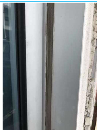
Matériaux : ZPSO-024 Prélèvement : 43 Description : Joint d'étanchéité entre menuiserie et structure Localisation : BAT14/RDC - Parties extérieures Résultat : Absence d'amiante
