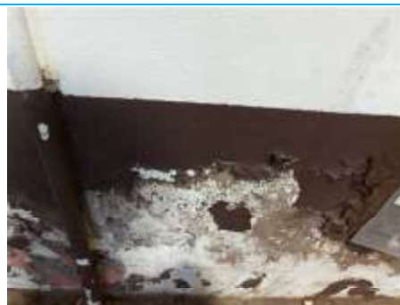
Matériaux : ZPSO-076 Prélèvement : P084 Description : Peinture (marron) Localisation : Rdc - Hangar Résultat : Absence d'amiante
