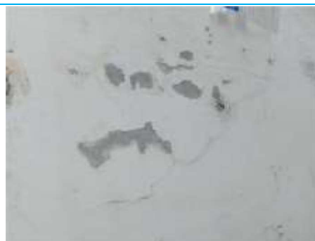
Matériaux : ZPSO-083 Prélèvement : P136 Description : Peinture (blanc) Localisation : Façade 010 Résultat : Absence d'amiante
