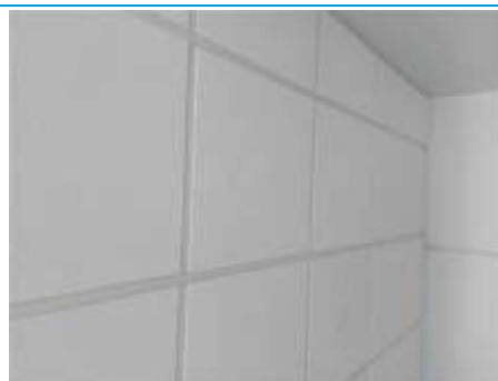
Matériaux : ZPSO-053 Prélèvement : P106 Description : Plaques démontables 60x60 (blanc) Localisation : Rdc - 002 Résultat : Absence d'amiante
