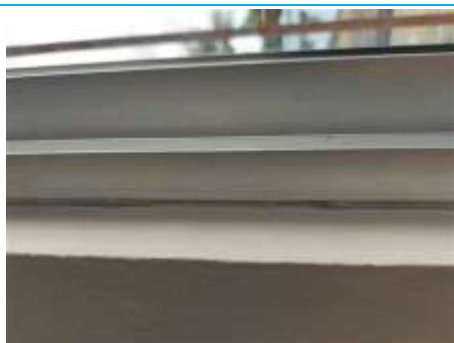
Matériaux : ZPSO-036 Prélèvement : P057 Description : Joint d'étanchéité entre menuiserie et structure Localisation : R+1 - 014 Résultat : Absence d'amiante
