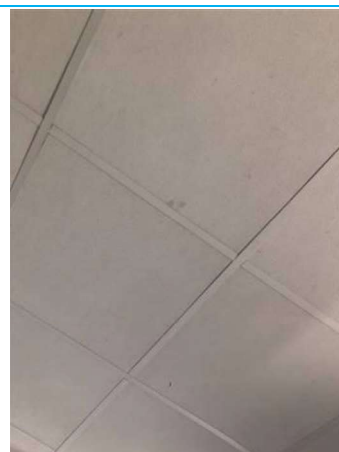
Matériaux : ZPSO-008 Prélèvement : 12 Description : Plaque faux plafond 60x60 blanc Localisation : BAT17/RDC - 002 Résultat : Absence d'amiante
