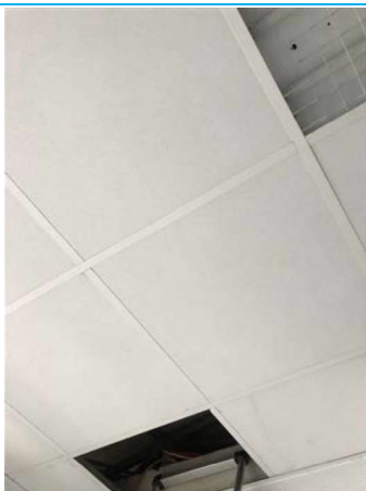
Matériaux : ZPSO-007 Prélèvement : 08 Description : Plaques 60x60 blanc Localisation : BAT14/RDC - 012 Résultat : Absence d'amiante
