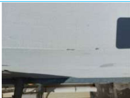
Matériaux : ZPSO-081 Prélèvement : P143 Description : Enduit extérieur + peinture (blanc) Localisation : Façade 017 Résultat : Absence d'amiante
