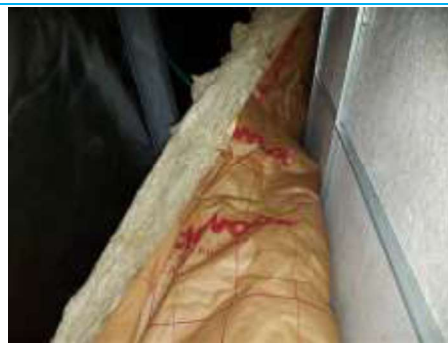
Matériaux : ZPSO-074 Prélèvement : P134 Description : Isolant posé dans le plénum au-dessus du panneau de faux plafond Localisation : Rdc - 017 Résultat : Absence d'amiante
