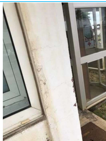
Matériaux : ZPSO-023 Prélèvement : 41 Description : Peinture blanche/Enduit lisse Localisation : BAT14/RDC - Parties extérieures Résultat : Absence d'amiante
