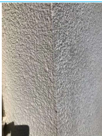
Matériaux : ZPSO-021 Prélèvement : 48 Description : Peinture bleu/beige/Enduit Localisation : BAT17/RDC - Parties extérieures Résultat : Absence d'amiante
