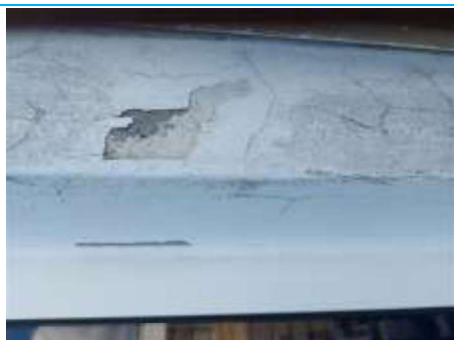
Matériaux : ZPSO-081 Prélèvement : P089 Description : Enduit extérieur + peinture (blanc) Localisation : Façade 002 Résultat : Présence d'amiante
