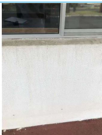
Matériaux : ZPSO-021 Prélèvement : 34 Description : Peinture blanche/Enduit Localisation : BAT14/RDC - Parties extérieures Résultat : Absence d'amiante
