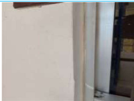
Matériaux : ZPSO-081 Prélèvement : P139 Description : Enduit extérieur + peinture (blanc) Localisation : Façade 016 Résultat : Présence d'amiante
