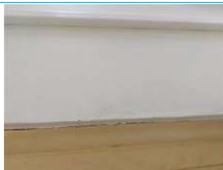
Matériaux : ZPSO-035 Prélèvement : P054 Description : Enduit à base de plâtre lissé + peinture (blanc) Localisation : R+1 - 018 Résultat : Absence d'amiante
