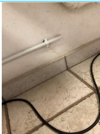
Matériaux : ZPSO-003 Prélèvement : 09 Description : Plinthe 35x5 beige/Colle Localisation : BAT17/RDC - 002 Résultat : Absence d'amiante
