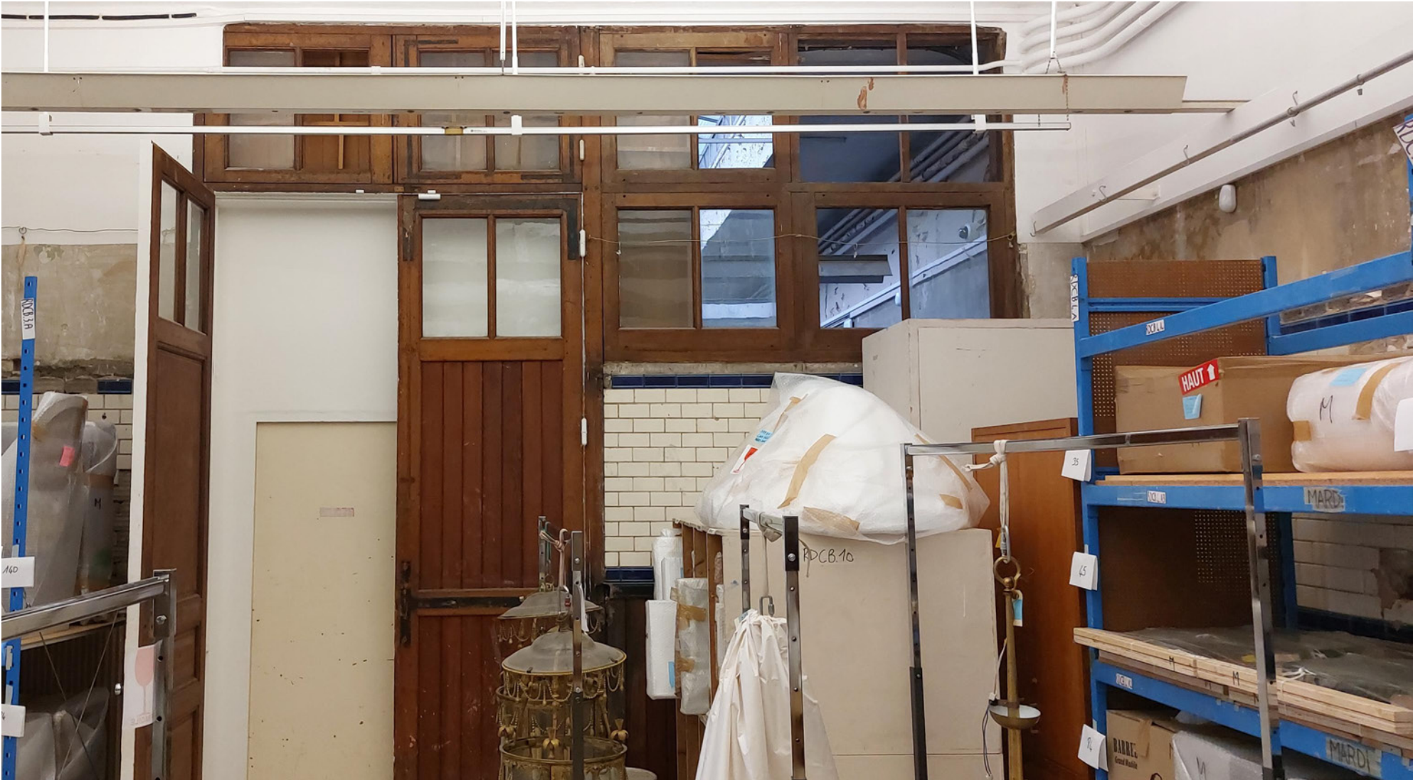
Vue depuis ADC - C.RDCB.01 - reprise verrière bois historique au lot 2 (verres et cadres manquants)
