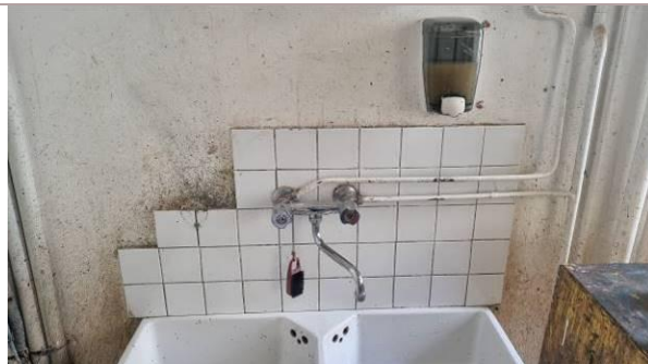
Photo n° 50 / prélèvement n° 50 Colle de faïence Rdc bas, local atelier
