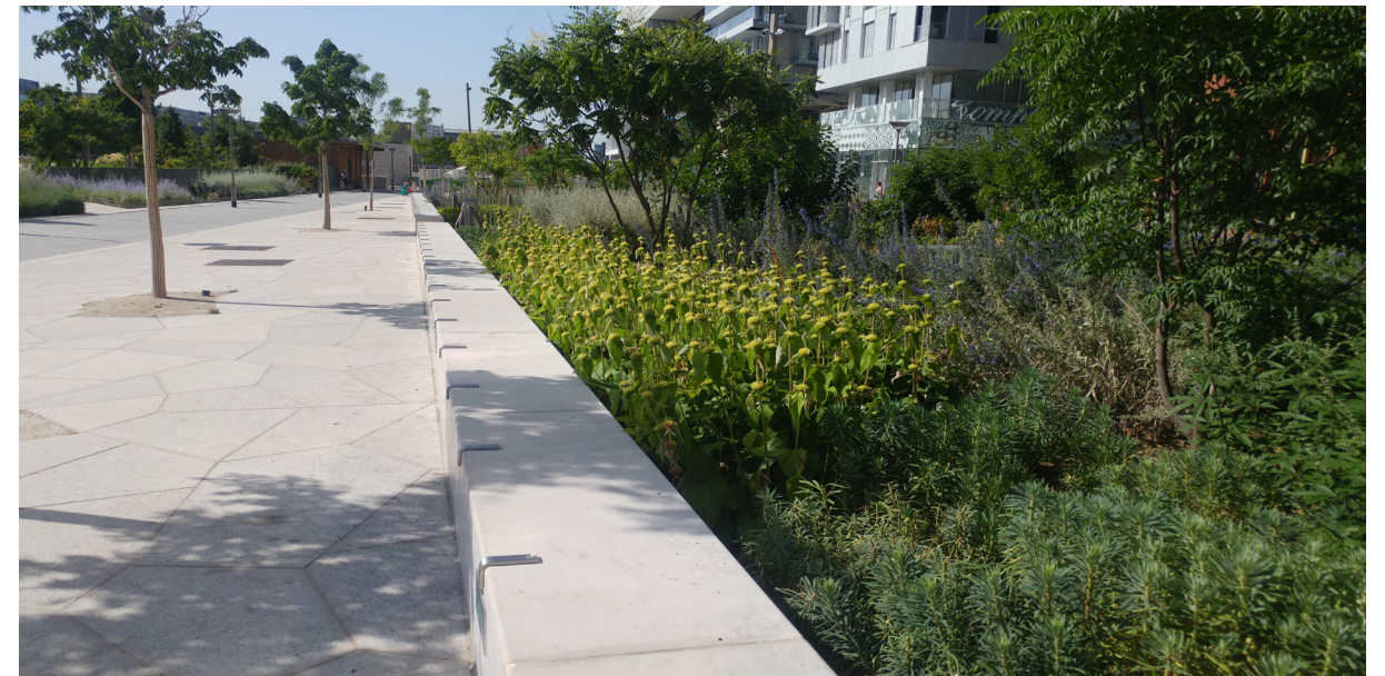
Muret bahu béton, hauteur d'assise 45cm
