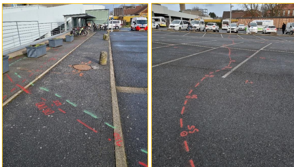
Figure 20. Extrait de photographies des réseaux électriques rencontrés – CAPTUREA, 28/01/2025.
