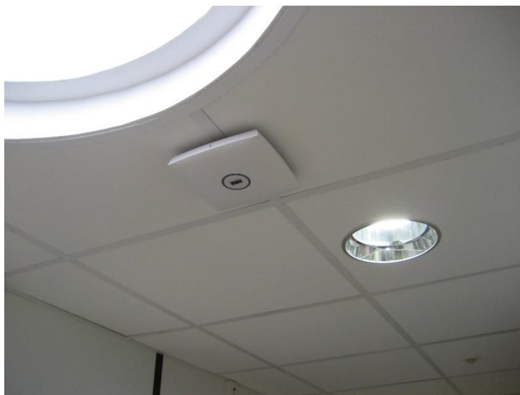
Fixation sur rail de faux-plafond
