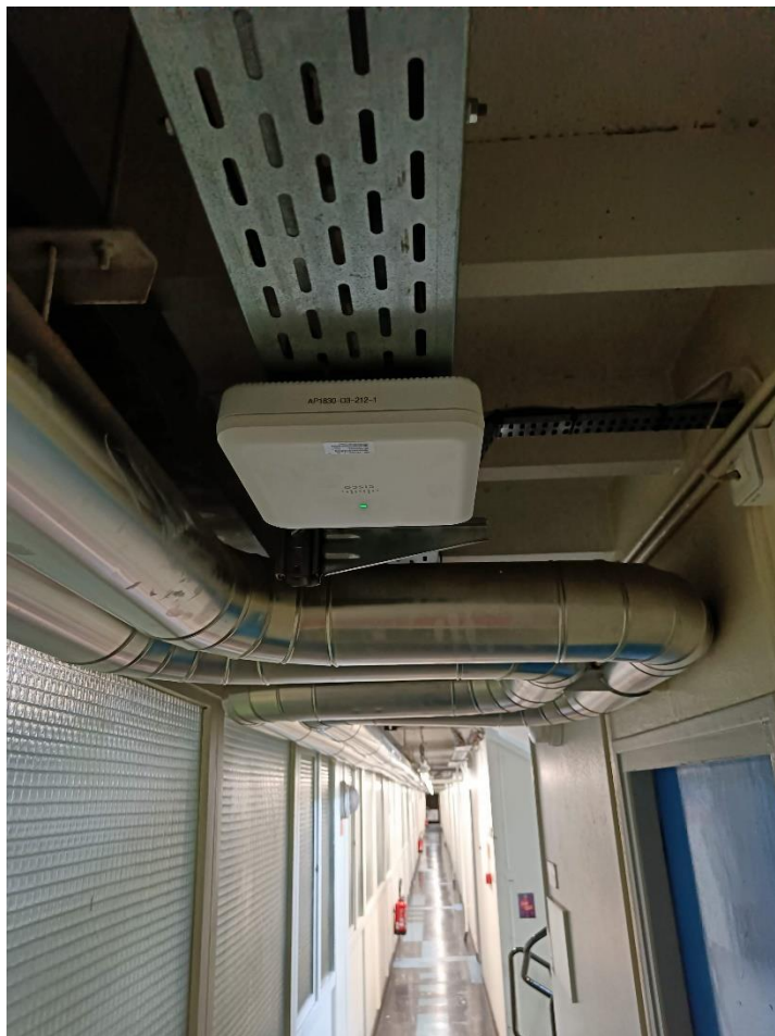
Fixation sur chemin de câbles
