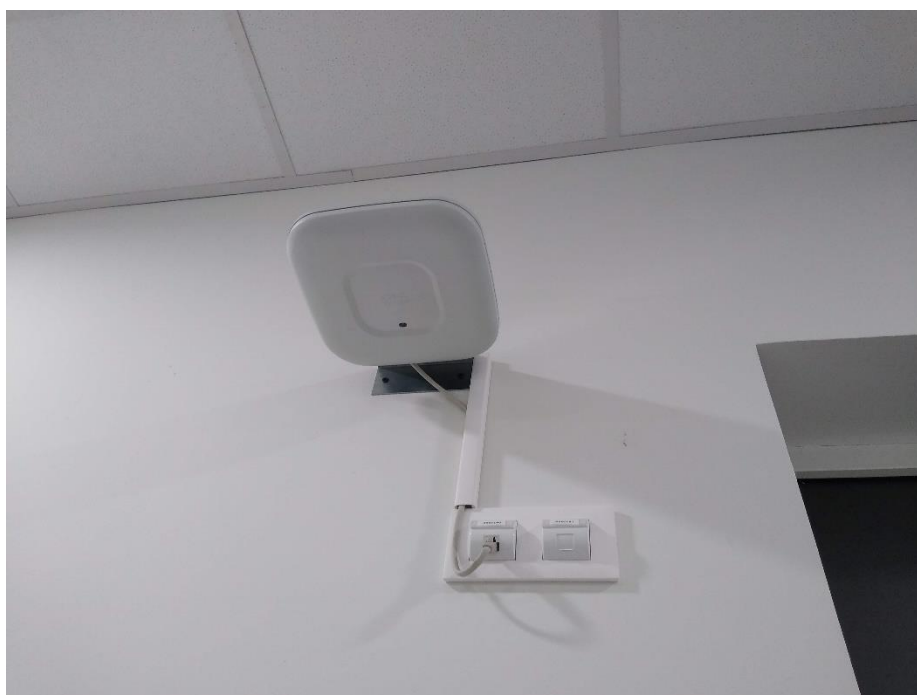
Fixation horizontale sur équerre
