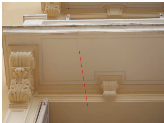
Fissures transversales en sous-face d'un balcon
