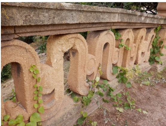
Érosion des barreaudages
