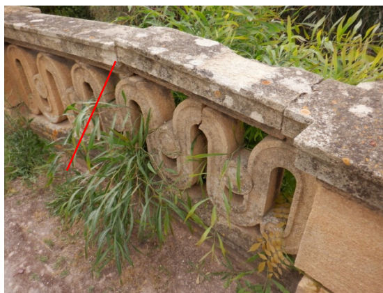
Décalage altimétrique des pierres de couronnement
