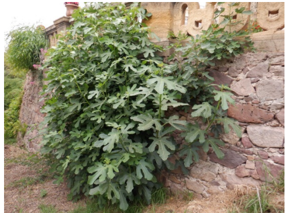
Présence de végétation dense sur le mur de soutènement
