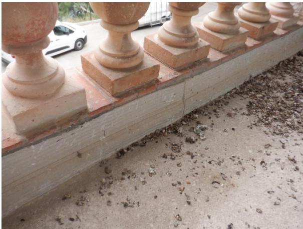
Vue rapprochée relevés d'étanchéité
