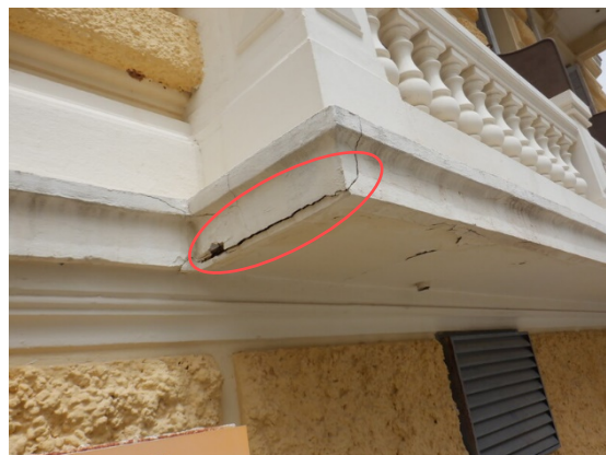
Éclat d'angle du balcon du 1 er étage
