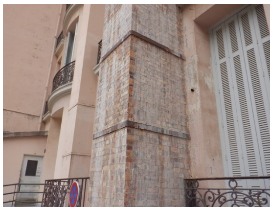
Détail sur les cerclages oxydés de la gaine technique
