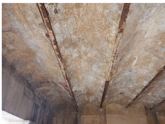
Oxydation des poutrelles tour Nord/Est
