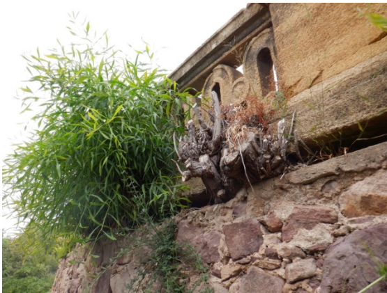
Présence d'une souche dans le mur de soutènement et du dispositif de retenue
