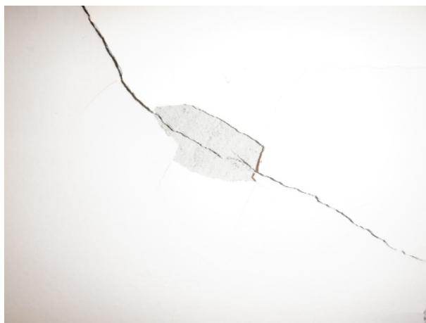
Vue rapprochée fine fissure
