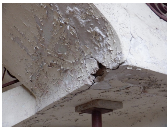
Vue rapprochée gonflement plâtre
