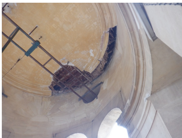
Vue rapprochée effondrement partiel
