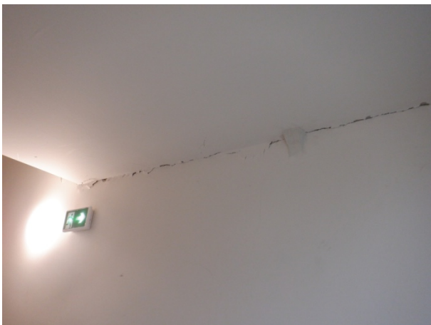
Vue générale fissure sous-face palier
