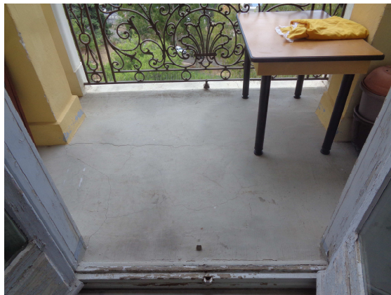
Vue générale fissuration sur balcon
