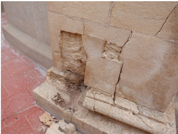
Vue rapprochée écrouitage sur voile
