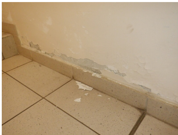
Vue rapprochée remontées capillaires
