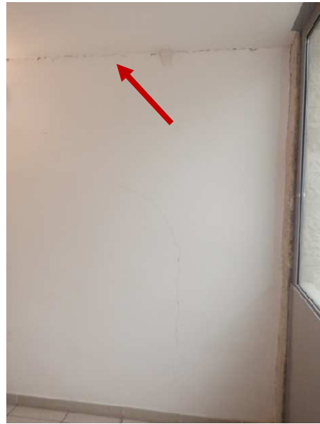
Vue générale fissure sous face palier
