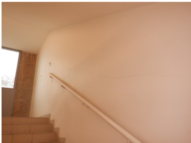
Vue générale fissure horizontale
