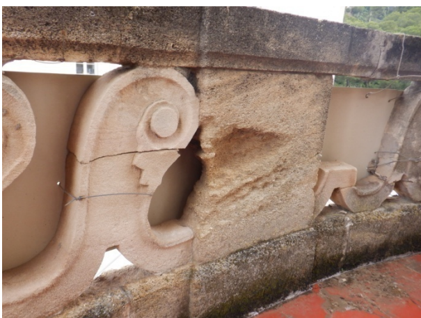
Vue rapprochée érosion sur barreaudage
