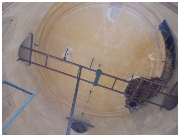
Vue générale sous-face plafond canisses
