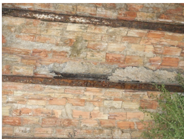
Vue rapprochée voutain avec effondrement localisé
