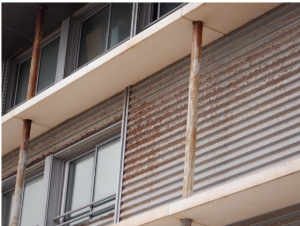
Vue rapprochée DEP corrodées
