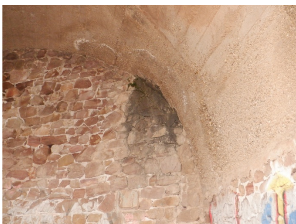
Vue rapprochée coulures noires
