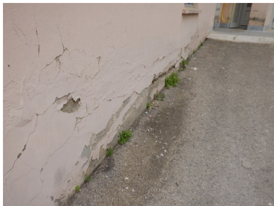
Décollement de l'enduit, écaillage de la peinture et fissure sur le mur en brique de l'annexe
