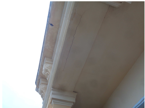
Vue générale fissuration sous balcon
