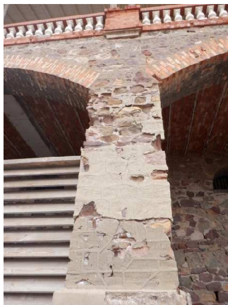
Vue rapprochée écroutage sur arche
