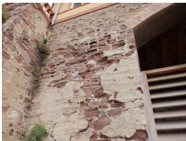
Vue rapprochée écroutage sur arche
