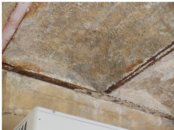
Oxydation des poutrelles tour Sud/Est
