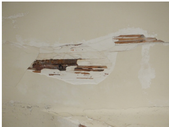
Vue rapprochée poutrelles oxydées
