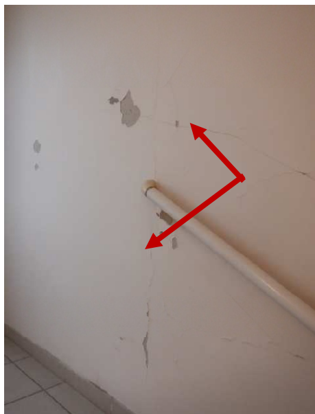
Vue générale fissure verticale et horizontale
