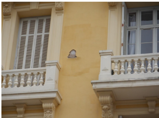
Décollement de l'enduit sur la façade NORD
