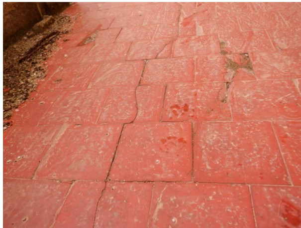
Vue rapprochée fissure sur terre cuite
