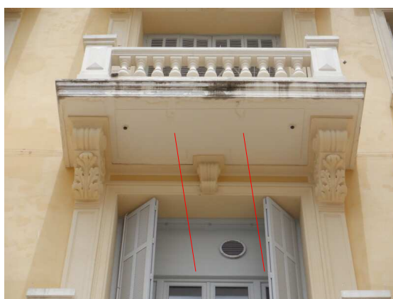
Fissures transversales en sous-face d'un balcon et traces de coulure sèche sur la retombée
