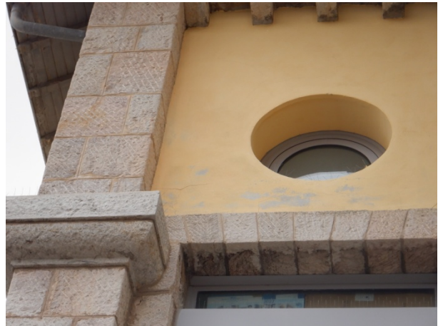
Vue rapprochée fissure sur remplissage
