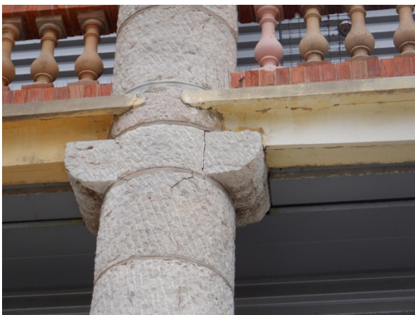
Vue rapprochée corbeau fissuré
