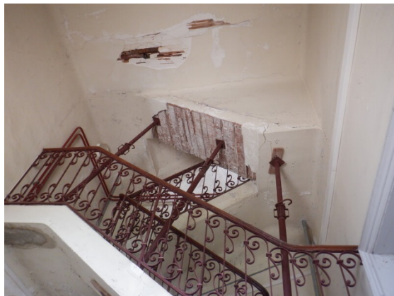
Vue générale poutrelles oxydées
