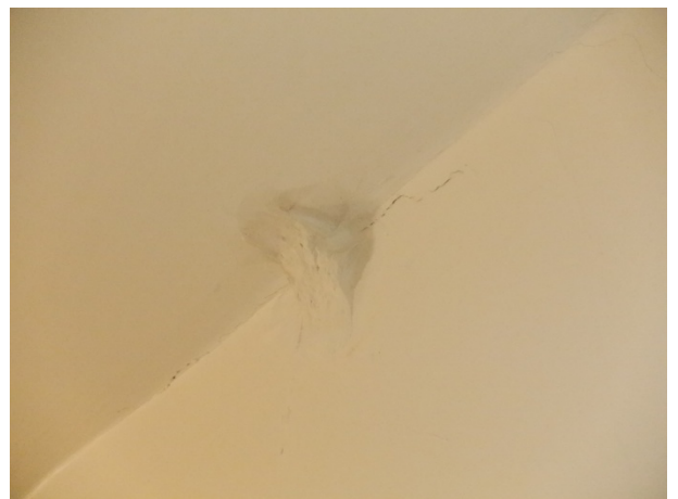
Vue générale témoin de plâtre sous palier
