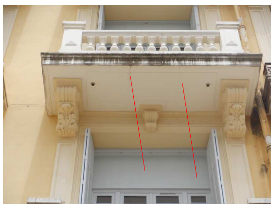
Fissures transversales en sous-face d'un balcon et traces de coulure sèche sur la retombée
