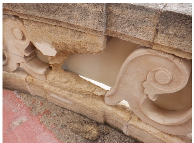
Vue rapprochée érosion sur barreaudage
