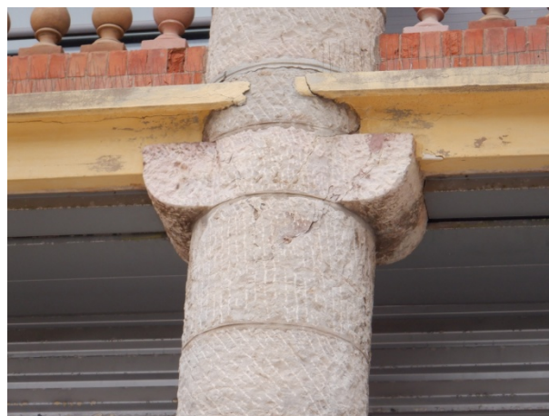
Vue rapprochée corbeau fissuré
