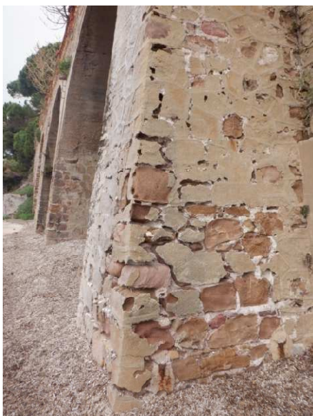
Vue rapprochée écroutage sur arche
