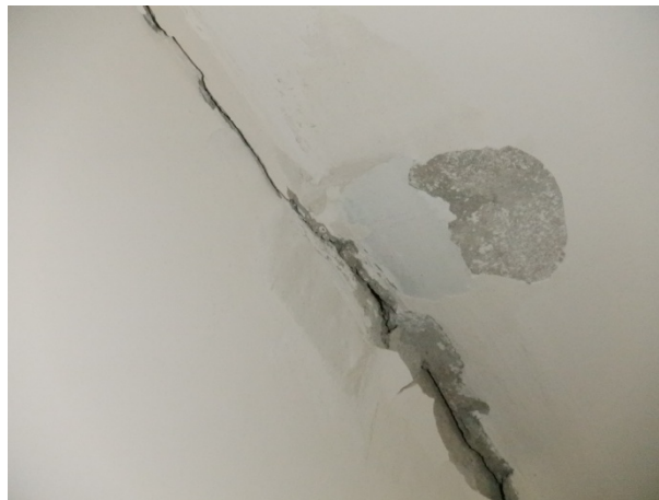
Vue rapprochée fissure sous-face paillasse
