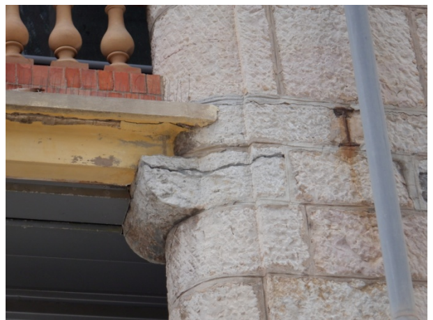
Vue rapprochée corbeau fissuré
