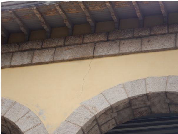
Vue rapprochée fissure au droit d'une arche
