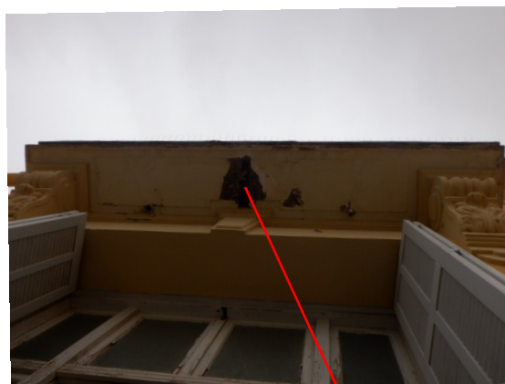
Éclat de béton du balcon
