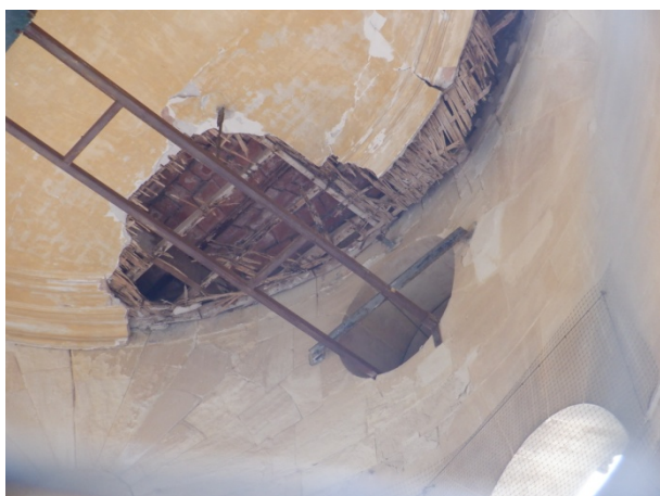
Vue rapprochée effondrement partiel
