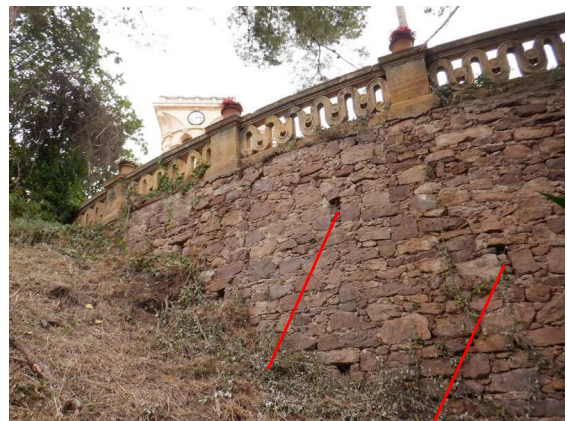
Vue générale du mur de soutènement avec barbacanes
