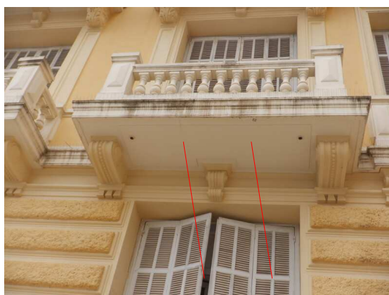
Fissures transversales en sous-face d'un balcon et traces de coulure sèche sur le retombée
