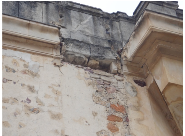
Vue rapprochée écrouitage sur voile
