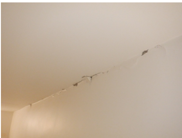
Vue générale fissure sous-face palier
