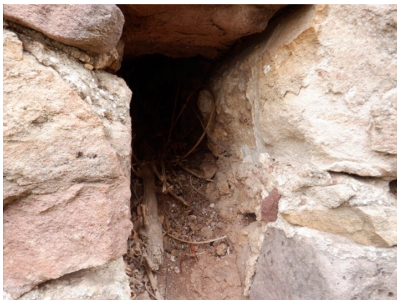
Exemple de barbacane du mur de soutènement
