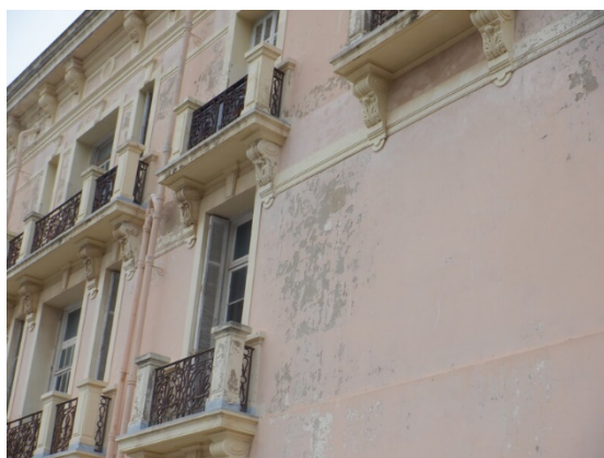
Écaillage de la peinture sur la façade OUEST (côté Château)
