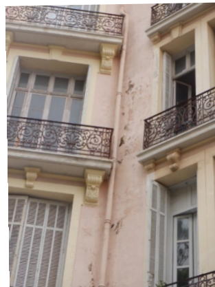
Écaillage de la peinture sur la façade EST
