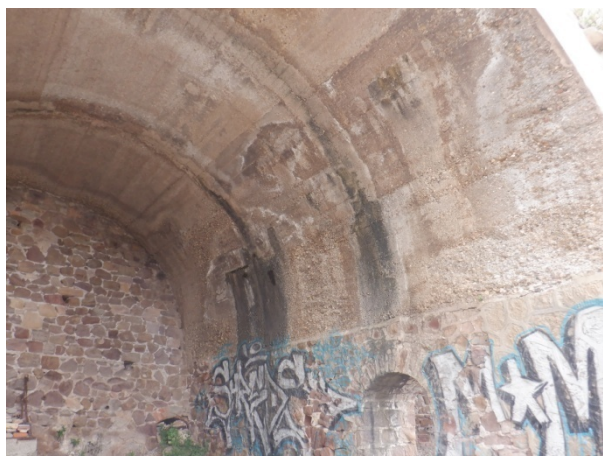
Vue rapprochée trace d'infiltration
