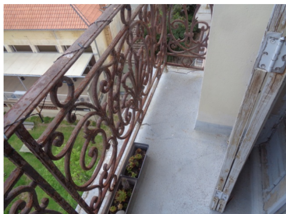
Vue générale éclat béton sur balcon
