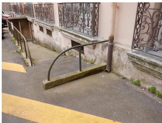
Gouttière en façade NORD se déversant en pied de façade
