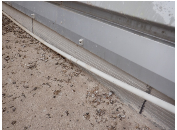
Vue rapprochée relevés d'étanchéité
