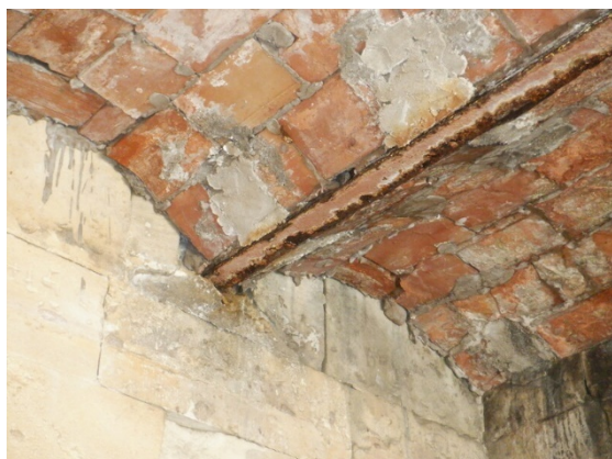
Poutrelle impactée par le goutte-à-goutte
