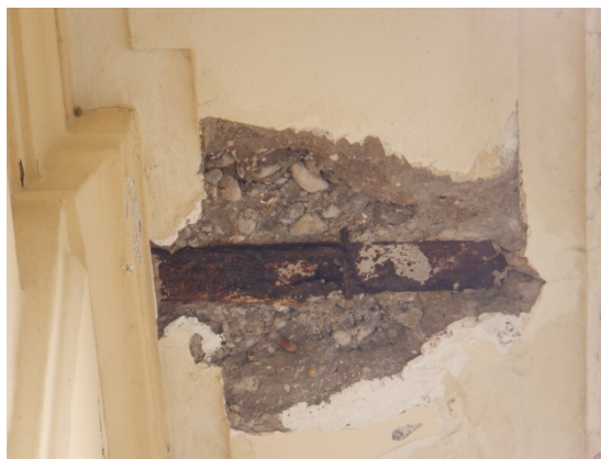
Détail de la poutrelle corrodée du balcon
