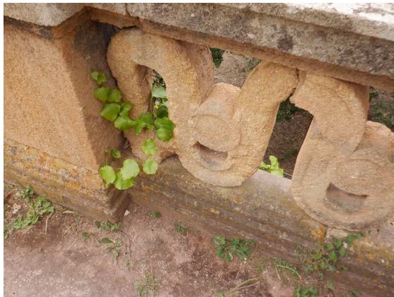
Érosion des barreaudages
