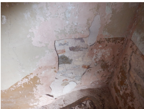
Vue rapprochée écroulement sur voile
