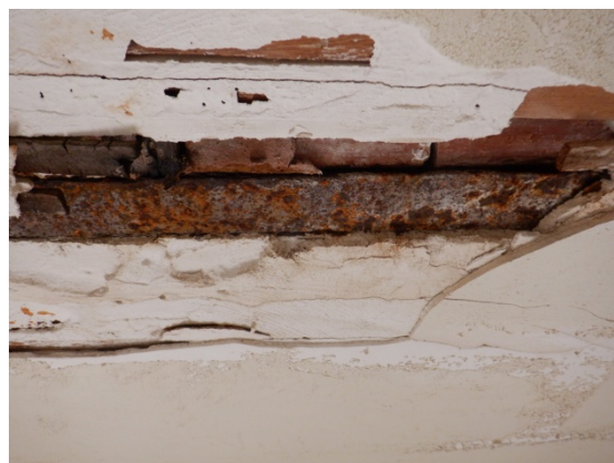
Vue rapprochée poutrelle oxydée
