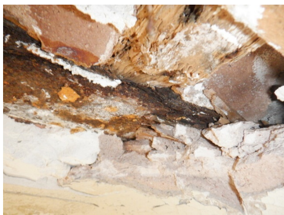
Vue rapprochée encastrement poutrelle
