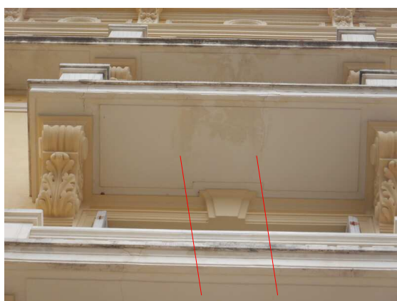
Fissures transversales en sous-face d'un balcon
