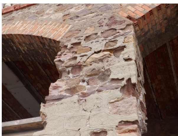
Vue rapprochée écroutage sur arche
