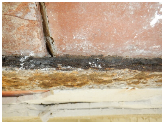
Vue rapprochée poutrelle en partie courante
