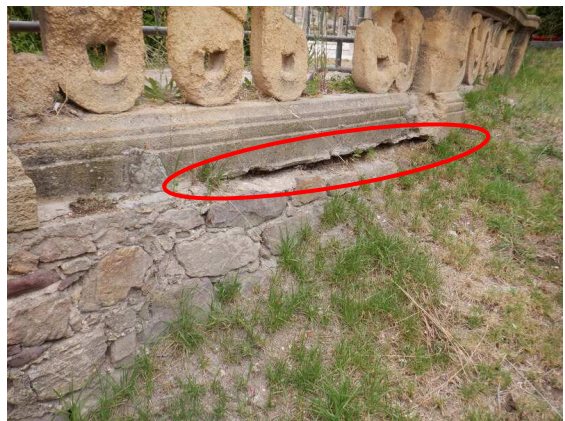
Léger affouillement côté EST du mur de soutènement
