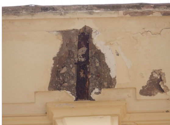
Détail de l'éclat de béton du balcon
