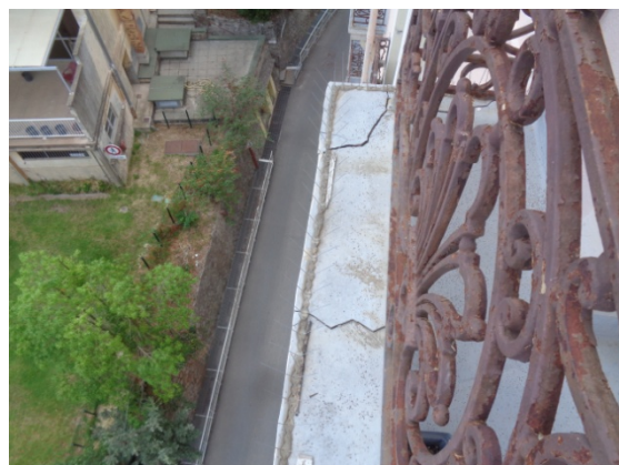
Vue rapprochée éclat béton sur balcon
