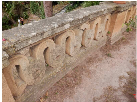
Érosion des barreaudages
