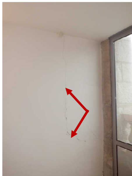
Vue générale fissure verticale et horizontale
