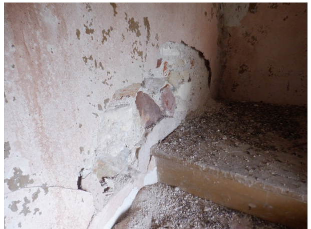
Vue rapprochée écroulement sur voile
