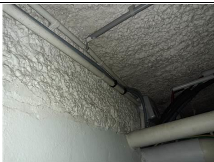
Photo n° PhA016 Localisation : Sous-Sol - Local 45 Ouvrage : 3 - Parois verticales intérieures - Murs et cloisons maçonnés Partie d'ouvrage : Flocage Description : Enduit projeté brut en partie haute du mur
