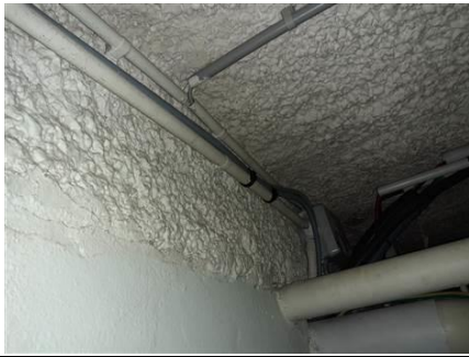
Photo n° PhA016 Localisation : Sous-Sol - Local 45 Ouvrage : 3 - Parois verticales intérieures - Murs et cloisons maçonneries Partie d'ouvrage : Flocage Description : Enduit projeté brut en partie haute du mur
