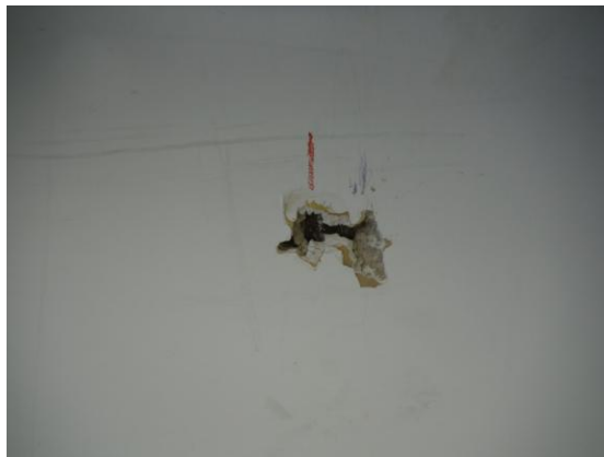
Fig. 108 : ouverture sur poutelle en sous-face de la dalle avec épaisseur de plâtre de 20 mm
