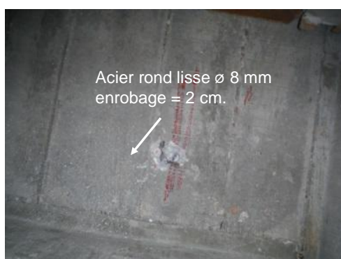
Fig. 42 : ouverture sur acier en sous-face de la dalle
