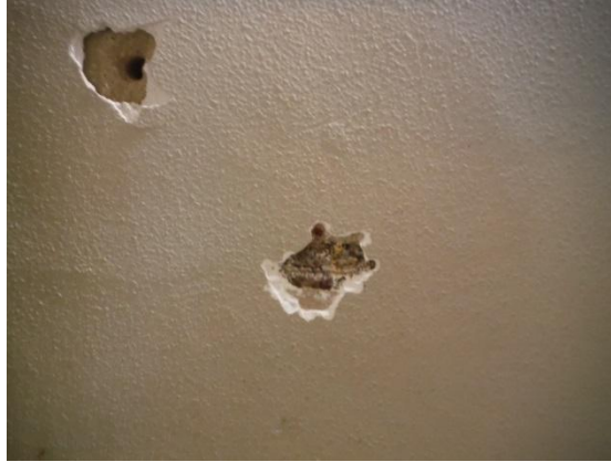
Fig. 104 : couche de plâtre de 11 mm recouvre les poutrelles métalliques
