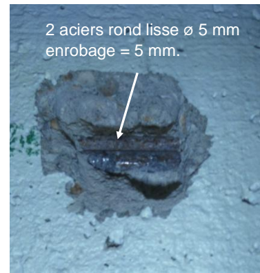
Fig. 51 : ouverture sur aciers au niveau de la contre marche d'un gradin
