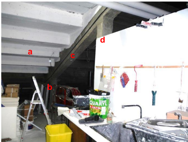
Fig. 47 : visualisation des éléments auscultés notés de a à d, en sous face de gradins (b et d sont des poteaux, c une poutre)
