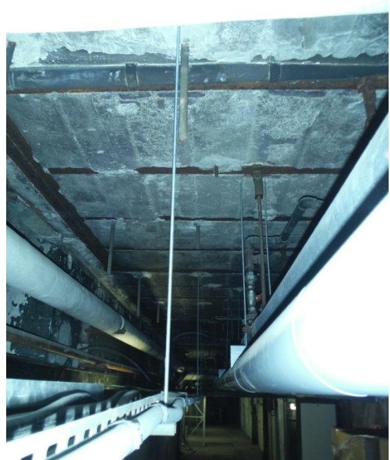
Fig. 102 : poutrelles métalliques apparentes sur la quasi-totalité du couloir
