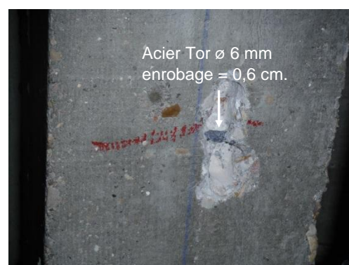
Fig. 64 : ouverture sur aciers en sous-face de la poutre
