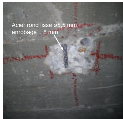
Fig. 17 : ouverture réalisée en sous-face de dalle
