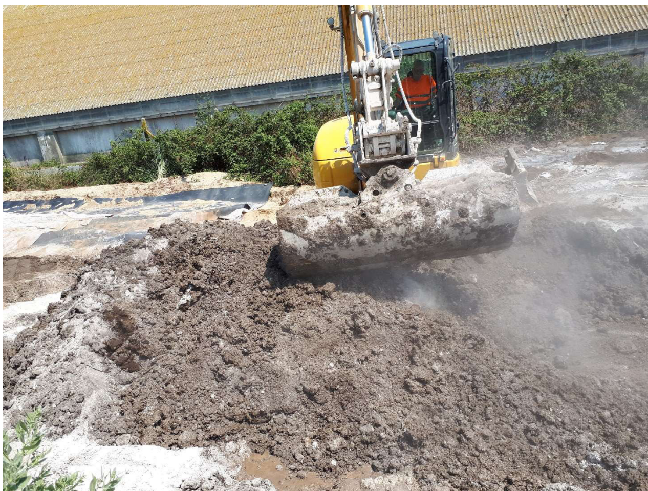
Figure 11 : Photographie de la cunette de mélange
