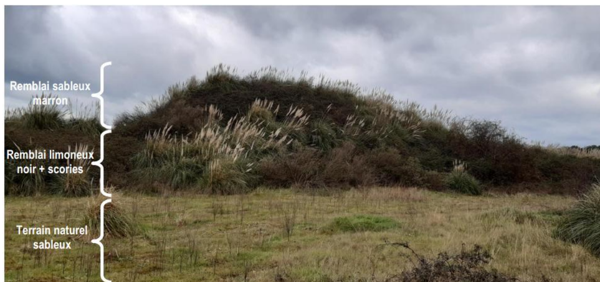
Figure 5 : Illustration de la stratification des terrains (APAVE 2022)
