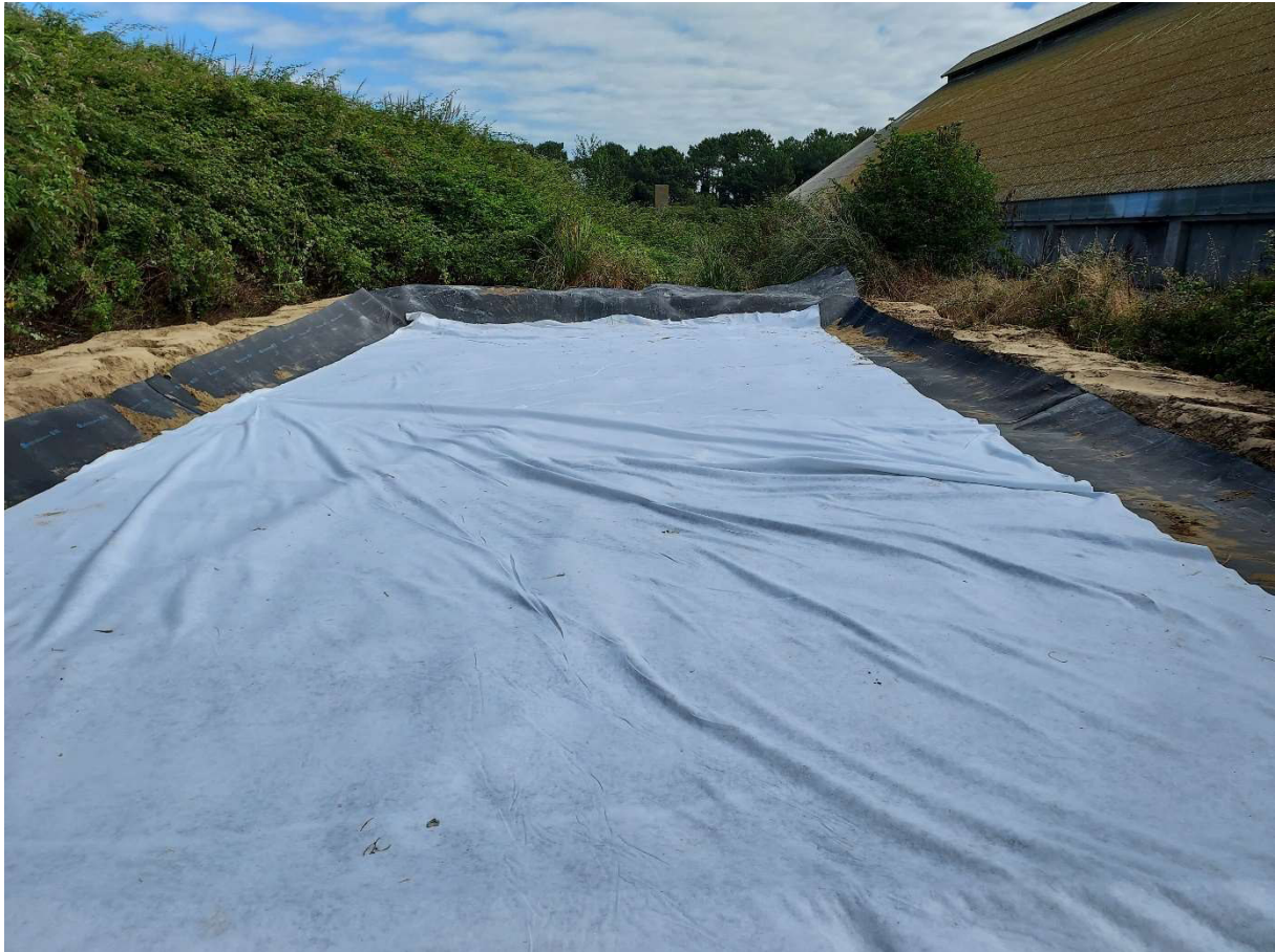
Figure 6 : Photographie de l'aire de travail étanche
