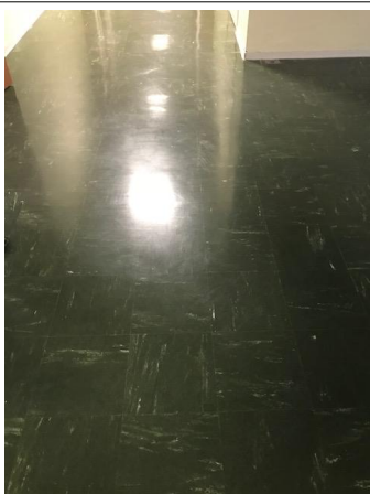
Déclaré - D1 : RDC - Dalle de sol - EP- (Présence d'amiante)
