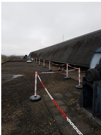
Prélèvement - P1 : toiture - Ardoise- (Absence d'amiante)
