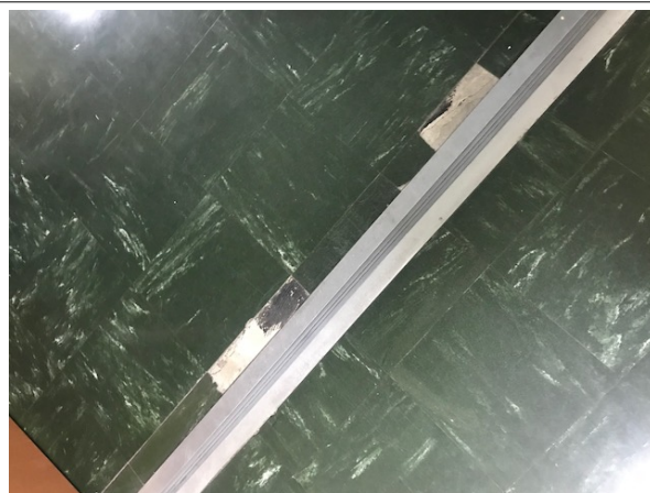
Déclaré - D2 : RDC / CIRCULATION - Dalle de sol - AC1- (Présence d'amiante)
