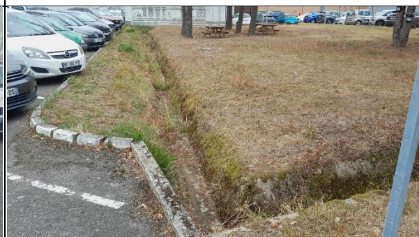
Fossé EP au niveau du parking : exutoire vers le fossé de bord de route extérieur au site
