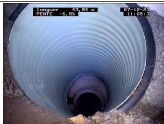
Modification de la section et des matériaux à l'extrémité nord du fossé béton (conduite PEHD en forte pente)
