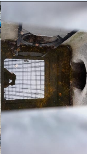
Regard de connexion rejets EP du bâtiment 131 et des voiries associées équipé d'une vanne guillotine
