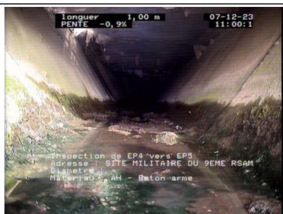
Section aval du fossé béton sous le bâtiment 052
