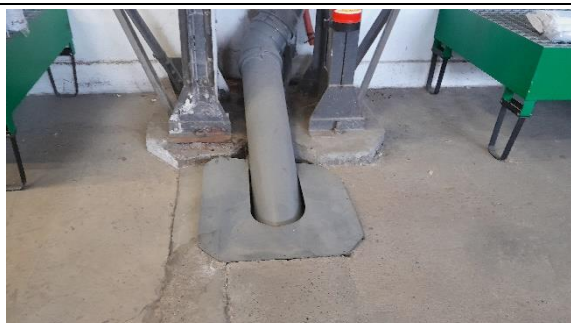
Descente de toiture dans l'atelier en amont du regard béton
