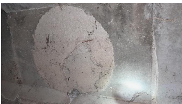
Ancien raccordement condamné (plaque polystyrène en cours de dégradation)
