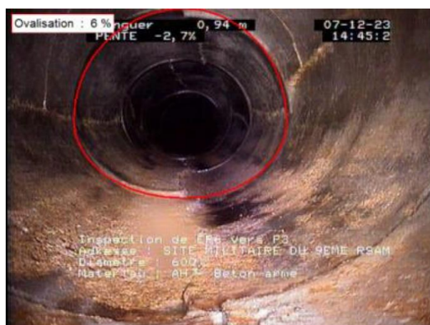
Figure 13. Déformation de la conduite béton 600mm inspectée
