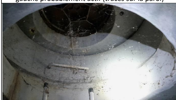
Regard Nord sur le dalot localisé au niveau du coude. Tampon non retrouvé en surface
