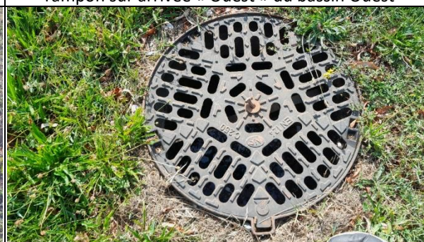
Grille avaloir sur drain enterré en fond du bassin Ouest (114) : permet le remplissage du bassin par remontée d'eau et sa vidange
