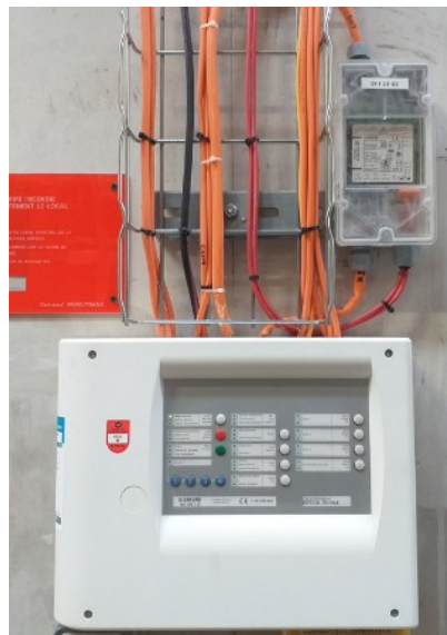
Centrale Système d'extinction automatique
