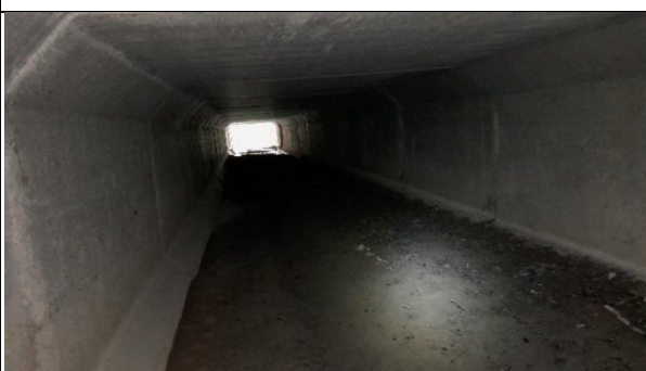
Dépôts sédimentaires sur la partie aval du dalot (à partir du coude jusqu'à l'exutoire) avec des épaisseurs de l'ordre de 10 cm
