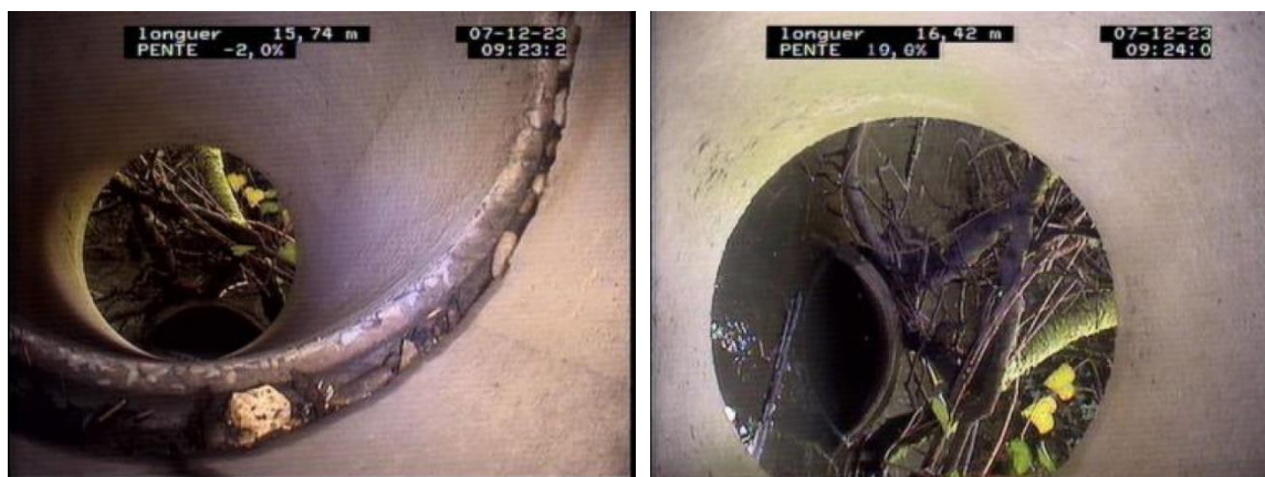
Figure 12. Extrémité de la conduite de rejet au sud-est vers le fossé du petit Merdagnou (élément désassemblé en cours de basculement et élément dans le fossé)
