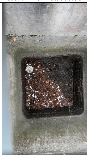
Ouvrage écrêteur sortie bassin 114 : fosse en amont de l'ajutage (fosse colmatée limitant l'écoulement par l'ajutage et limitant la vidange du bassin)
