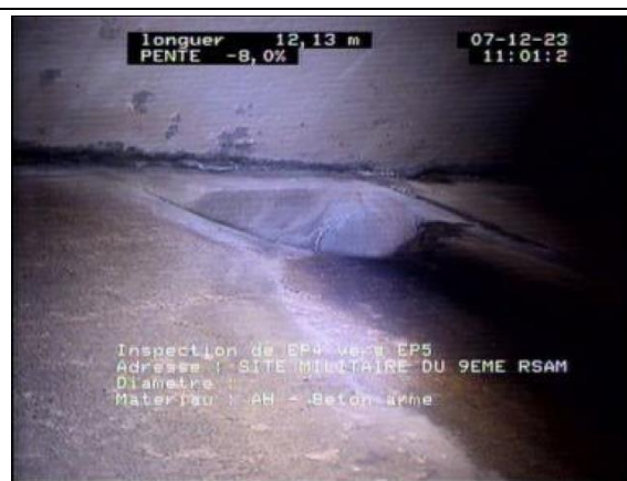
Raccordement latéral n°1 côté gauche sur le fossé béton
