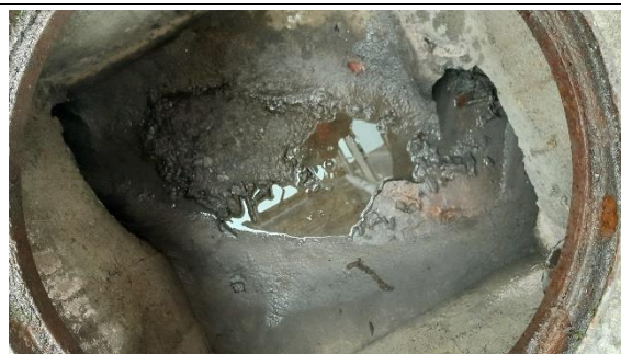
Regard en aval à la sortie du bâtiment : arrivée 300 mm + 100 mm / sortie : 200 mm
