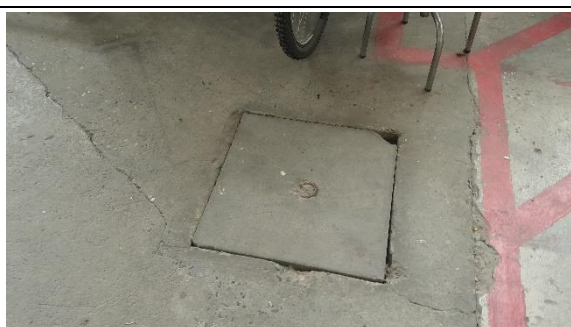
Tampon béton où ont été constatées les remontées d'eau dans l'atelier
