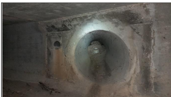
Ancien raccordement (diam. 800mm) condamné dans le dalot, au niveau du regard Nord (dans le coude). Présence d'un raccordement PVC diam. 150 mm à gauche probablement actif (traces sur la paroi)
