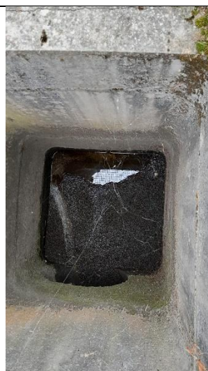
Ouvrage écrêteur sortie bassin 115 : fosse en amont de l'ajutage en bon état et seuil de surverse
