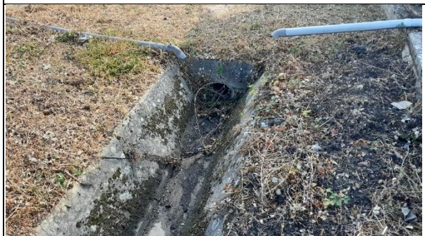
Exutoire du fossé béton au Sud du bâtiment 013 + descentes EP toiture des bâtiments 013 et 014. Conduite de rejet diamètre 400mm en béton. Rejet localisé sur le fossé du Petit Merdagnou hors site.
