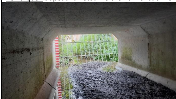
Exutoire du dalot du Petit Merdagnou au nord du site : dépôts sédimentaires et stagnation d'eau
