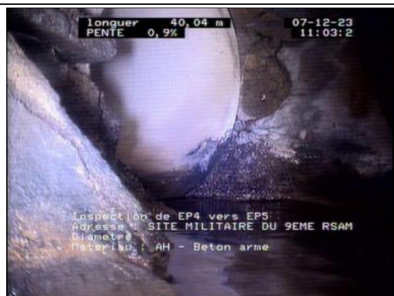
Raccordement latéral n°2 côté gauche sur le fossé béton
