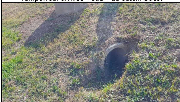
Extrémité de buse béton dans le fond du bassin Ouest (114) : probable ancienne arrivée avant travaux d'extension du bassin. Absence de connexion au réseau EP en l'état actuel.
