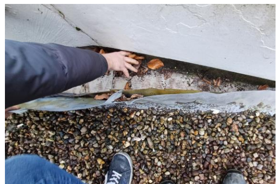
Relevé d'étanchéité dégradé
