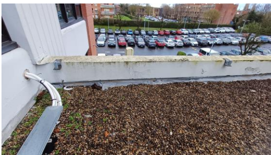
Relevé d'étanchéité dégradé
