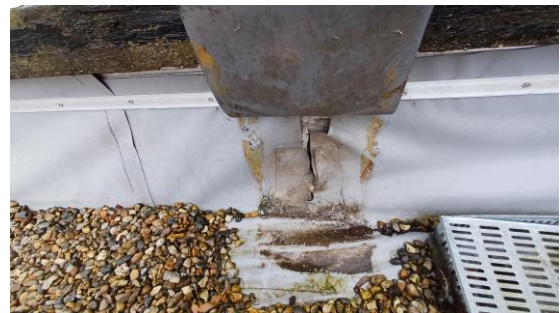
Raccord d'étanchéité dégradé
