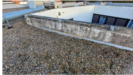
Relevé d'étanchéité dégradé
