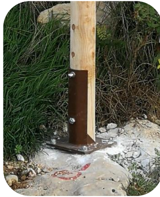
Exemple de platine « hors charte » utilisée dans le Parc national des Calanques
